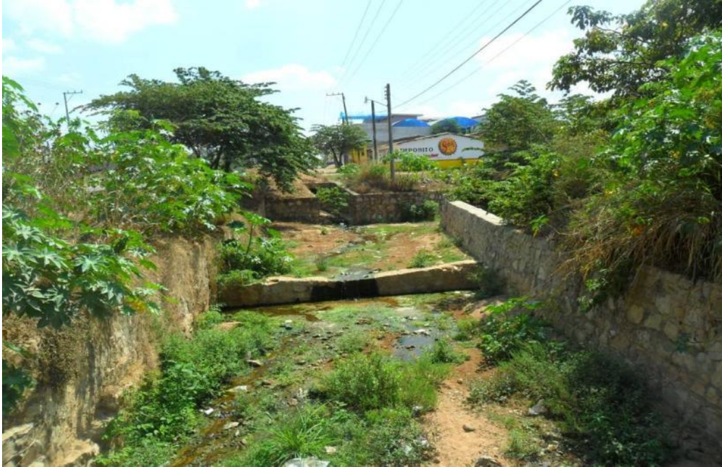
Foto 6.11 Localidad: Cintalapa. Canal que conduce el agua en época de lluvia hasta la alcantarilla que desemboca en el río Cintalapa
