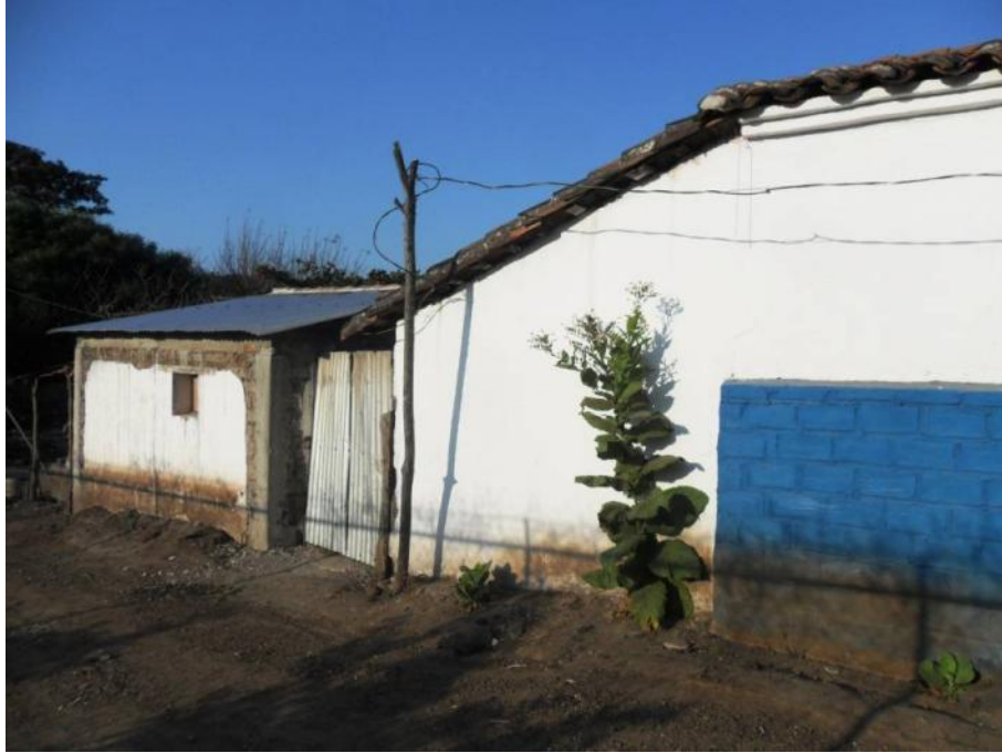
Foto 6.66 Localidad: Ocho de Enero. Vivienda de adobe con techo de teja de barro y lámina metálica.
