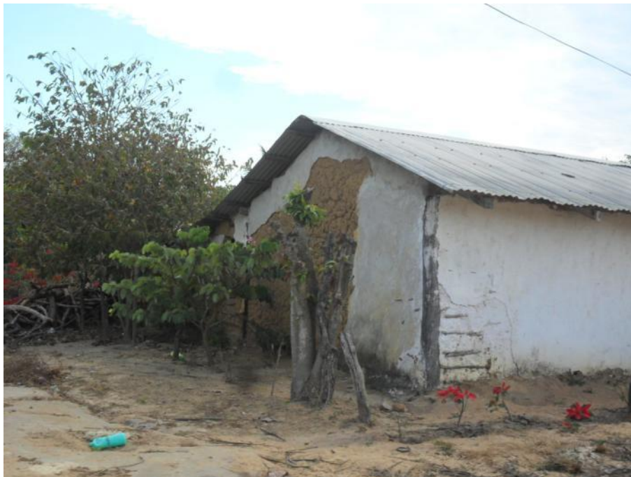
Foto 6.32 LA Asunción. La tipología de las casas de adobe, que en algunos casos son de bajareque, deterioradas por la erosión.
