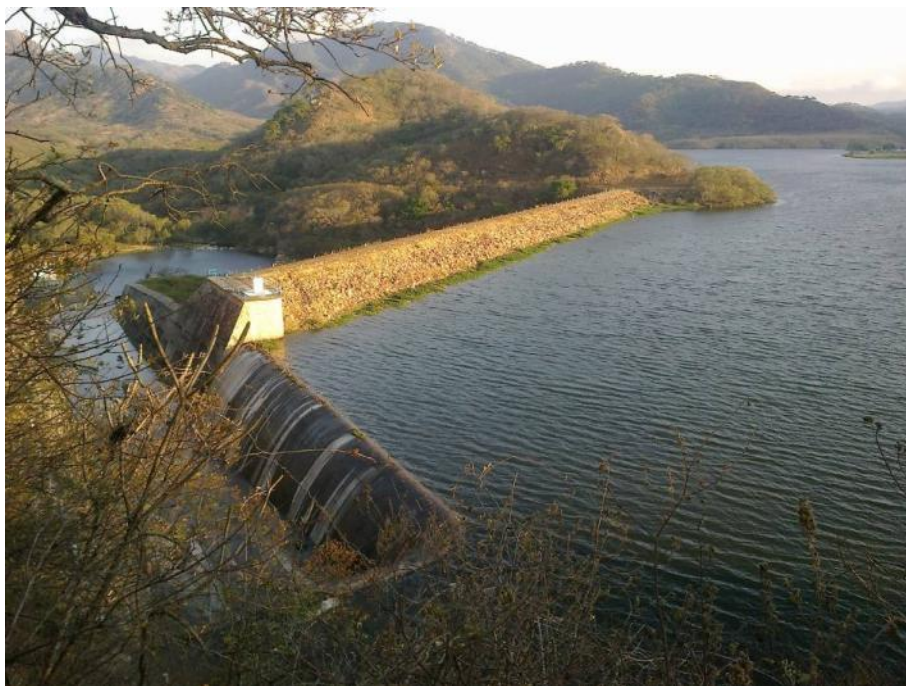
Foto 6. 63 Localidad: Presa Rosendo Salazar. Su estructura se observa en buen estado.
