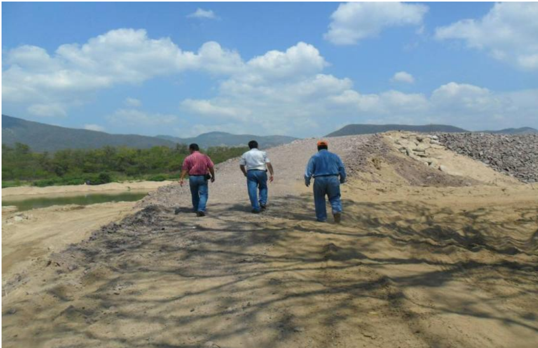
Foto 6.6 Localidad: Cintalapa. Aguas arriba de la rampa, donde dio inicio el bordo de protección en el río Cintalapa.
