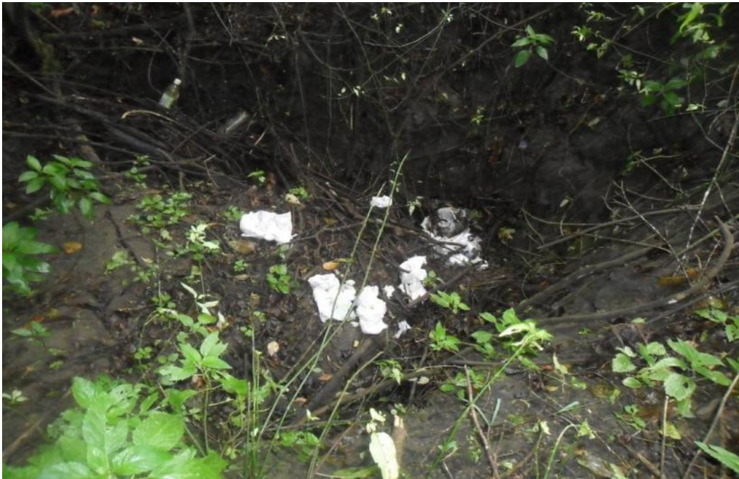
Foto 6.22 Localidad: El Mirador. Cueva geológica que se tapa y ocasiona inundaciones sobre la carretera.
