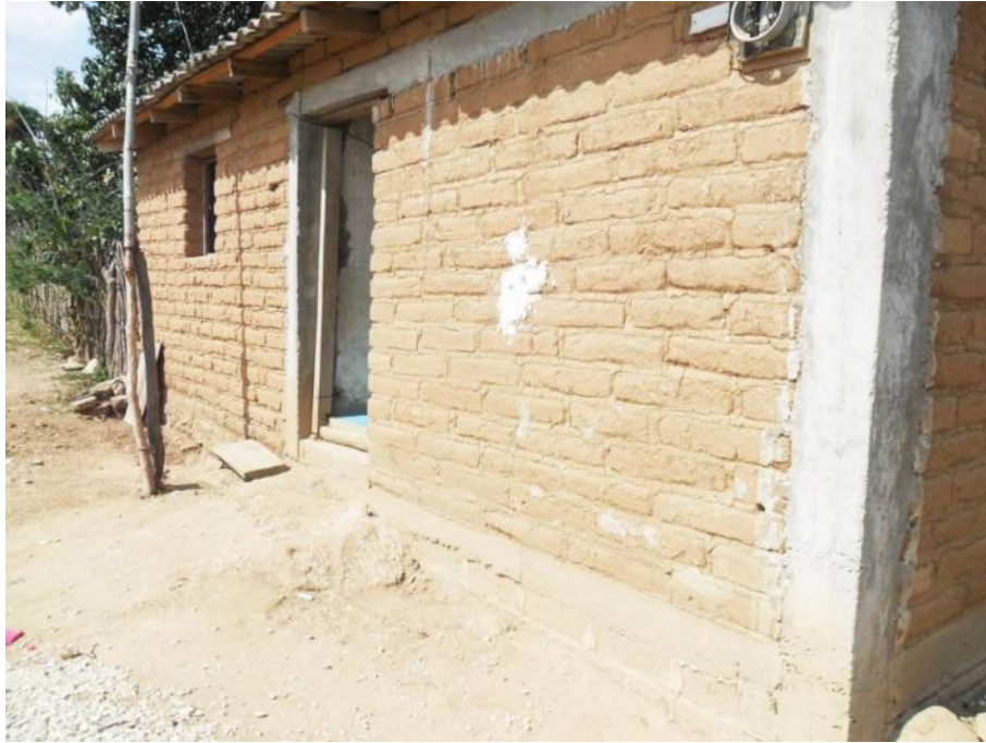
Foto 6.64 Localidad: Jacinto Tirado. Vivienda de adobe reconstruida y reforzada después de colapsarse por exceso de humedad.
