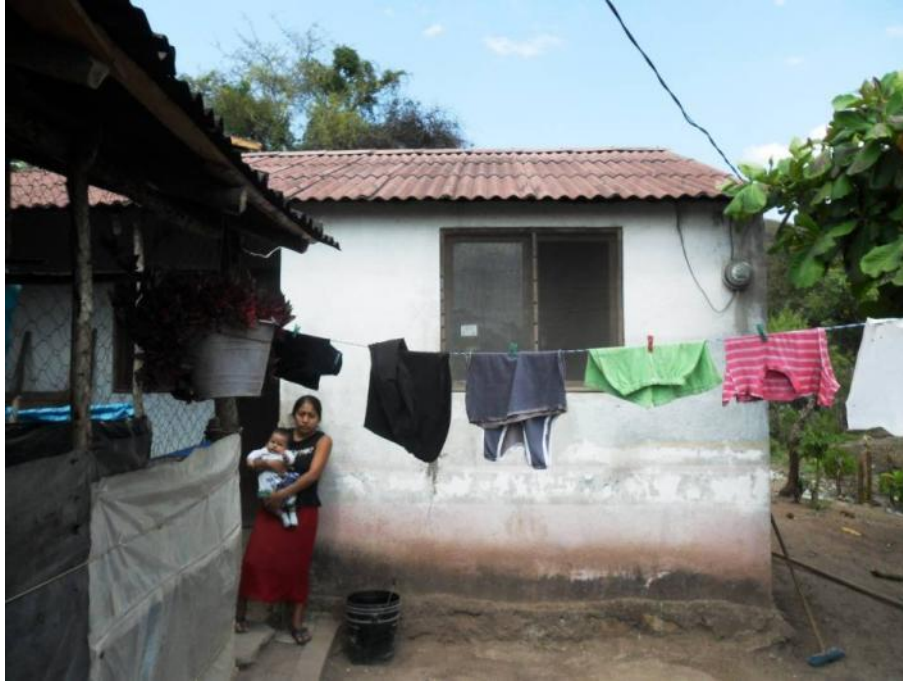
Foto 6.72 Localidad: Diez de Abril. Vivienda en peligro en caso de romperse el bordo del jagüey, construido aguas arriba.
