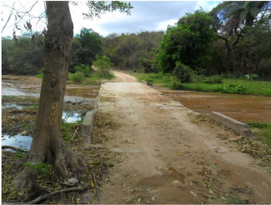
Foto 6.39 Localidad: Nuevo Coyoacán. Este vado permite el cruce del rio Tehuacán
