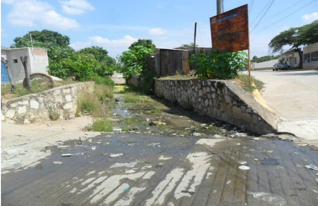
Foto 6.13 Localidad: Cintalapa. Cruce del dren en zona urbana, en época de estiaje.
