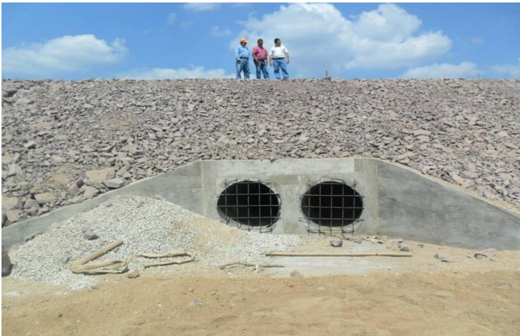
Foto 6.10 Localidad: Cintalapa. Entrada del agua pluvial proveniente de la ciudad hacia las compuertas.
