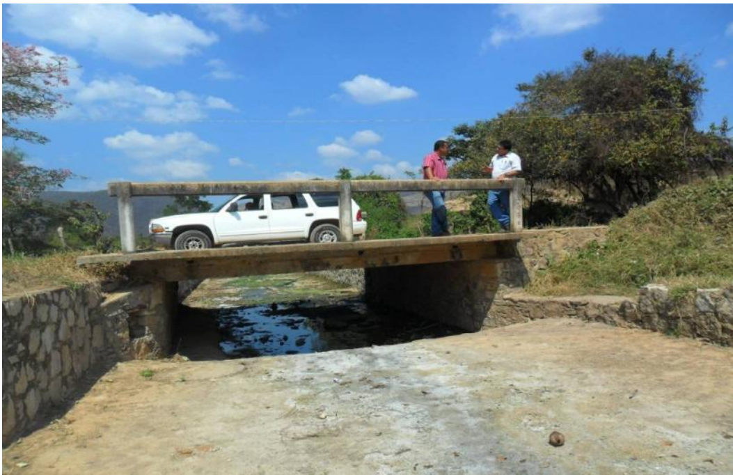
Foto 6.16 Localidad: Cintalapa. Cruce del dren a su paso por una de las calles de la ciudad.
