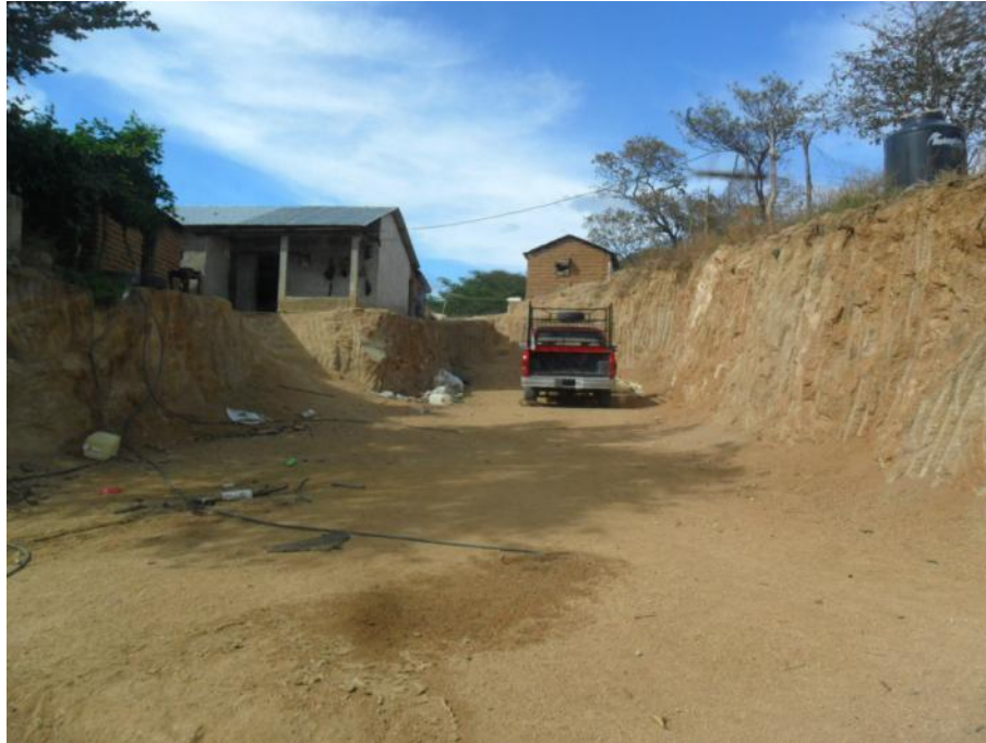
Foto 6.29 Localidad: Ing. Eloy Borrás Aguilar. Negligencia en la construcción de viviendas en las cercanías de laderas
