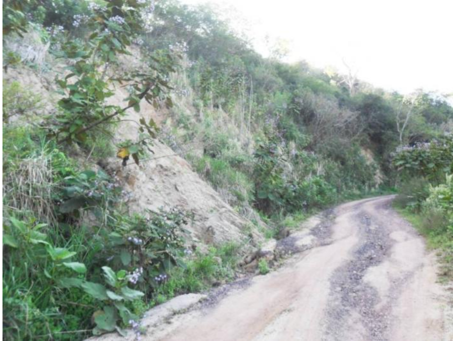
Foto 6.80 Localidad: Estoracón. Derrumbe que puede obstruir el camino antes de la comunidad Francisco I. Madero.
