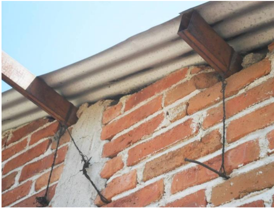
Foto 6.70 Localidad: San Luis. Anclaje del techo a los muros de la casa.
