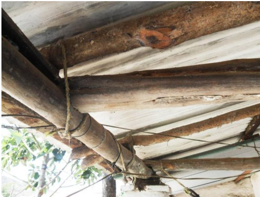
Foto 6.69 Localidad: San Luis. Anclaje del techo a los muros de la casa.
