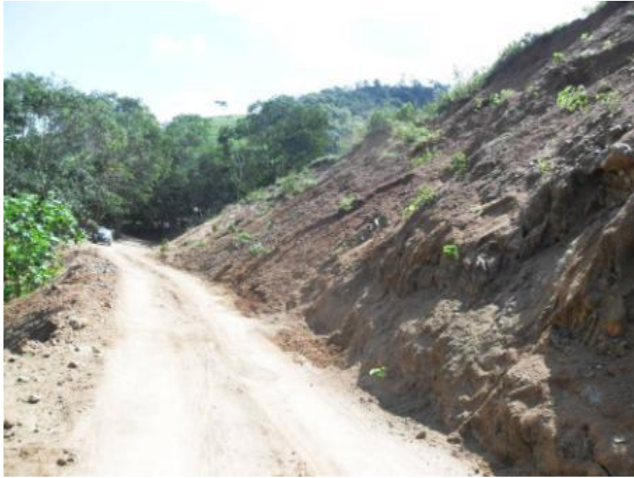
Foto 6.86 Localidad: Estoracón. Zona de derrumbes que pueden obstruir el paso de vehículos.
