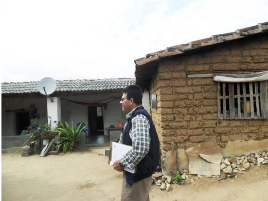
Foto 6.74 Localidad: San Sebastián. Levantamiento de cédulas de campo para determinar la vulnerabilidad física y social.
