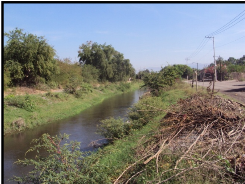
Imagen. 110 Dren Tecuanillo en la localidad de Cofradía de Morelos el cual desbordo por la crecida del cauce.
