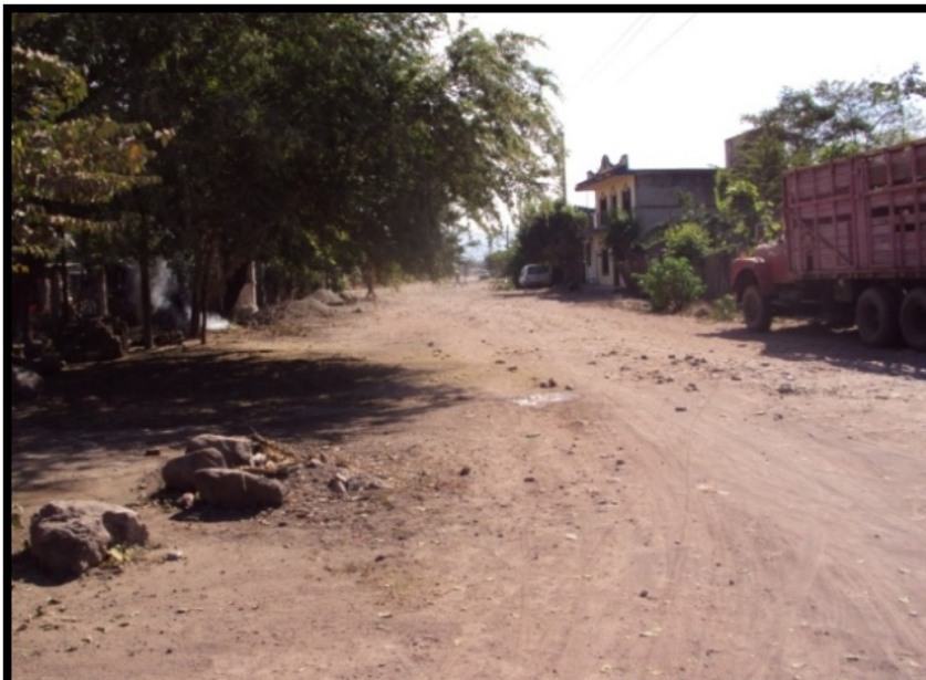
Imagen. 87 Calle 10 de Mayo y calle Cristóbal Colon, las cuales anualmente sufren de inundaciones con alturas que van desde los 50 centímetros aproximadamente, afectando las viviendas.
