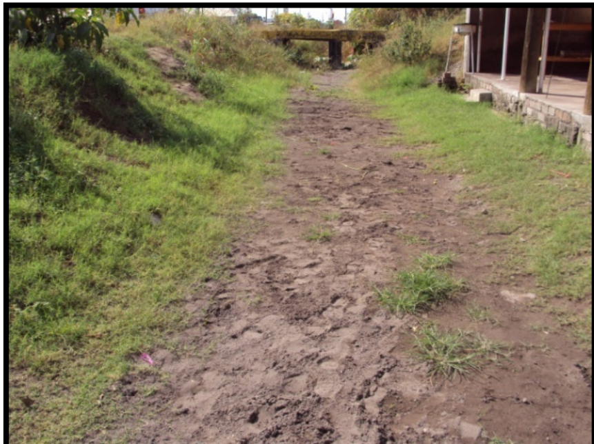
Imagen. 72 Canal donde fluyen las precipitaciones pluviales que al saturarse por escombros o basura, provoca las inundaciones en la zona.
