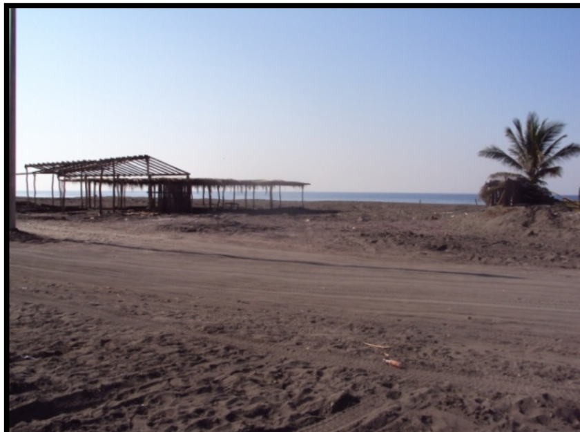
Imagen. 134 Enramadas que sufrieron estragos. Según personal de Protección Civil en esta zona se originó otra boca del río Armería llevándose consigo la arena y varias enramadas que actualmente están reubicándose.
