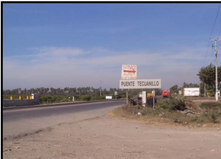
Imagen. 115 Puente el Tecuanillo, lugar donde se presentó el tapón, produciendo la saturación del cauce y por ende la inundación en Cofradía de Morelos. Este puente quedó completamente dañado al grado de restringir el acceso a vehículos de carga pesada, por el riesgo a colapsarse.
