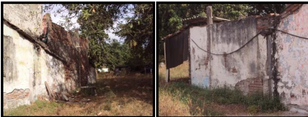
Imagen. 10 Privada que sufrió los estragos de los sismos del año de 1995 – Donde se presentaron serias afectaciones, las cuales fueron restauradas y reforzadas para continuar habitándola. 2003 – Los cuartos que comprendían esta vivienda fueron severamente afectadas declarándolas como pérdida total. Se tuvieron que demoler muros y techos.
