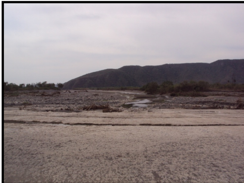
Imagen. 108 La presa de Madrid obtuvo un el tirante de agua alcanzó una altura de ocho metros aproximadamente, debido a la precipitación intensa de Octubre 2011.
