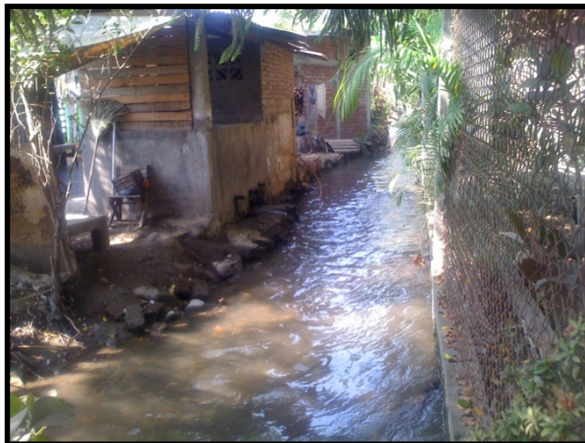
Imagen. 117 Viviendas sobre el dren ubicado en los cruces de las calles 20 de Noviembre y 5 de Febrero. En este punto anteriormente se registraron niños ahogados según el Tesorero de la Localidad.
