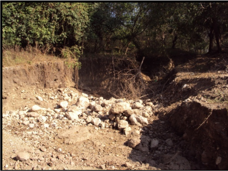
Imagen. 124 Por las fuertes corrientes de agua y la inestabilidad que posee el terreno en la localidad, se propiciaron los grandes arrastres de material que formaron parte del borde del dren. Por lo tanto, en algunas zonas el cauce del dren se incremento, hasta alcanzar una amplitud de 10 mts aproximadamenete.
