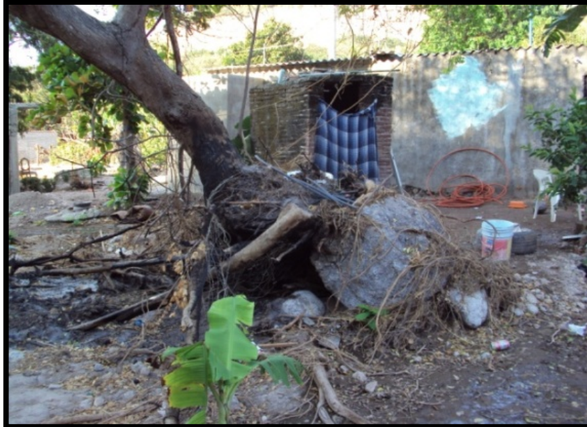
Imagen. 129 Evidencia del arrastre por la fuerza de la crecida del Arroyo Seco-La salada: trajo consigo el arrastre de los sedimentos que se encontraban sobre las faldas del cerro de San Miguel. Este material provocó daños a viviendas situadas sobre el margen del arroyo.
