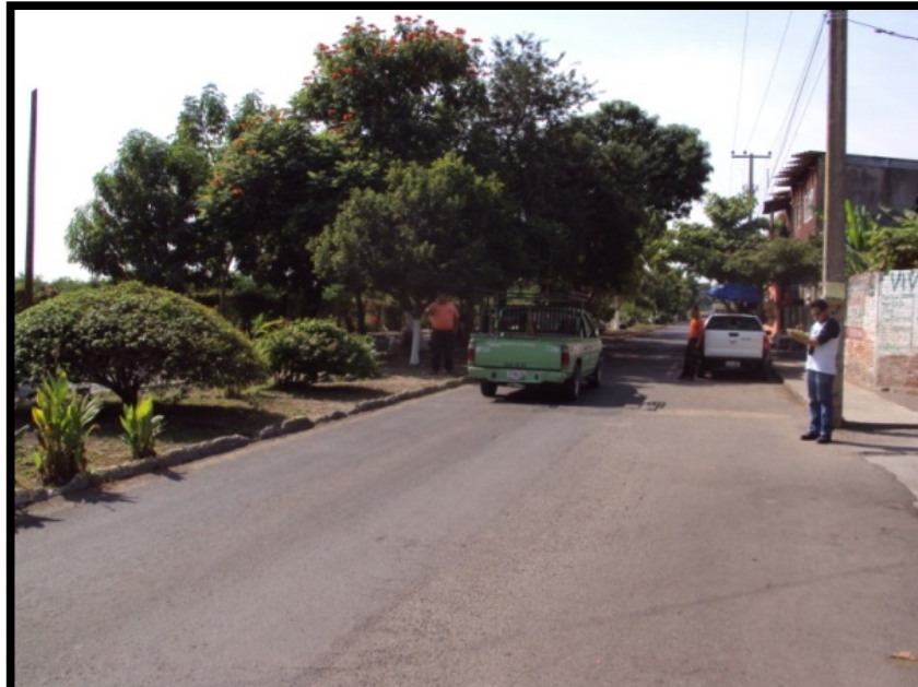
Imagen. 63 Avenida de los Maestros afectada por escurrimientos del tipo pluvial.
