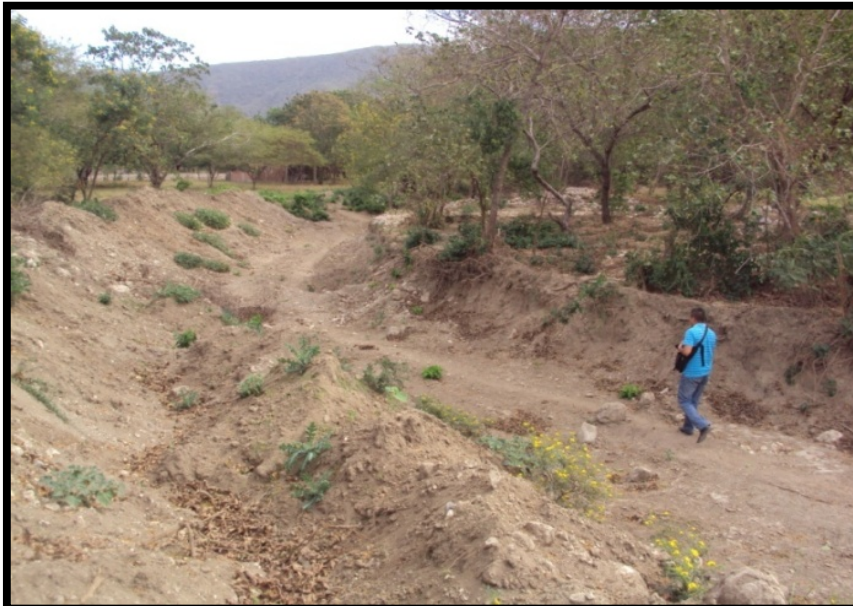
Imagen. 97 Arroyo de la localidad que presentó desbordamiento. Se necesitó el uso de maquinaria para hacer una zanja y así llevar al dren a su cauce normal.
