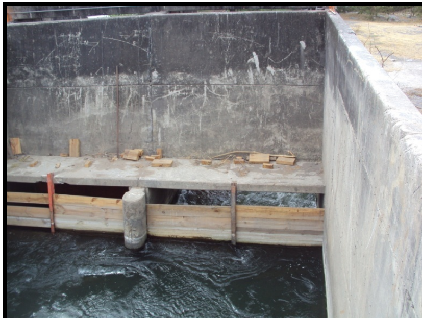
Imagen. 109 Presa de Madrid que muestra el nivel que alcanzó el agua por la crecida del torrente del río Armería: aproximadamente 8 metros de altura.
