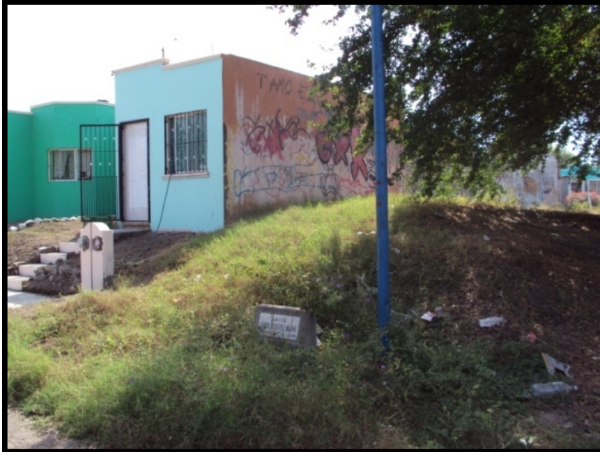
Imagen. 71 Viviendas en la Colonia Llanos de San José, construidas sobre pequeñas elevaciones que minimizan las afectaciones por inundación.
