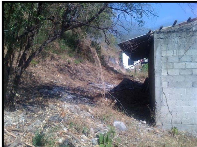
Imagen. 30 Se observan las viviendas localizadas sobre las faldas de la serranía de la localidad de Tecolapa, el cual posee un alto nivel de peligrosidad en sus laderas.
