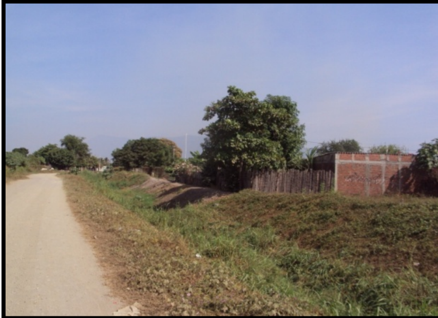
Imagen. 69 Canal ubicada sobre la lateral de la Av. de los Maestros. En ellas se muestra algunos asentamientos irregulares que se ubican a un metro del canal, representando un riesgo año con año en temporadas de lluvias. Estos asentamientos se propone reubicar (aproximadamente serán 15 familias).
