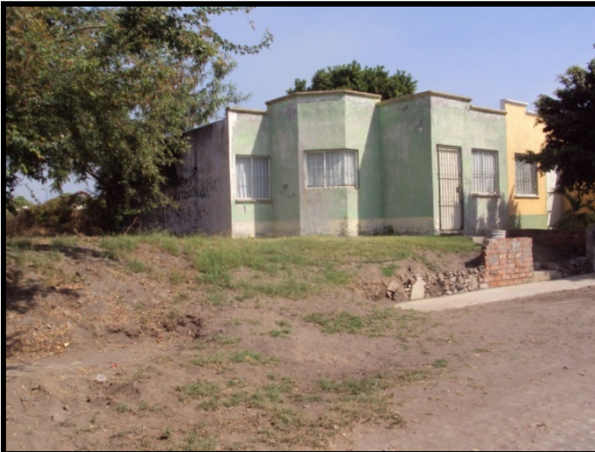
Imagen. 70 Viviendas ubicadas en las Calles Manuel Gutiérrez Nájera y Av. de los Maestros en la colonia Llanos de San José, que no presentan estragos por inundación severas en las fincas ya que se encuentran escalonadas, solo se ve afectada las vías de comunicación vial.
