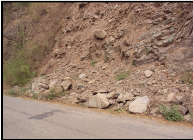
Imagen. 32 Derrumbe sobre la carretera que comunica la localidad de Madrid con las localidades de Jala-Coquimatlán. El comisario de la localidad de Madrid, Héctor Manuel de la Mora González señala que cada año esta vía se ve irrumpida por caída libre de material, principalmente en las temporadas donde se presentan precipitaciones intensas.
