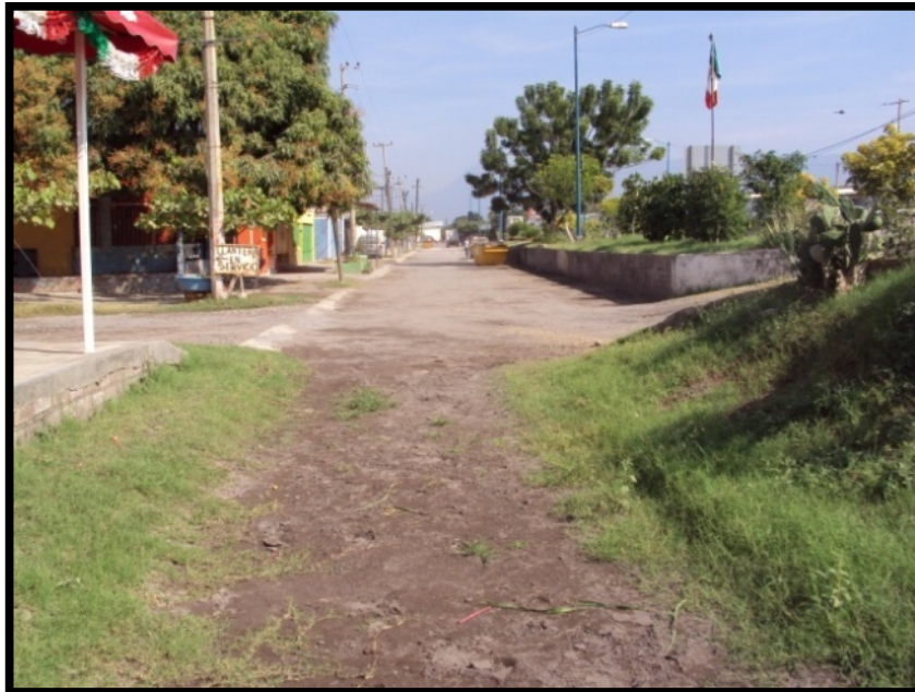
Imagen 73 Lateral de la calle Ramón Serrano donde se observan las viviendas afectadas por inundaciones.
