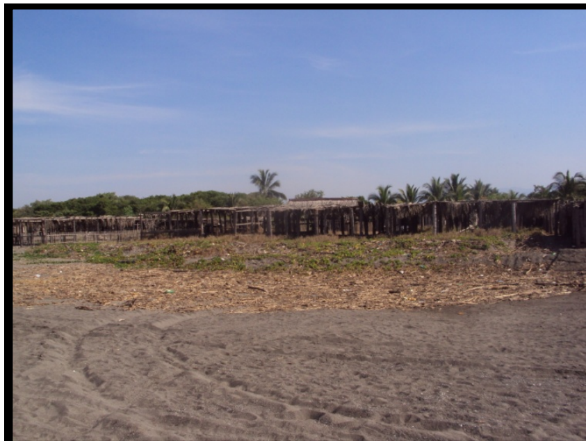
Imagen. 148 Enramadas que fueron completamente destruidas por la crecida del cauce de Coahuayana: actualmente se encuentran en reconstrucción para entrar en servicio en la temporada vacacional.
