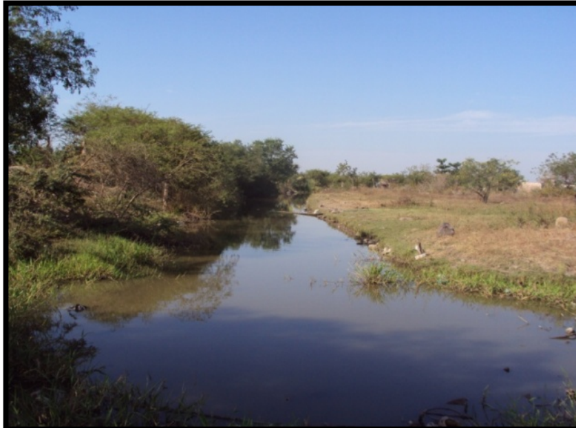
Imagen. 86 Arroyo que presenta una especie de tapón impidiendo el desagüe correcto del mismo. Por lo que simplemente se utiliza como paso a los vehículos que ingresan a las colonias irregulares.
