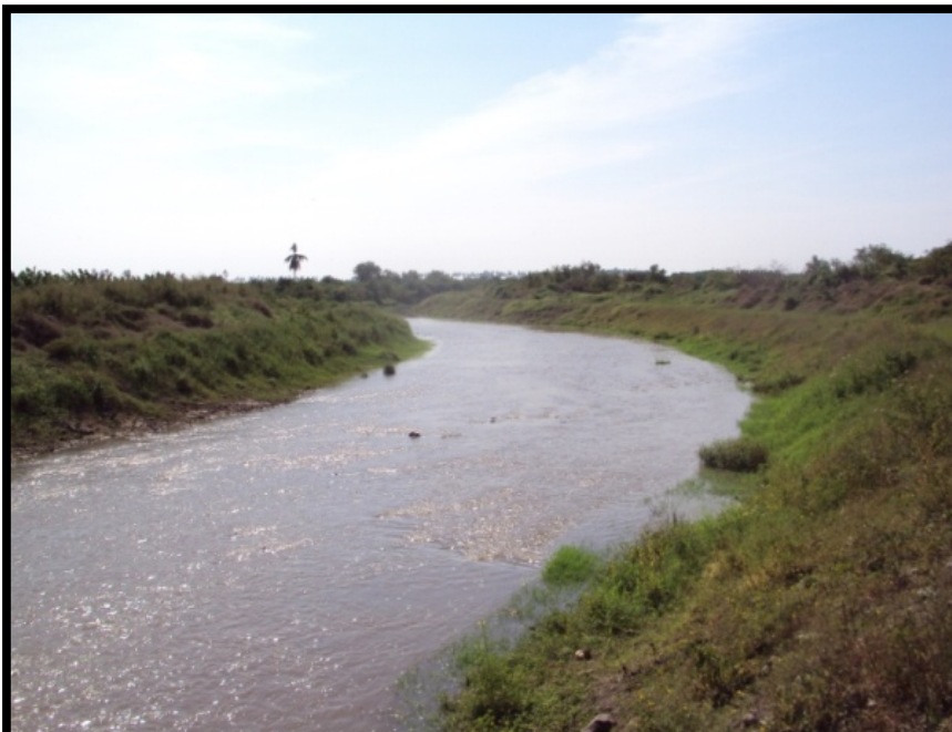
Imagen. 81 Canal o dren La Sota que presento crecidas en su caudal al punto del desbordamiento. Este canal tiene aproximadamente 20 metros de ancho.
