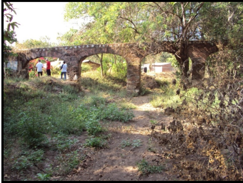
Imagen. 122 Ex hacienda localizada al Norte de la localidad de Tecolapa, lugar donde se desbordar el dren tomando salida hacia las calles de la localidad.
