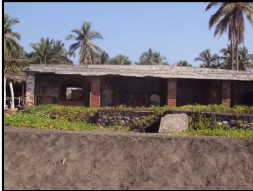
Imagen. 138 Se observa una construcción abandonada debido a las afectaciones de los fenómenos hidrometeorológicos: estas construcciones se encuentran a 30 metros tierra adentro.
