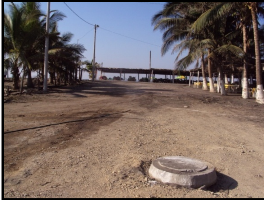
Imagen. 135 Calle dañada por el fenómeno hidrometeorológico que fue rellenada de escombros y de arena para estabilizarla.
