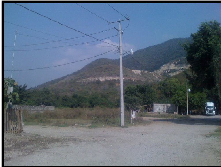
Imagen. 29 Esta figura permite apreciar el alto nivel de peligrosidad que posee la Serranía, así como también, los asentamientos que se encuentran localizados en las cercanías de las faldas del macizo.
