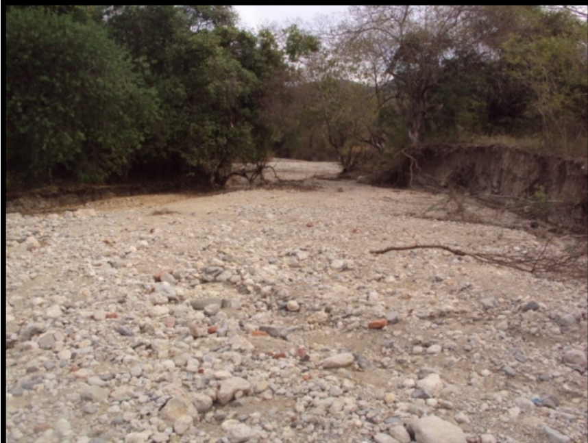
Imagen. 92 La cantidad de agua captada en el dren y el arrastre de material produjo que se saliera el cauce, afectando uno de los panteones que se localizan en este punto de la localidad.
