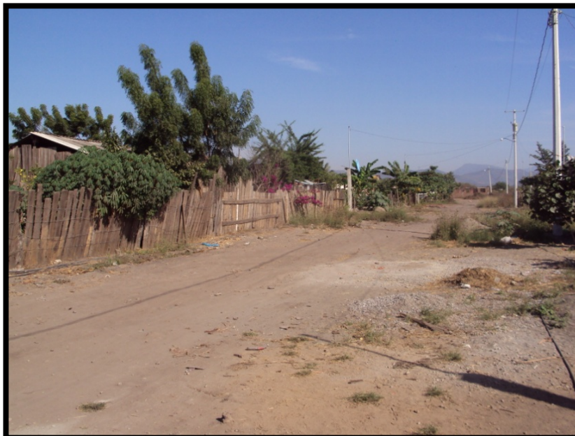
Imagen. 43 Los suelos vertisoles tienden a ser inestables al momento de poseer las cantidades de agua mínimas, por lo que se convierte en riesgo para las zonas que desarrollan cualquier tipo de construcción.
