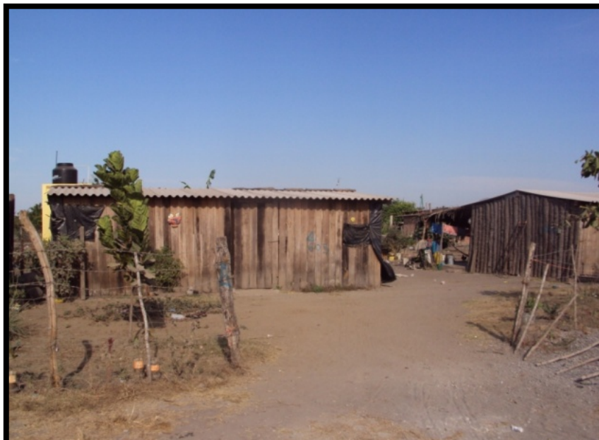
Imagen. 85 Tipo de asentamientos irregulares en la colonia San Antonio y Tecolapa. Los habitantes del lugar mencionan que el tirante de agua subió aproximadamente un metro.
