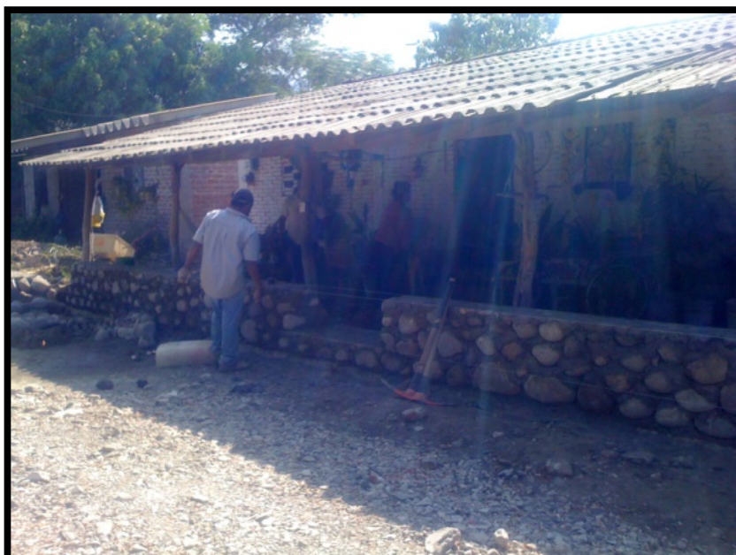
Imagen. 127 Vivienda que se encuentra localizada en la calle Santos Degollado al Sur de la localidad, donde regularmente el tirante de agua alcanza 80 cm de altura, afectando a 12 manzanas aproximadamente. Actualmente se tomaron medidas preventivas que ayuden a minimizar los estragos por precipitaciones intensas, al colocar un muro de piedra de aproximadamente 80 cm para así disminuir las afectaciones a los inmuebles.
