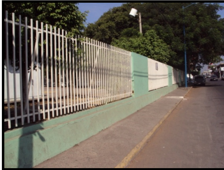
Imagen. 5 Escuela primaria Miguel Gómez Sandoval. Según personal de Protección Civil comenta que este muro colapso completamente durante la manifestación del sismo del 2003.
