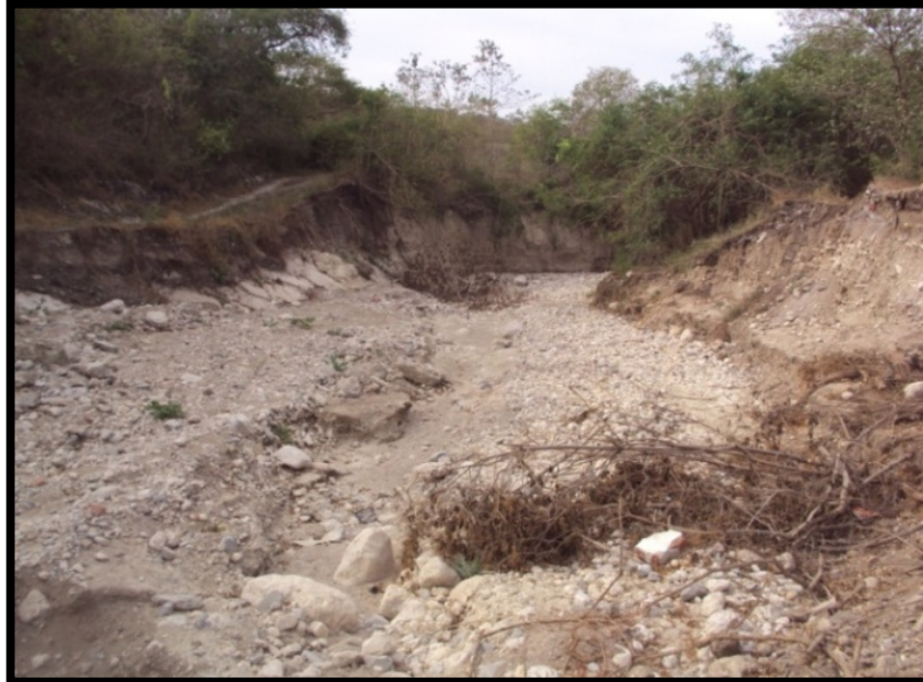
Imagen. 95 La crecida del dren que alcanzo 20 metros aproximados de ancho.
