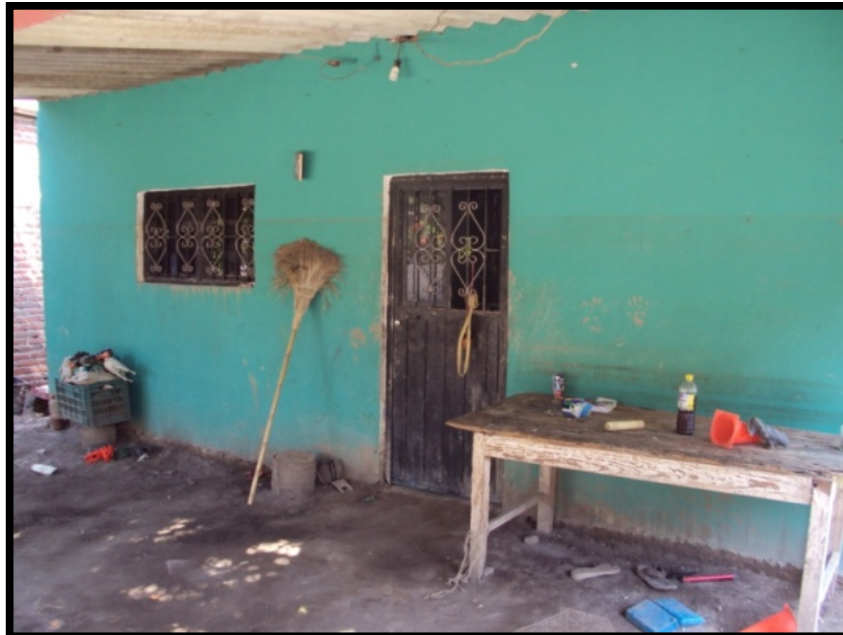
Imagen. 114 Calle Netzahualcóyotl a su cruce con José Macías Mejía, donde se muestra evidencia hasta donde llegó la altura del agua al saturarse en este punto.
