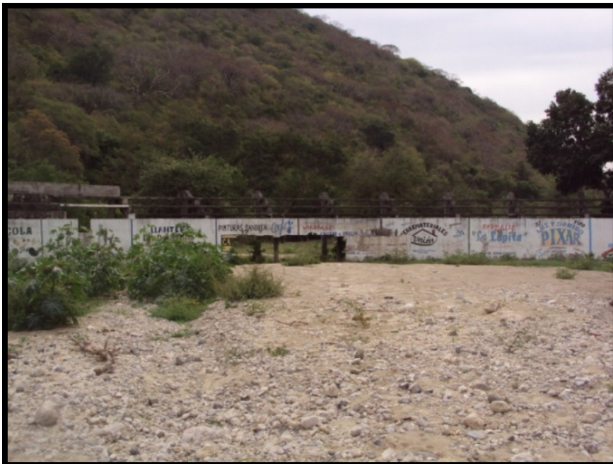
Imagen. 102 Afectaciones al interior de la plaza de toros de la localidad. El muro que se ve al fondo fue derribado por la fuerza del caudal, depositando ahí los sedimentos y el material escombros que esta llevaba.
