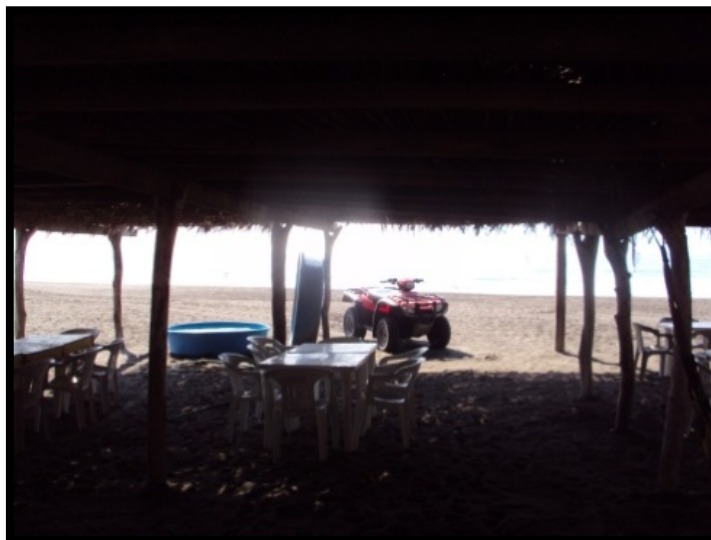
Imagen. 22 Enramadas que se vieron afectadas por el sismo en el año 2003. Los pilares que sostienen las palmas del techo de los negocios, se hundieron unos cuantos centímetros con el paso de las ondas sísmicas.
