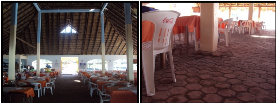
Imagen. 21 Se aprecia el negocio de la enramada La Costa Dorada Grill donde se suscitaron estragos menores en su infraestructura ante el sismo del 2003. En esta fotografía se muestra el hundimiento que presentó el piso de la enramada.
