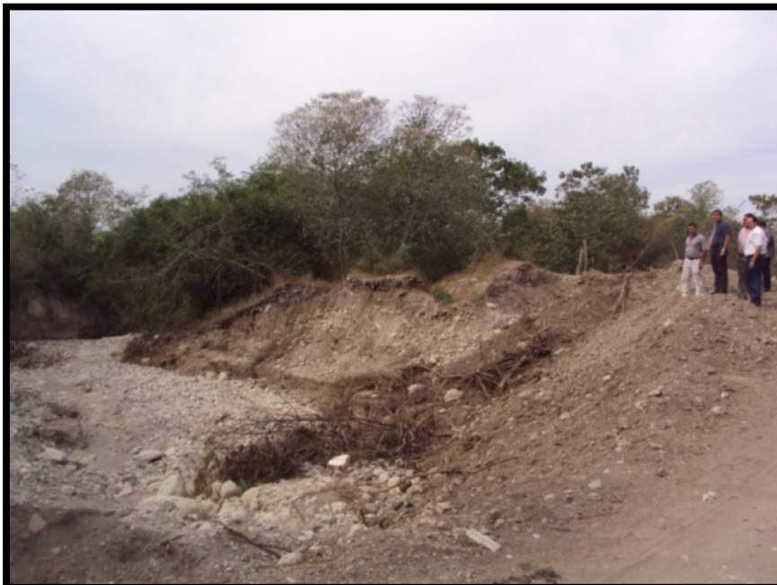
Imagen. 94 Avenida de las Américas: irrumpida por el paso del caudal intenso, destruyendo por completo esta avenida.
