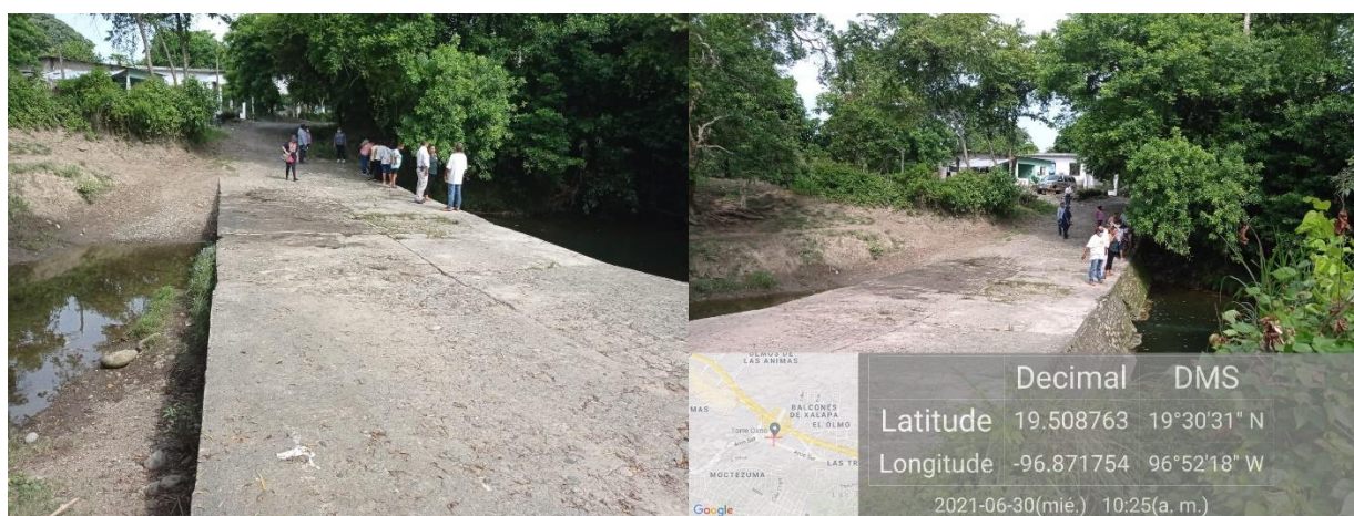
Figura 11.1.5.2 falta de limpieza y desazolve de arroyos y alcantarillas, ubicación calle Vicente Guerrero esquina Av. Ávila Camacho. Comunidad La Defensa
