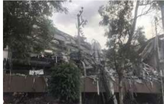
Ilustración 7 Muchos de los edificios colapsados en CDMX habían sido diseñados con reglamentos de construcción anteriores al de 1985
