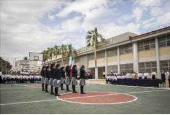
Ilustración 19 Reconstrucción de escuela primaria en Juchitán, Oaxaca, la cual fue afectada tras el sismo del 7 de septiembre
