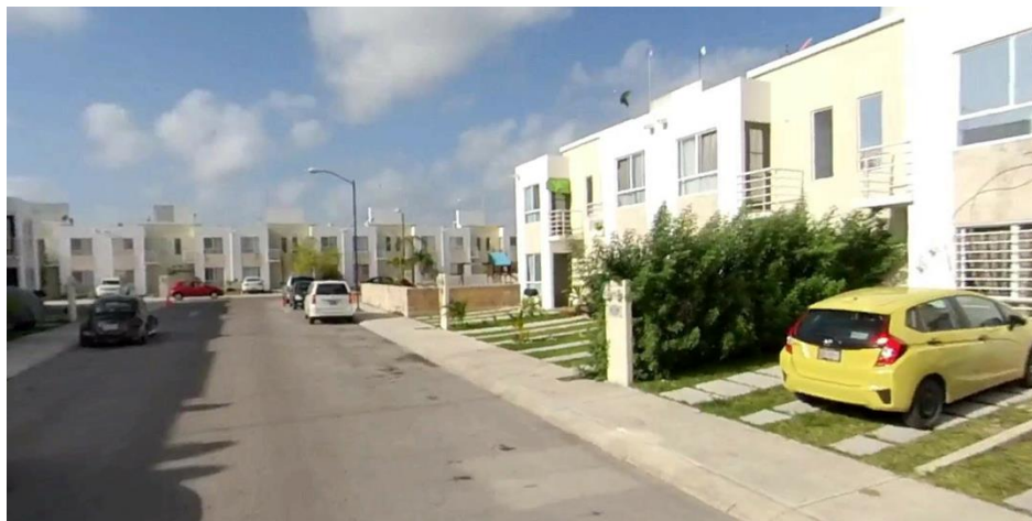
Imagen 34. Viviendas tipo IV en Las Palmas II
