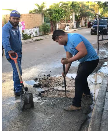
Imagen 16. Desazolve de alcantarilla por parte de habitantes de Puerto Aventuras
