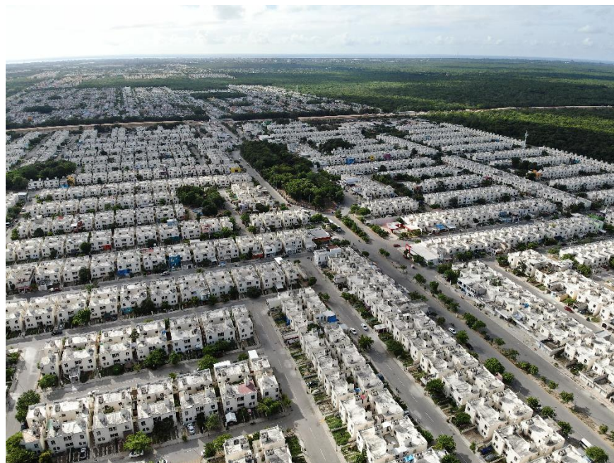
Imagen 27. Tipo de vivienda predominante en Playa del Carmen. Casas de interés social de 1 o 2 niveles con muros de mampostería y techos rígidos.
