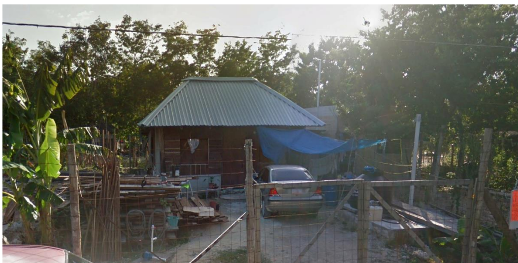
Imagen 34. Viviendas tipo II en la colonia Cristo Rey
