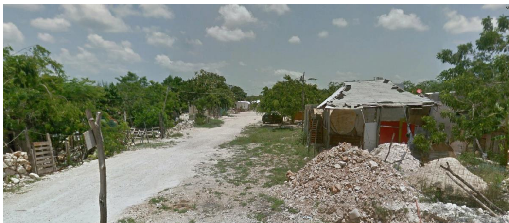
Imagen 33. Viviendas tipo I en el asentamiento irregular In-House
