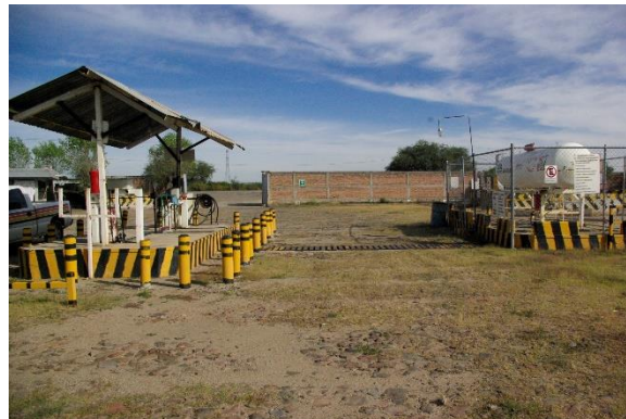
Figura 80. Estación de Gas L.P. para carburación ubicada en el municipio de Romita (Coordinación Municipal de Protección Civil, n.d.).
