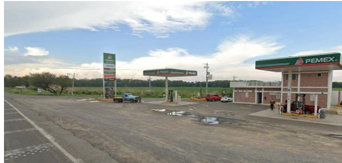
Figura 80. Estación de Servicio para almacenamiento y expendio de diésel y gasolinas ubicada en el municipio de Purísima del Rincón (Coordinación Municipal de Protección Civil, n.d.).
