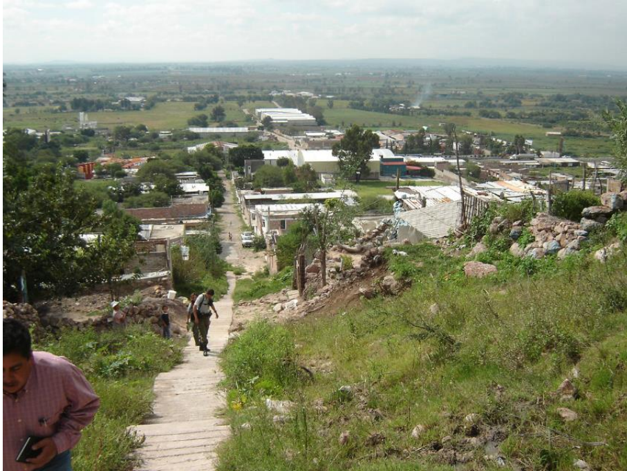
Figura 55. Ladera inestable en el cerro El Zorrillo, Colonia Campo Verde, León. Gto. Fuente: (CEPC, 2007)
