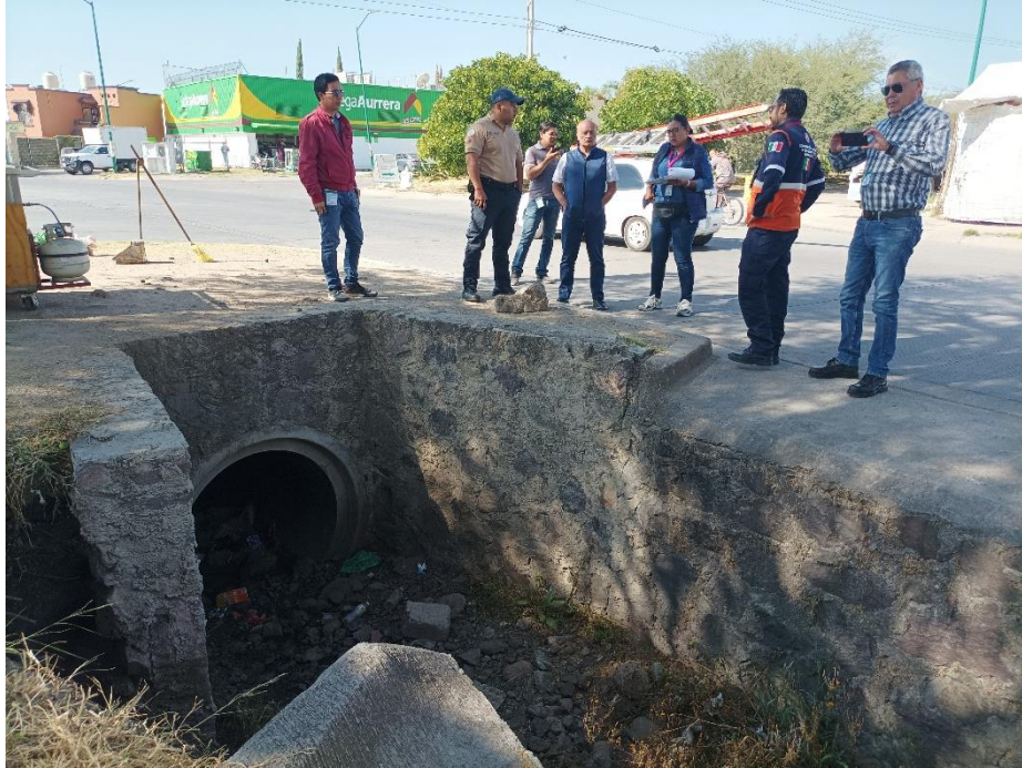
Figura 68. Recorrido de inspección y verificación a zonas de peligro y riesgo por inundación en el Fraccionamiento Brisas del Lago del municipio de León, Gto. Fuente: (CEPC, 2022)
