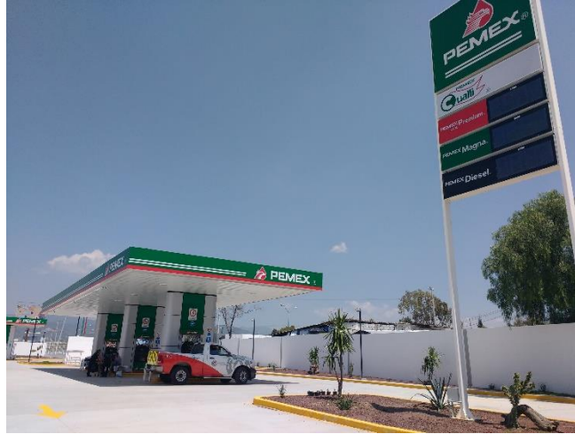
Figura 86. Estación de Servicio para almacenamiento y expendio de diésel y gasolinas ubicada en el municipio de León (Coordinación Municipal de Protección Civil, n.d.).
