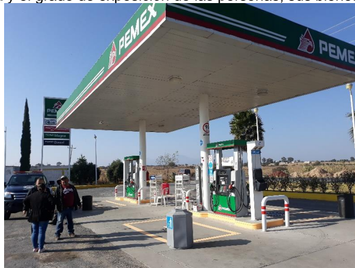
Figura 83. Estación de Servicio para almacenamiento y expendio de diésel y gasolinas ubicada en el municipio de Jerécuaro (Coordinación Municipal de Protección Civil, n.d.).
