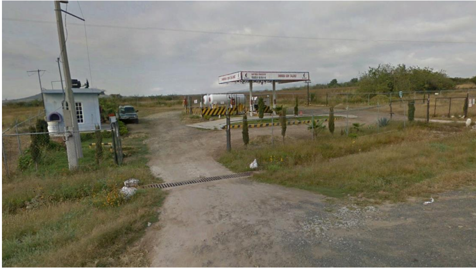
Figura 85. Estación de Gas L.P. para carburación ubicada en el municipio de Jerécuaro (Coordinación Municipal de Protección Civil, n.d.).
