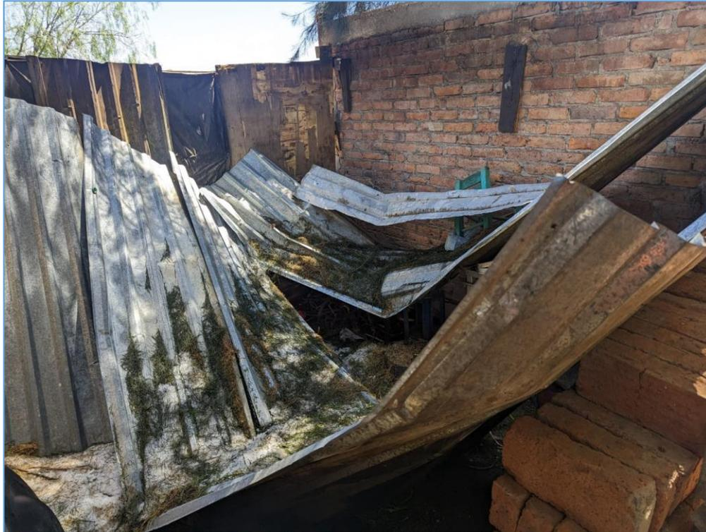
Figura 79. Techo de vivienda afectada por granizada en la Comunidad Delgado de abajo, Comonfort, Gto. Fuente: (CENAPRED, 2012).
