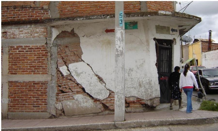
Figura 37. Vivienda expuesta a agrietamiento y subsidencia diferencial en el Estado de Guanajuato.
