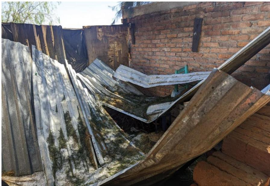
Figura 40. Afectación en techo flexible ante la exposición a granizada en el municipio de Comonfort.
