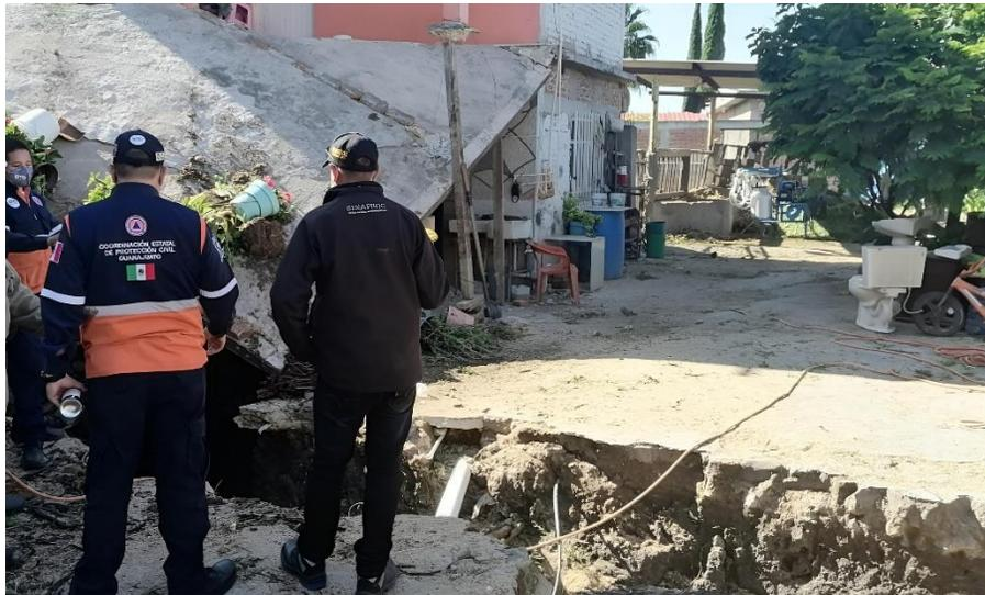
Figura 36. Afectación estructural a vivienda expuesta a agrietamientos y hundimientos diferenciales en el Estado de Guanajuato. Fuente: Gobierno del Estado de Guanajuato.
