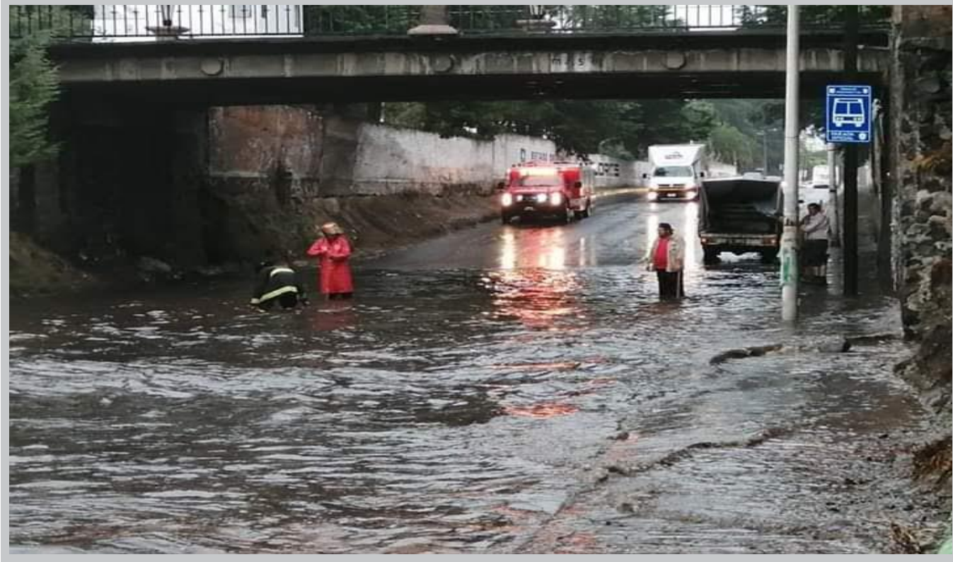
Imagen 72: Encharcamiento 2021. Fuente: Coordinación de Protección Civil y Bomberos de Metepec 2022.
