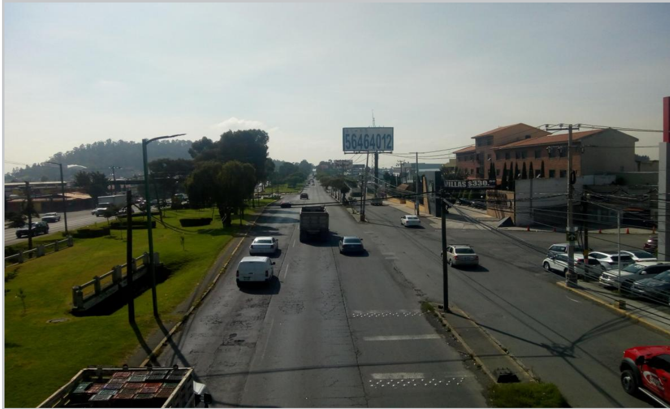
Imagen 35: Vialidad Primaria, Vía Toluca-Tenango. Fuente: Coordinación de Protección Civil y Bomberos de Metepec.
