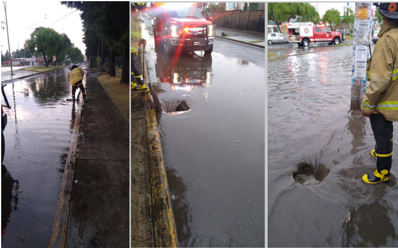
Imagen 61: Encharcamientos urbanos y liberación de coladeras. Fuente: Coordinación de Protección Civil y Bomberos de Metepec, 2022.
