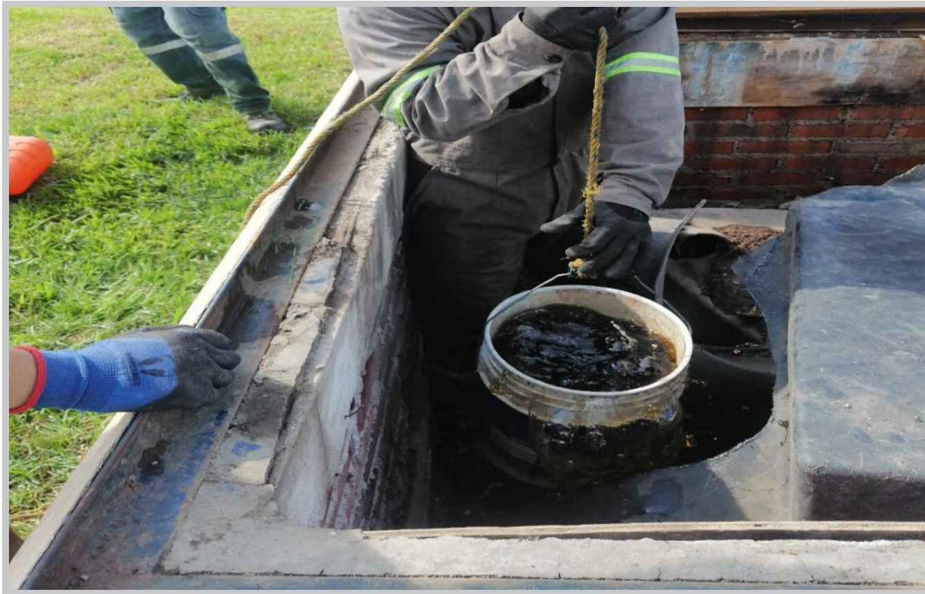
Imagen 68 :Extracción de lixiviados. Fuente: Imágenes proporcionadas por la Dirección de Servicios Públicos.
