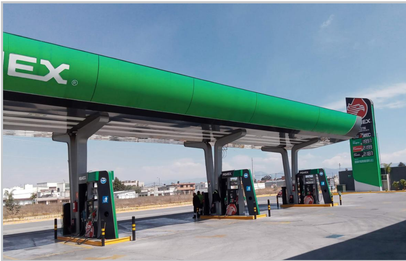
Imagen 63: Estación de Servicio.
