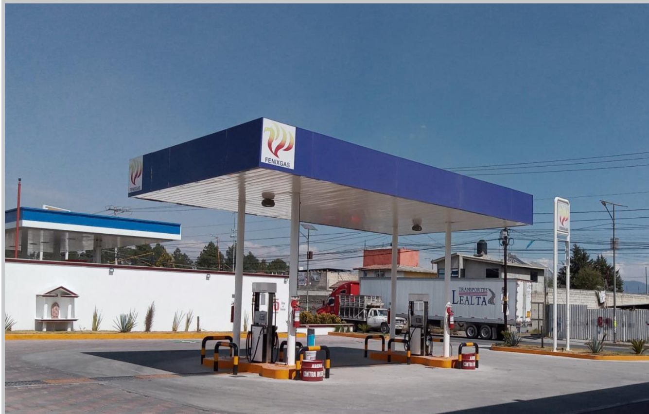
Imagen 64: Estación de Carburación. Fuente: Coordinación de Protección Civil y Bomberos de Metepec, 2022..
