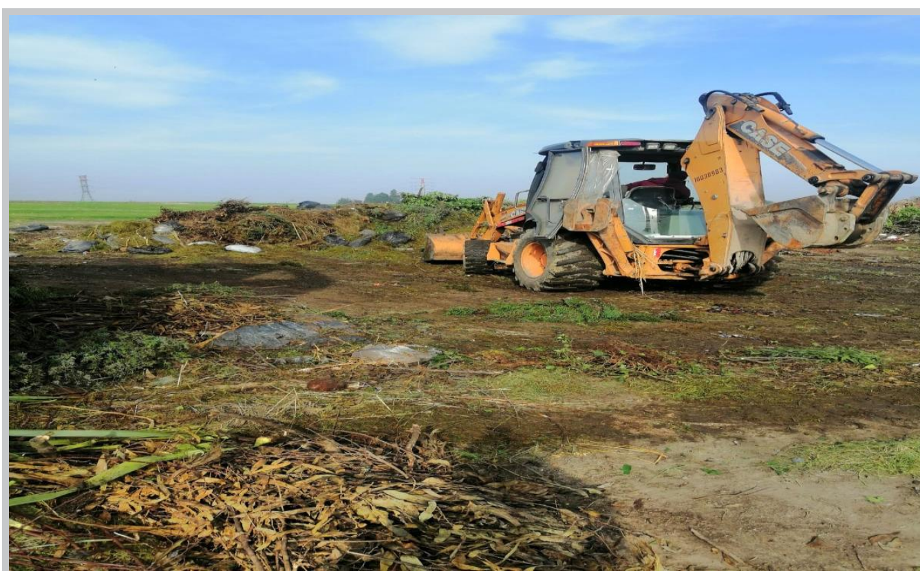
Imagen 69: Limpieza de corona del Relleno Sanitario. Fuente: Imágenes proporcionadas por la Dirección de Servicios Públicos.
