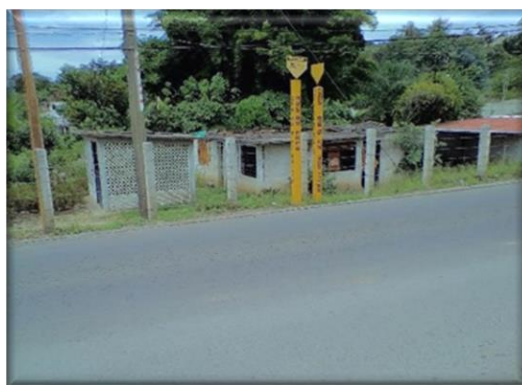
Fotografía 8.2. Ducto en El Castillo.
