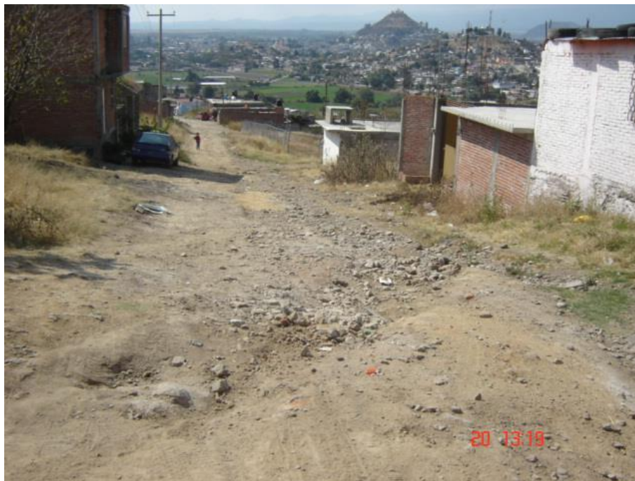
Fotografía 10.- Zona donde se producen flujos de lodo afectando a las viviendas que se ubican en las inmediaciones del calle Republicas del Perú.
