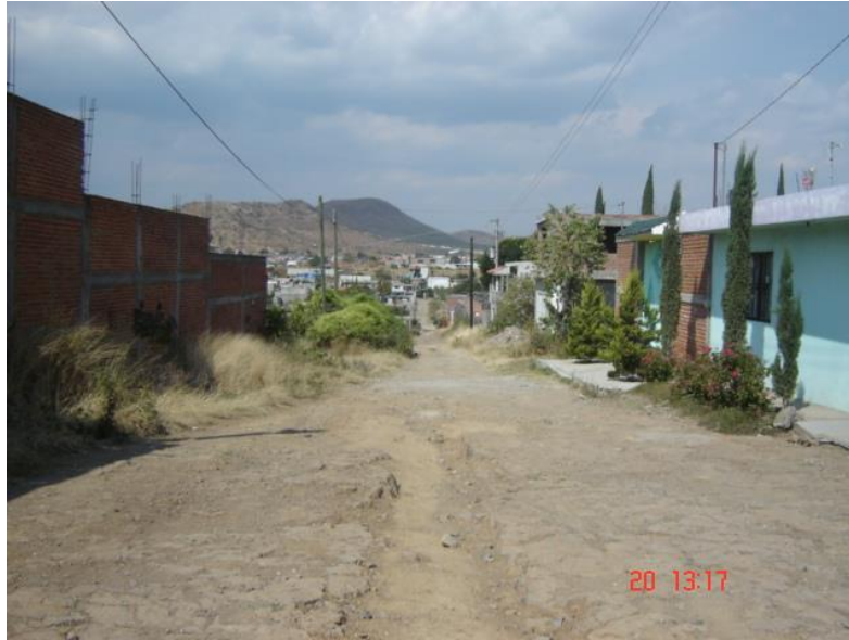
Fotografía 6.- Zona de deslizamientos en la calle Republica de Brasil.
