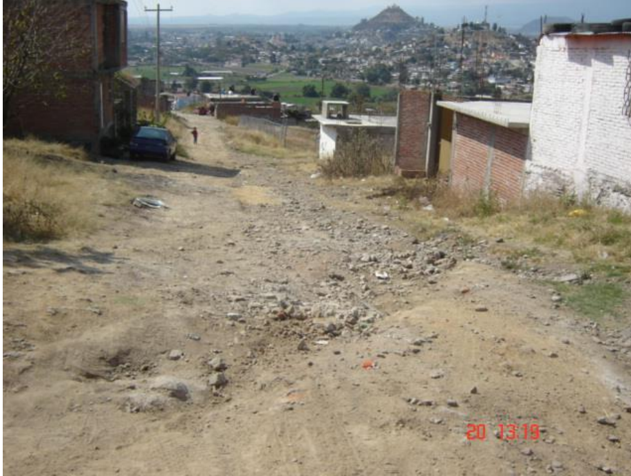
Fotografía 3 Deslizamientos de rocas y lodo en la calle Republica de Peru.
