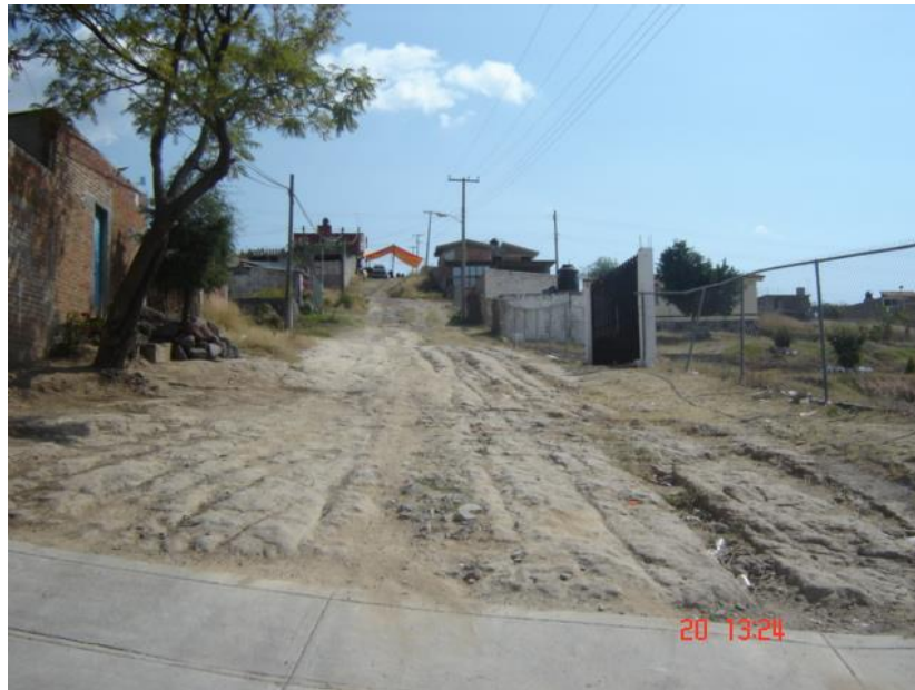
Fotografía 7. Deslizamientos de tierra y piedras en la calle Republica de Bolivia.
