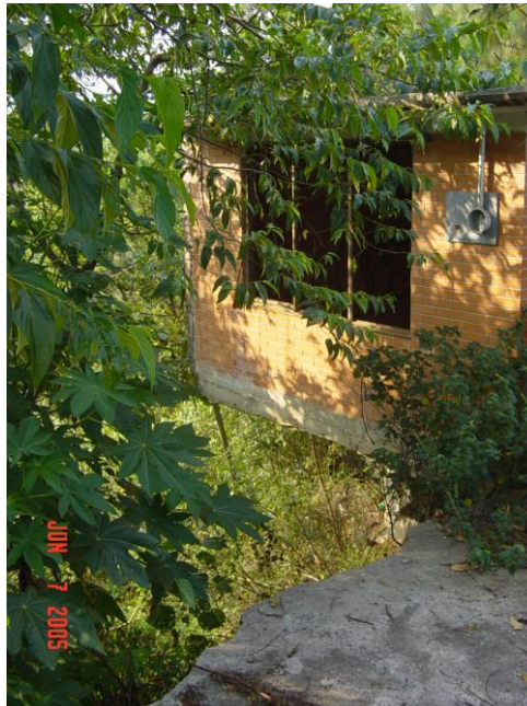
Casa afectada por deslave de terreno. Frente a la casa de la foto anterior.
