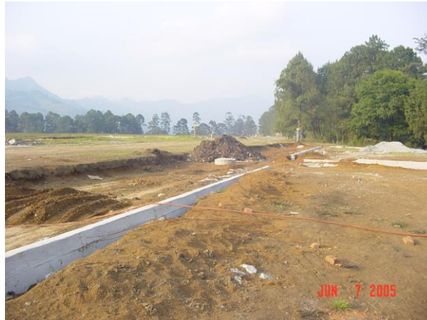
Construcción sobre el DDV, haciendo caso omiso al Criterio de Desarrollo Urbano. La Palpa.
