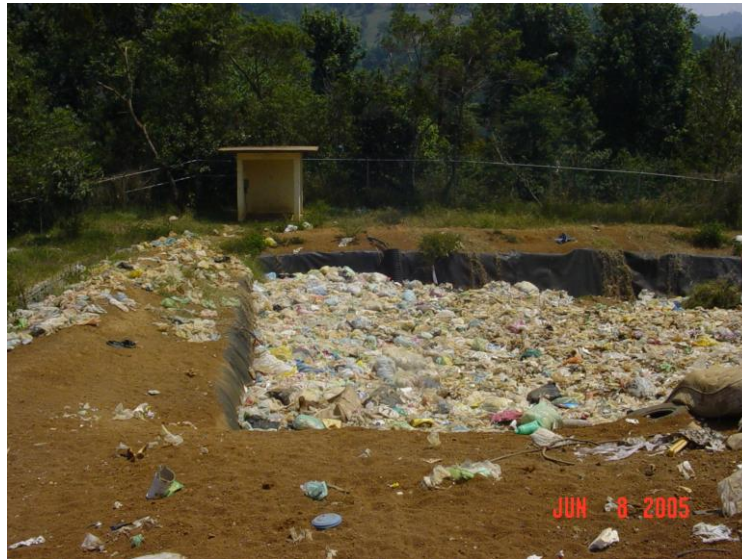
Área de captación de lixiviados en desuso.
