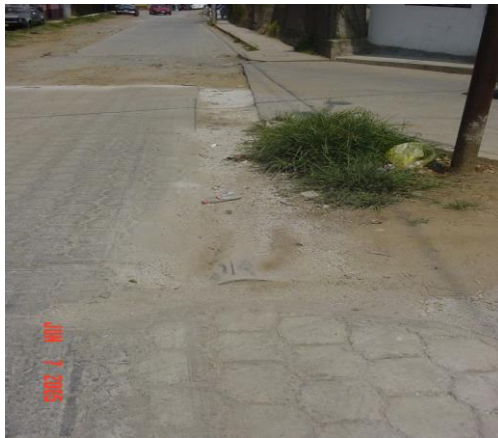
Ducto a flor de piso sobre la avenida.
