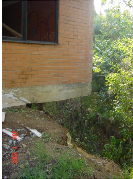
Casa afectada por deslave de terreno.
