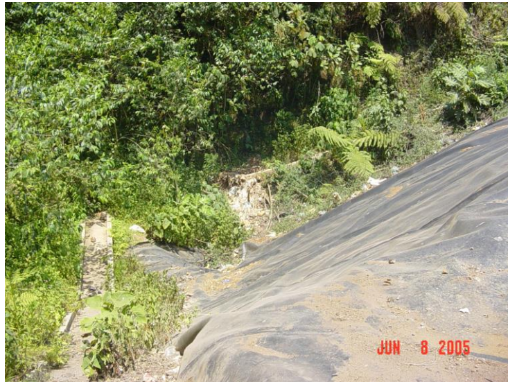
Captación de lixiviados sobre cañada.
