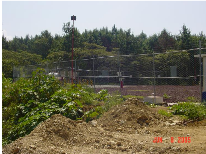
Empresa Sonigas sobre terreno mal compactado.
