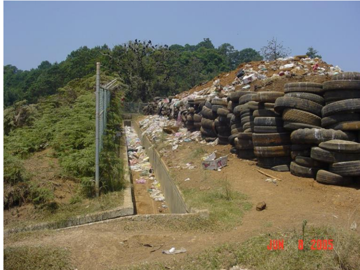
Canaleta de captación de agua pluvial.
