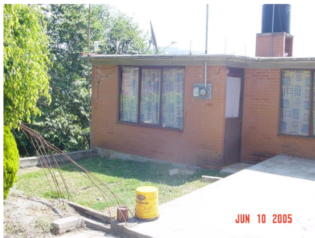
Elementos de fractura por deslave del terreno.
