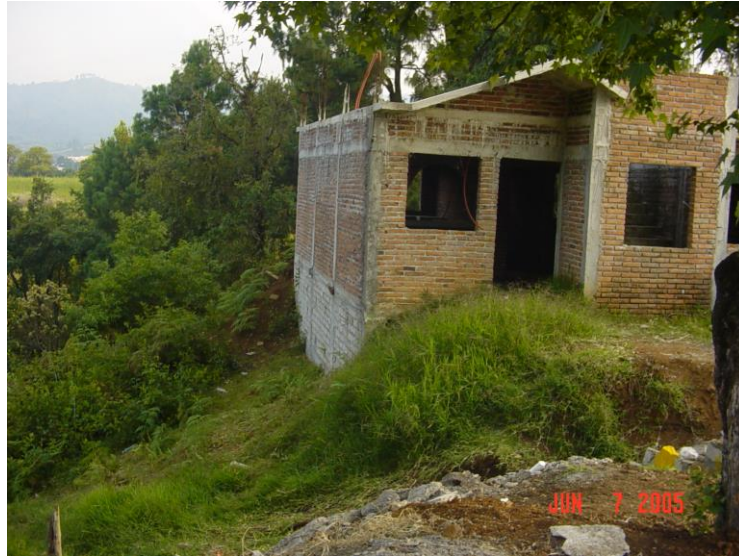
Elementos de deslave. Notar la mala compactación de terreno.
