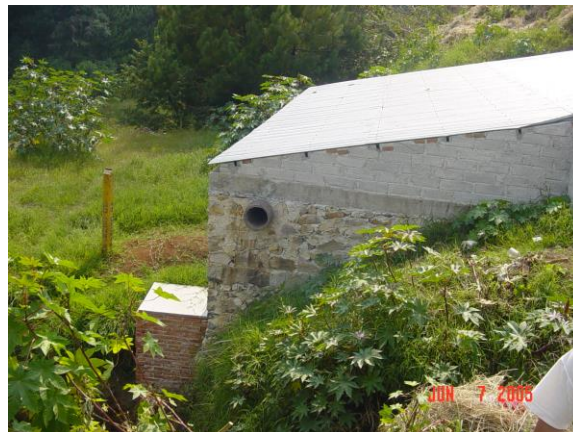
Construcción del cárcamo de aguas negras sobre el ducto. Universidad La Sierra.
