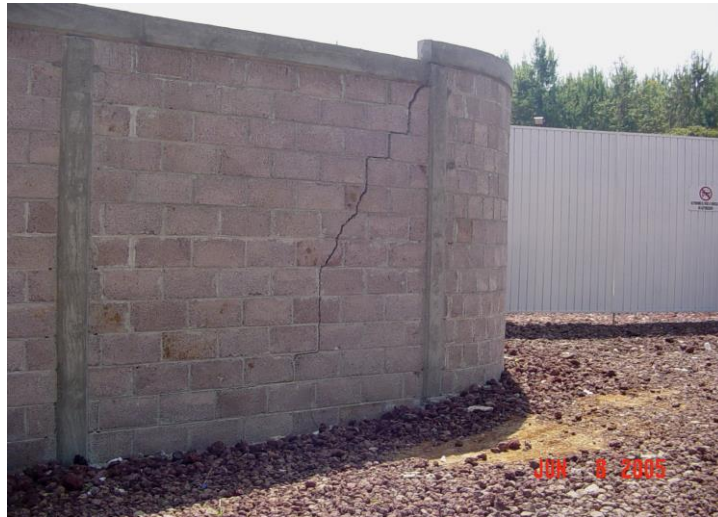
Elementos de fractura en la barda de Sonigas
