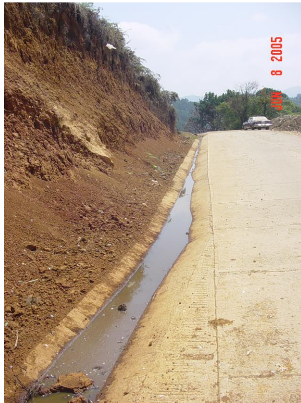
Corriente de lixiviados hacia captación en geomembrana.
