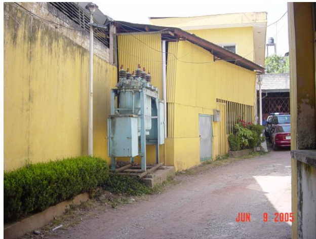
Elementos eléctricos con posibilidad de contener BPC.
