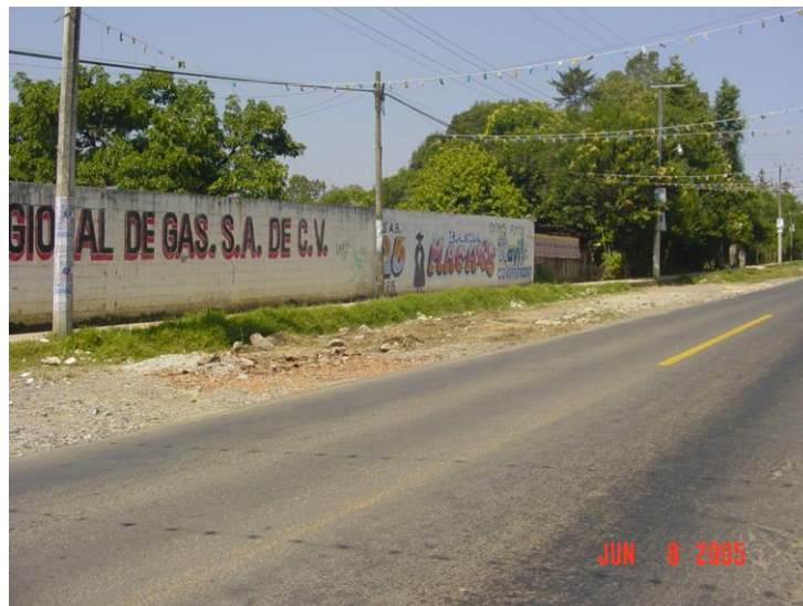
Casas junto a las instalaciones de Regiogas.
