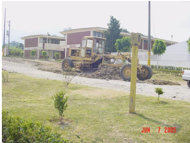
Construcción sobre los ductos. Blvd.. 18 de Marzo.
