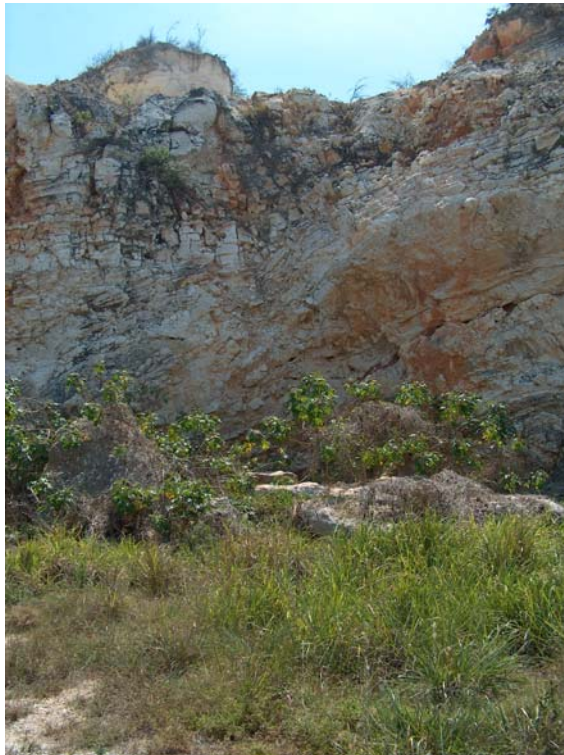
Figura 11.- Banco de material abandonado, en donde se observan, bloques gravitacionales y coluviones pequeños.
