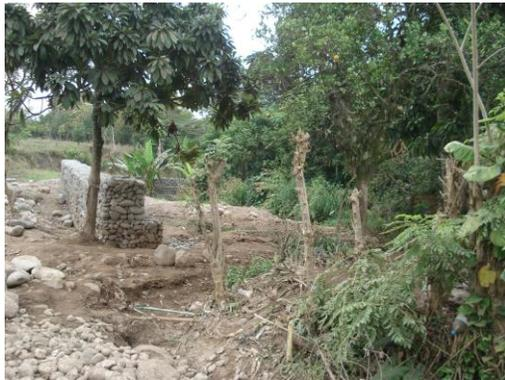
Fotografía H7. Gaviones de protección de las aguas de lluvia, entrada a El Encanto.
