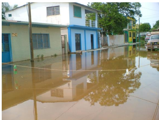
Fotografía H1. Calle Lerdo de Tejada inundada por el arroyo El Control en el año 2007
