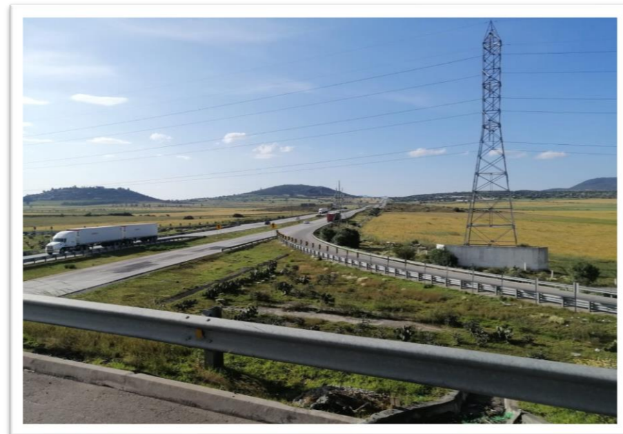
AUTOPISTA ARCO NORTE
