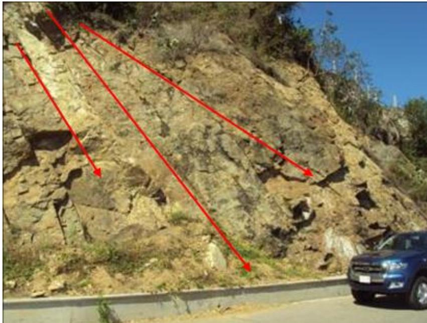
**Fotografía II.2.04.** Vista frontal del talud en donde se observan una serie de fracturas de dirección NW y bloques fracturados por las mismas; estas, tienen una inclinación (echado) a favor del camino, lo que genera un peligro inminente por desprendimiento de bloques. **Fuente.** Elaboración propia.
