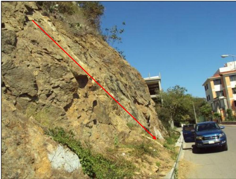
**Fotografía II.2.05.** Vista del talud del Cerro El Vigía hacia el SE de la ciudad de Mazatlán en la que se observan patrones de fracturamiento preferenciales de dirección NW-SE que generan bloques de tamaño medio a grandes mayores de 4.0 metros cuadrados. **Fuente.** Elaboración propia.
