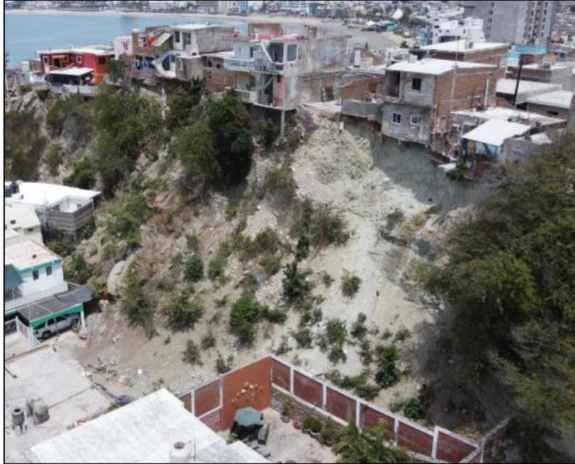
**Fotografía II.2.37.** Panorámica de las condiciones que se presentan en el talud del Cerro del Obispado, en el cual se observa la inestabilidad y la baja cohesión de la unidad de andesitas alteradas. **Fuente.** Elaboración propia.
