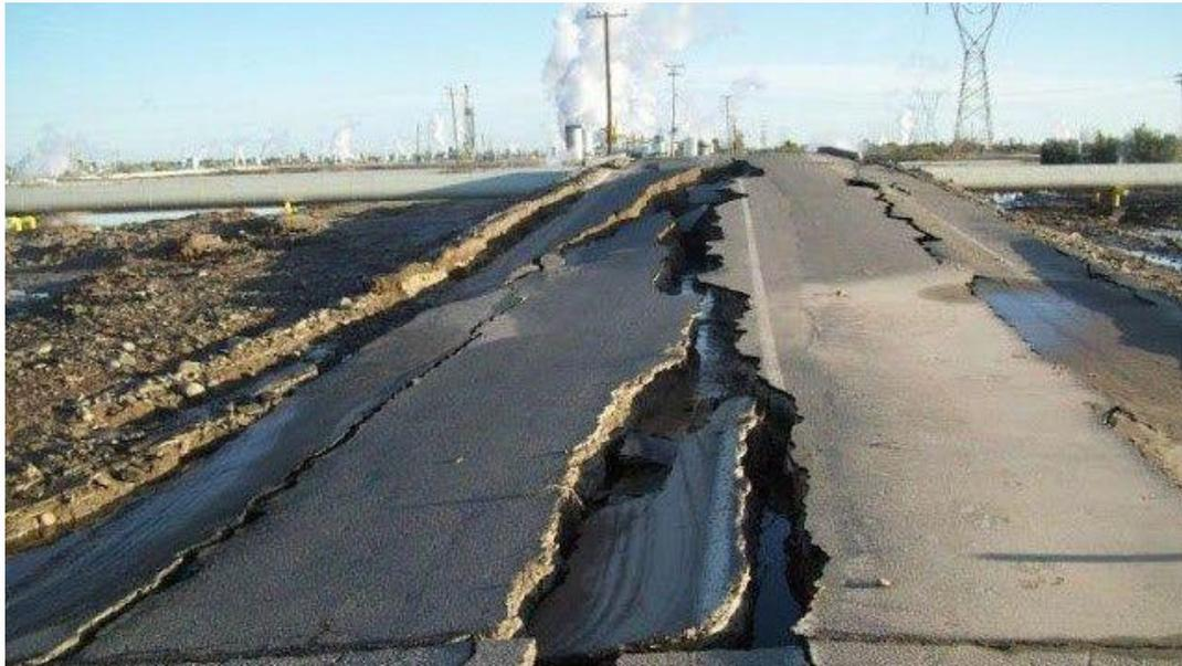
**Fotografía II.2.39.** Fotografía que muestra el fracturamiento ocasionado a la carretera Tijuana-Mexicali a la altura del Km 80.
