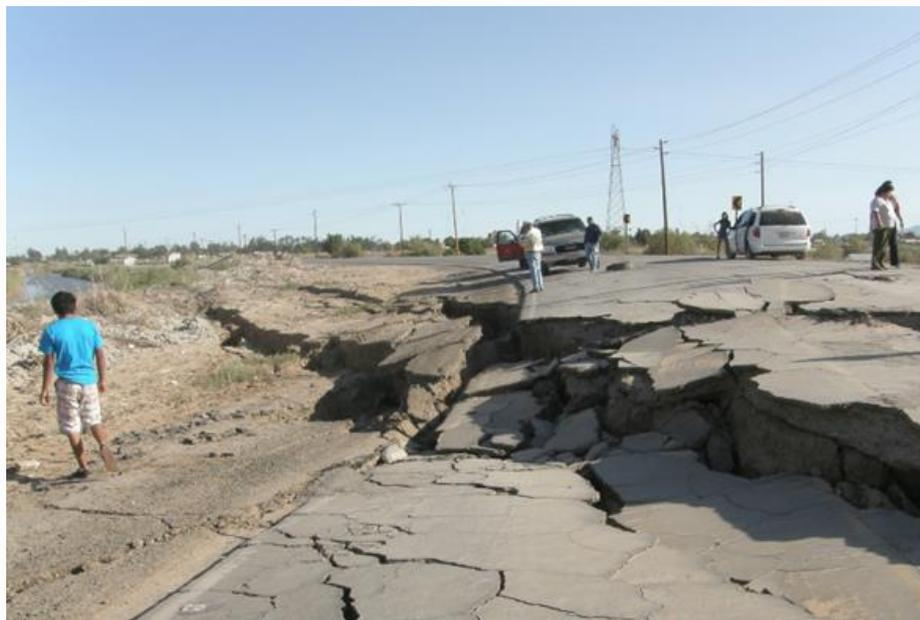
**Fotografía II.2.40.** Fotografía que muestra el fracturamiento y derrumbe de una parte de la carretera Tijuana-Mexicali a la altura del Km 80.
