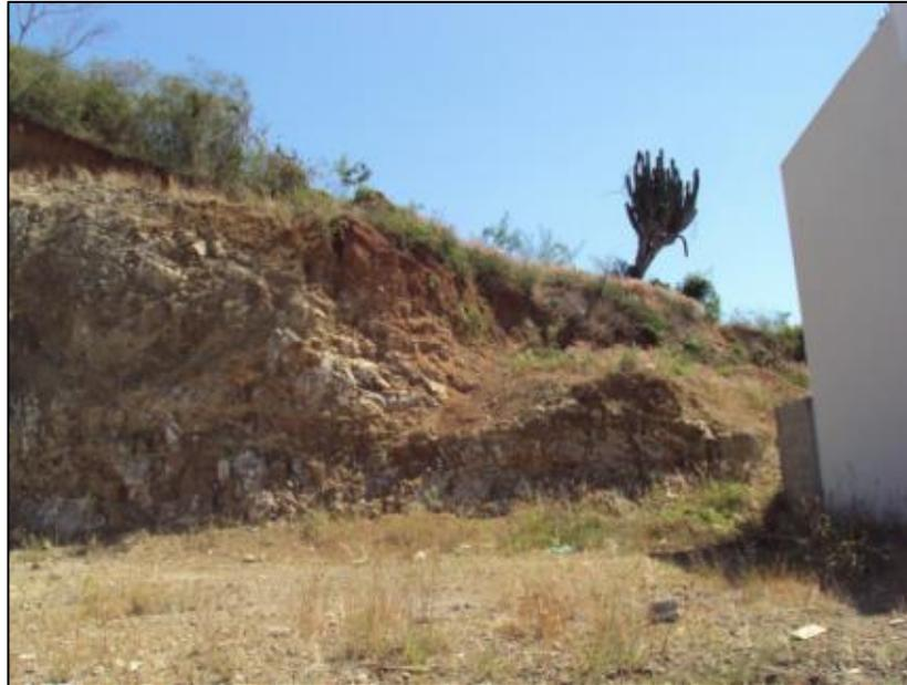
**Fotografía II.2.25.** Afloramiento de rocas en la cercanía de las casas con el talud, el cual en la parte media ya presenta rompimiento y posible caída de cerca de 30 m<sup>3</sup> de rocas, considerándose un peligro para los habitantes de esta zona (9 casas habitación). **Fuente.** Elaboración propia.
