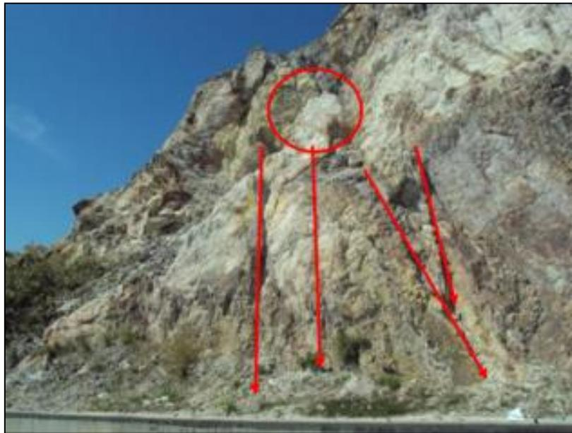
**Fotografía II.2.08.** Vista hacia el sur del cerro de El Vigía, sobre la Calle Venustiano Carranza; se observa el grado de alteración del macizo rocoso, por efecto de metamorfismo de contacto y soluciones hidrotermales, así como varios sistemas de fracturas casi verticales y potenciales bloques por deslizarse. **Fuente.** Elaboración propia.
