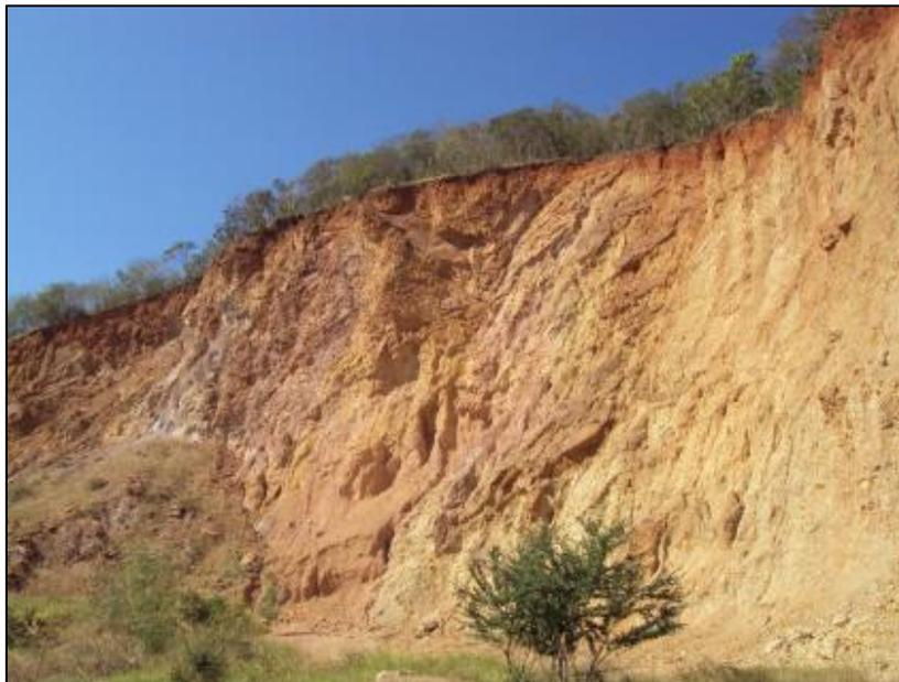
**Fotografía II.2.28.** Vista de la excavación a un costado de la colonia Felipe Ángeles, en donde se observa una secuencia de Esquistos de color pardo verdoso por intemperismo superficial. En la zona de la intrusión de un dique, que es la zona se encuentra más alterada en color pardo rojizo, genera más deslizamientos de talud con acumulación de fragmentos de pie de monte del material deslizado. **Fuente.** Elaboración propia.
