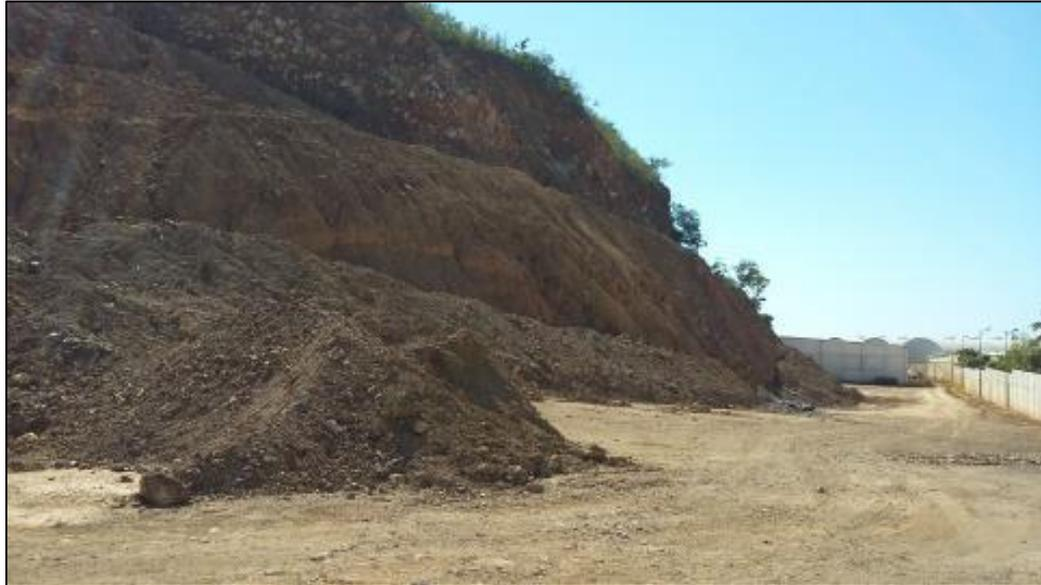
**Fotografía II.2.32.** Vista lateral de uno de los cortes del Cerro Colorado, en la cima se observa un paquete de rocas de composición ignimbrítica; se tiene acumulación de material extraído y depósitos de talud.
