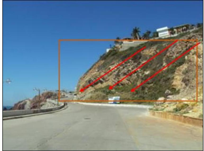
**Fotografía II.2.12.** Talud expuesto en la zona costera del cerro El Vigía; se observan lineamientos estructurales a favor de la avenida Centenario, lo que ha provocado caídos de bloques y la pérdida de la corteza vegetal en la parte superior, evidencia de los corrimientos que se presentan por la pérdida de sustentabilidad del talud. **Fuente.** Elaboración propia.
