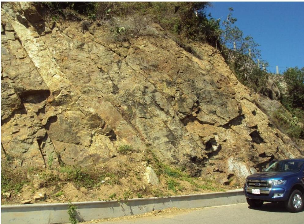
**Fotografía I.06.** Afloramiento de rocas ígneas con un sistema de fracturamiento de dirección NW-SE, con inclinaciones mayores a los 70°, con grandes bloques a favor del talud, los que pueden llegar a colapsar y afectar vehículos, inmuebles y lo más grave a personas.
