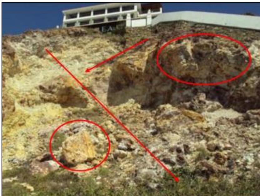
**Fotografía II.2.09.** Vista frontal del cerro El Vigía, en donde se observa el nivel de alteración por hidrotermalismo, factor importante en el degradamiento del talud en la parte media, esto origina taludes invertidos con un alto peligro de que colapse el talud, existen evidencias en el mismo de los fragmentos que han caído y sus tamaños. **Fuente.** Elaboración propia.
