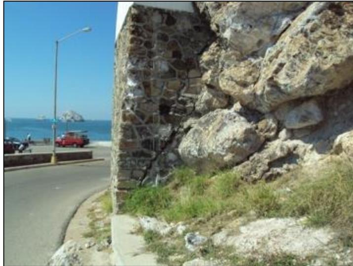
**Fotografía II.2.10.** Vista del fracturamiento en donde está desplantada la cimentación de las escaleras hacia el restaurante, debido a movimientos de empuje de los bloques en la cual se construyó, lo que genera una zona de peligro ante un eventual colapso de esta debido al movimiento de los bloques de las rocas andesíticas alteradas. **Fuente.** Elaboración propia.
