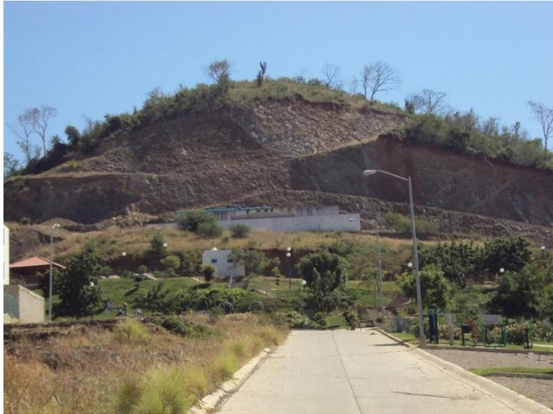
**Fotografía I.07.** Afloramiento en donde se observa que el corte del cerro del fraccionamiento Valle Verde, tiene taludes con inclinaciones de 75° y un sistema de fracturamiento de dirección NW-SE, con emplazamiento de diques de composición aplítica y andesítica.
