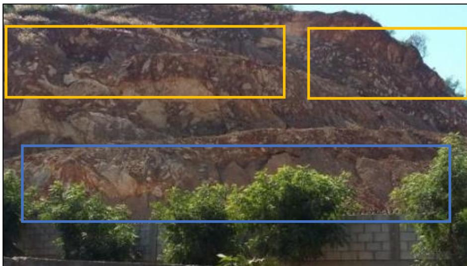
**Fotografía II.2.31.** Talud conformado por brechas de composición riolítica; el recuadro en color azul es una zona de depósitos de talud y en recuadros color amarillo, son zonas de talud invertido que con el tiempo y los efectos de erosión e intemperismo se generarán bloques que se volverán inestables. **Fuente.** Elaboración propia.
