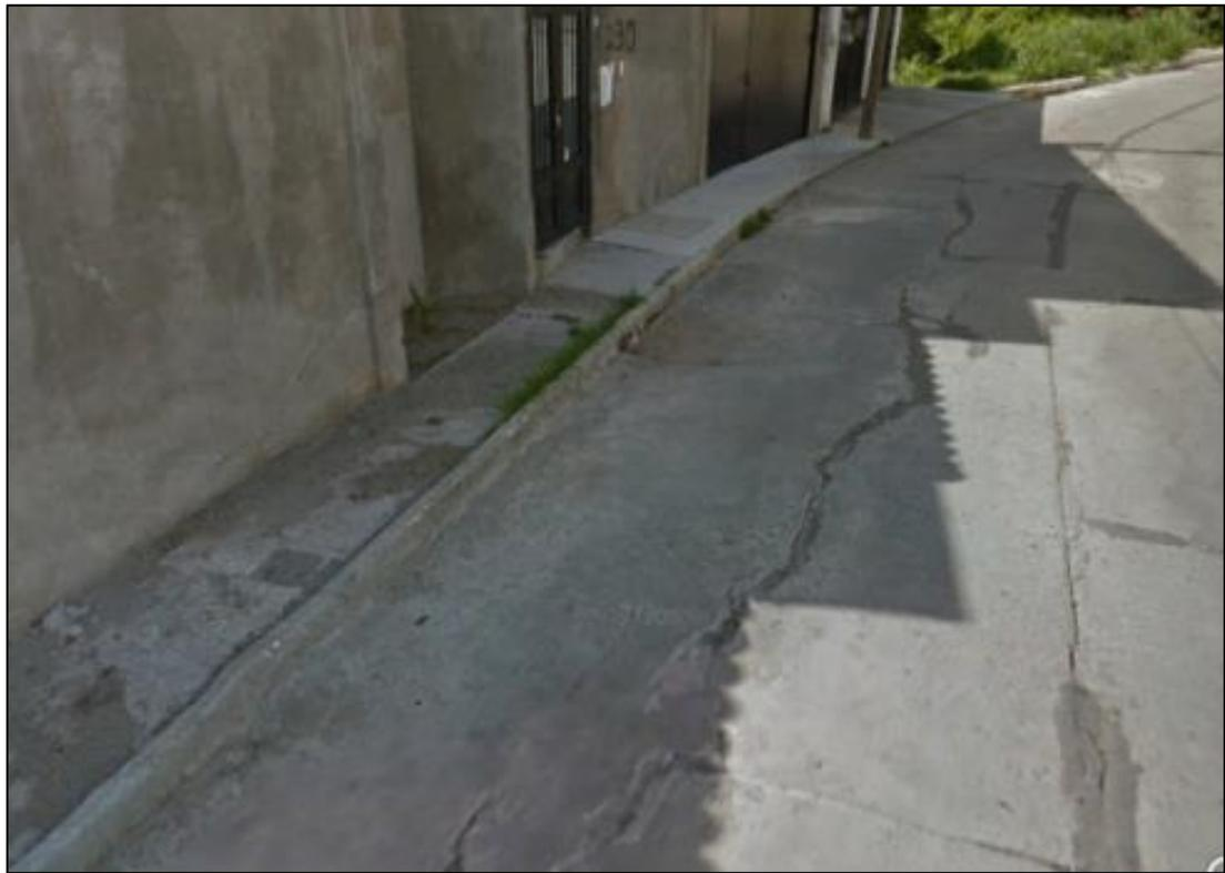
**Fotografía II.2.06.** Grietas de tensión observadas en la calle camino al observatorio, las cuales corresponden a la parte alta del talud rocoso. **Fuente.** Elaboración propia.
