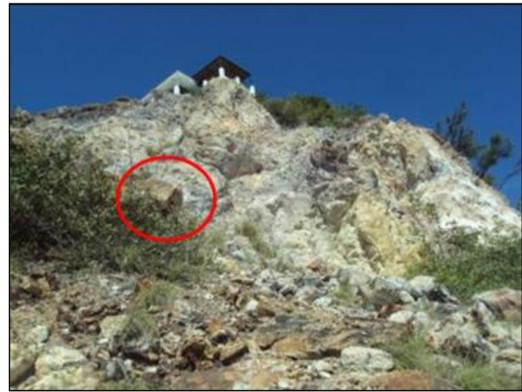
**Fotografía II.2.11.** Vista del talud el cual conserva una pendiente irregular que va de los 75° a 82°, y zonas donde se observa el contra talud lo que genera zonas de alto riesgo por derrumbes de fragmentos que tienen de 20 cm. hasta más de 1.0 m. de diámetro. **Fuente.** Elaboración propia.
