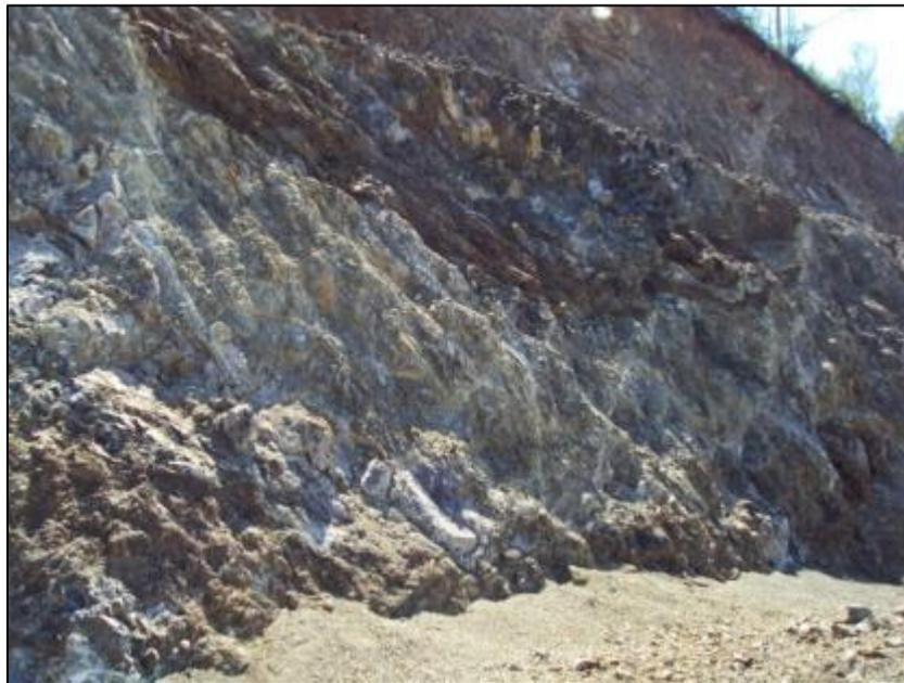
**Fotografía II.2.22.** Material expuesto en la parte media del talud, en donde se observan las condiciones del macizo rocoso alterado con fracturamiento intenso debido a factores exógenos, se observa la acumulación de residuos de este material al pie del talud. **Fuente.** Elaboración propia.
