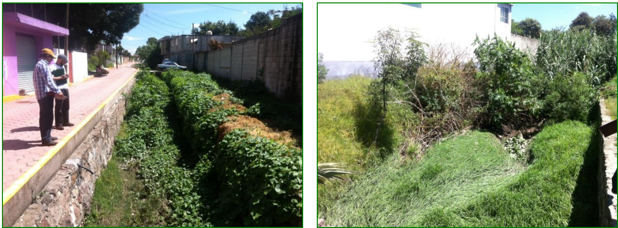
ILUSTRACIÓN 24. BARRANCA DEL CORAZÓN DE JESÚS ENCAUSADA Y SIN ENCAUSAR.
