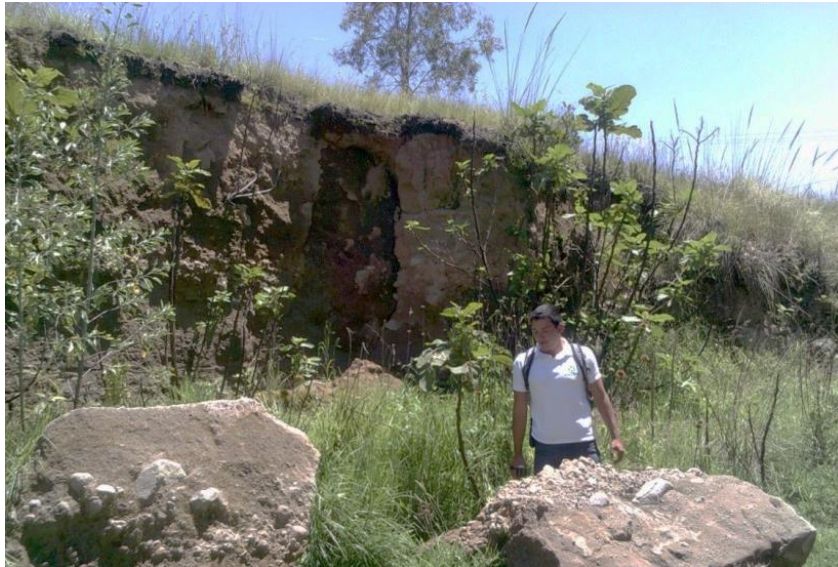
ILUSTRACIÓN 67. CAÍDA DE BLOQUES EN LA BARRANCA TECUANATLA. SE PUEDE OBSERVAR EL TAMAÑO DE LOS BLOQUES QUE SE DESPRENDIERON DE LA LADERA, ESTE PROCESO GENERA QUE EL CAUCE SE HAGA MÁS ANCHO.
