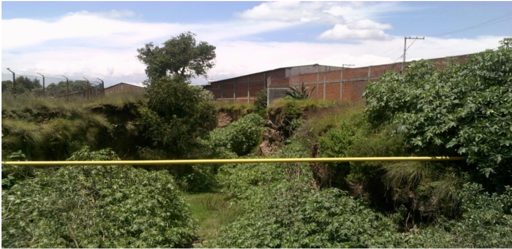
ILUSTRACIÓN 8. BARRANCA ZAHUAPAN, SE PUEDE QUE LA PROFUNDIDAD ES ALTA (APROXIMADAMENTE 20 METROS).
