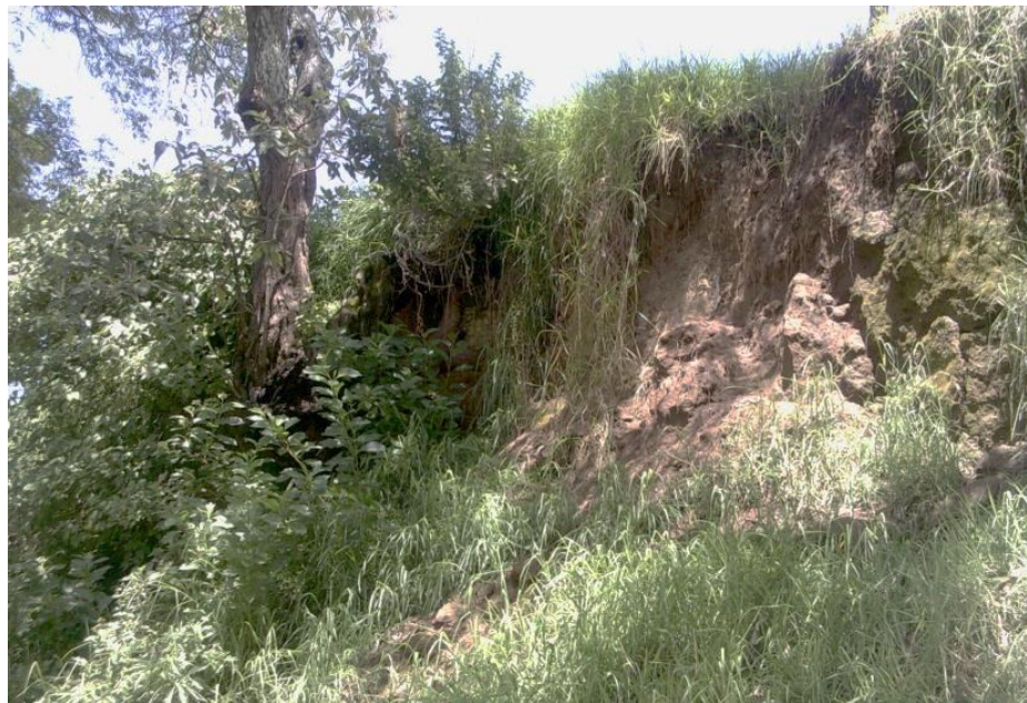
ILUSTRACIÓN 71. PEQUEÑO DESLIZAMIENTO DE SUELO, DONDE SE OBSERVA LA PRESENCIA DE VEGETACIÓN.
