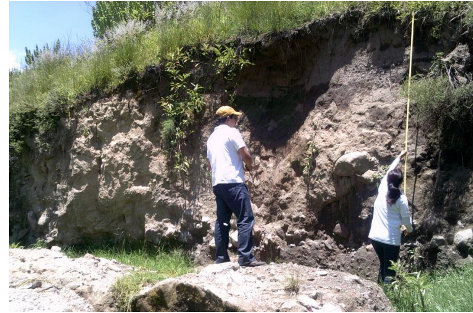
ILUSTRACIÓN 72. SE OBSERVA EN LA IMAGEN UN BLOQUE DESPRENDIDO Y LA CICATRIZ DE DESPRENDIMIENTO, ADEMÁS SE TOMARON MEDIDAS DE ALTURA DE LA LADERA, LA CUAL NO REBASA LOS 5 METROS.
