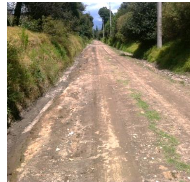
ILUSTRACIÓN 20. CALLE DE TERRACERÍA SOBRE EL CAUCE DE LA BARRANCA ACAPIXTLE.
