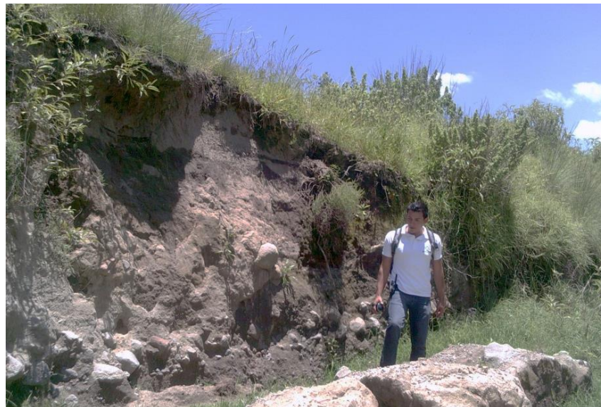
ILUSTRACIÓN 68. EN AMBOS MÁRGENES DE LA BARRANCA SE OBSERVA EL DESPRENDIMIENTO DE BLOQUES, ESTO ES PROVOCADO POR LA SOCAVACIÓN FLUVIAL EN ÉPOCA DE LLUVIAS YA QUE EN LA IMAGEN SE OBSERVA EL RÍO SECO.
