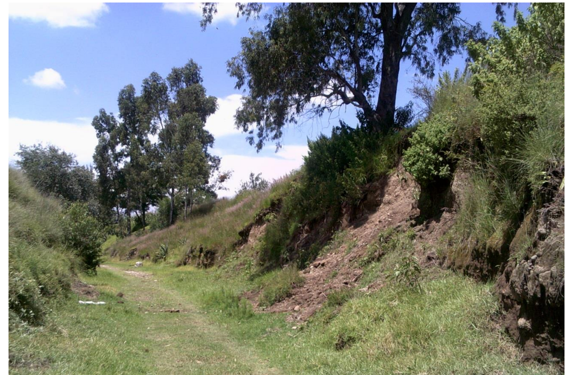
ILUSTRACIÓN 69. DESLIZAMIENTO DE SUELO EN EL MARGEN DERECHO, SE OBSERVA QUE ES MUY PEQUEÑO Y QUE HA IDO ACUMULANDO DEPÓSITO EN EL CAUCE.
