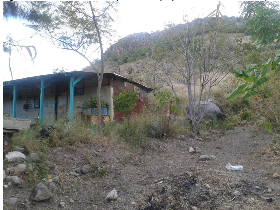
Figura 35. Se observa una casa asentada en el abanico coluvial. Un gran bloque se encuentra cercano a ella, la roca proviene del escarpe localizado ladera arriba.
