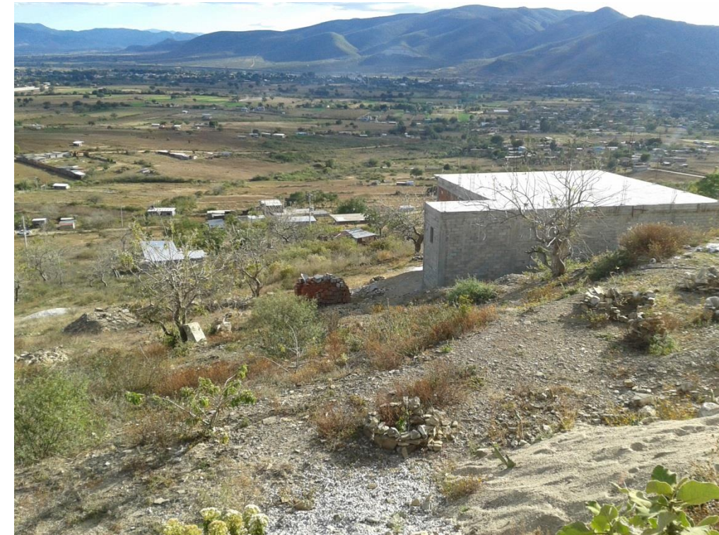
Figura 30. Construcción sobre ladera parcialmente alterada, la vegetación es secundaria y la erosión fluvial ha comenzado a desmontar la vegetación además de iniciar el acarreo de suelo.
