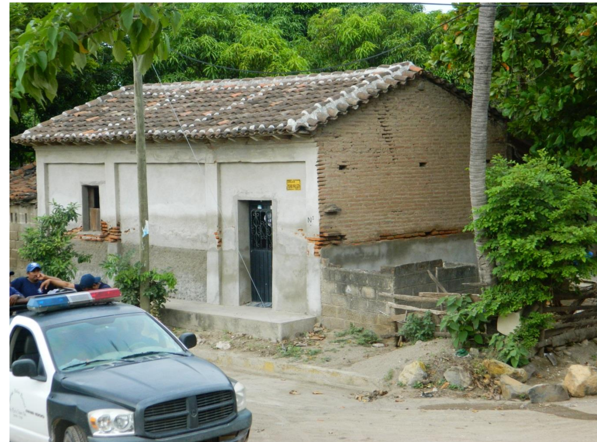
Fig. XX. En donde se muestra una casa remosada con una grieta en la parte superior. Posiblemente por efecto del movimiento diferencial del terreno aluvial.
