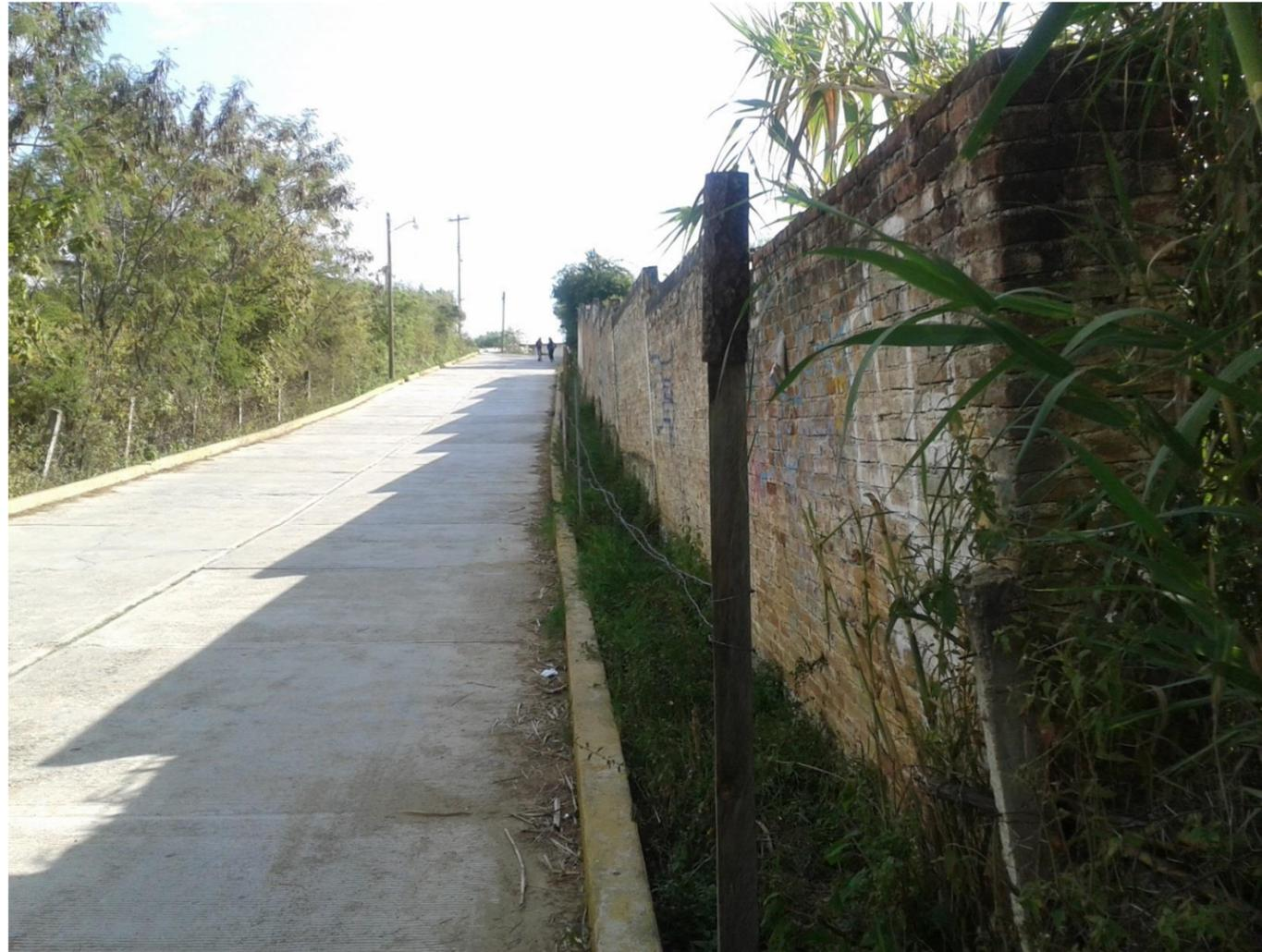
Figura 38. Barda basculada. Es difícil asegurar que el movimiento de la barda se deba al hundimiento del terreno, pero no se observan golpes o mal posición de los pilares.
