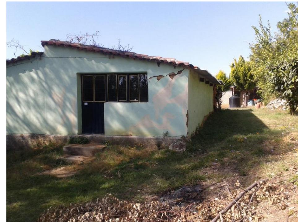
Figura 37 Casa agrietada con desplazamiento normal, en donde el sector izquierdo de la casa muestra un ligero hundimiento y el pilar derecho no presenta desnivel.
