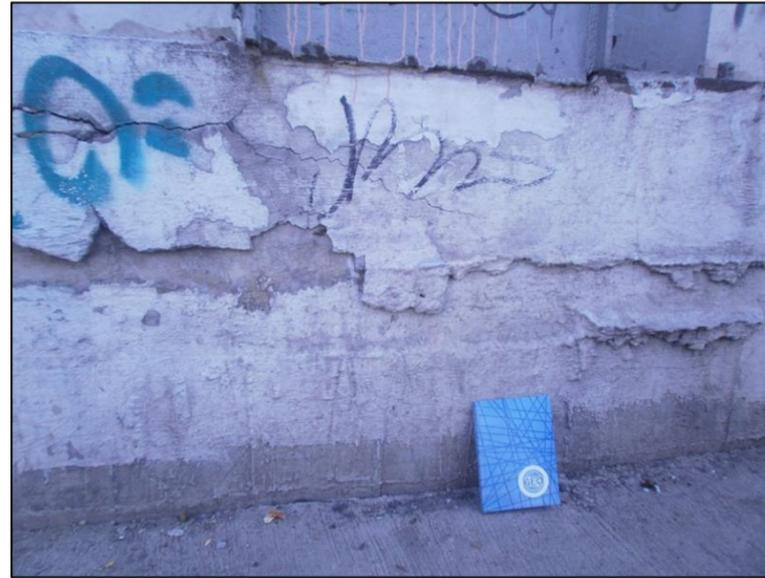
Figura 87. Se observa tres niveles de subsidencia al que se ha sometido el inmueble, el primero de 34 cm, el segundo de 12 cm y el tercero de 24 cm.
