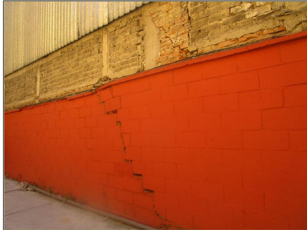
**Figura 95. Agrietamiento E-W de la U.H. La Concordia, afectando a muros perimetrales y pérdida de verticalidad entre las torres.**
