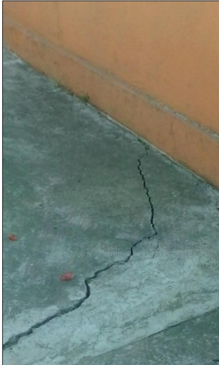
Figura 97. Agrietamiento localizado en la colonia Agrícola oriental, con una dirección preferencial NE-SW.
