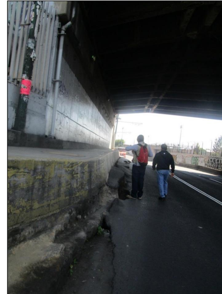
Figura 94. Agrietamiento NW-SE con un salto de 40 centímetros, afectando a la vialidad de Avenida Pantitlán.
