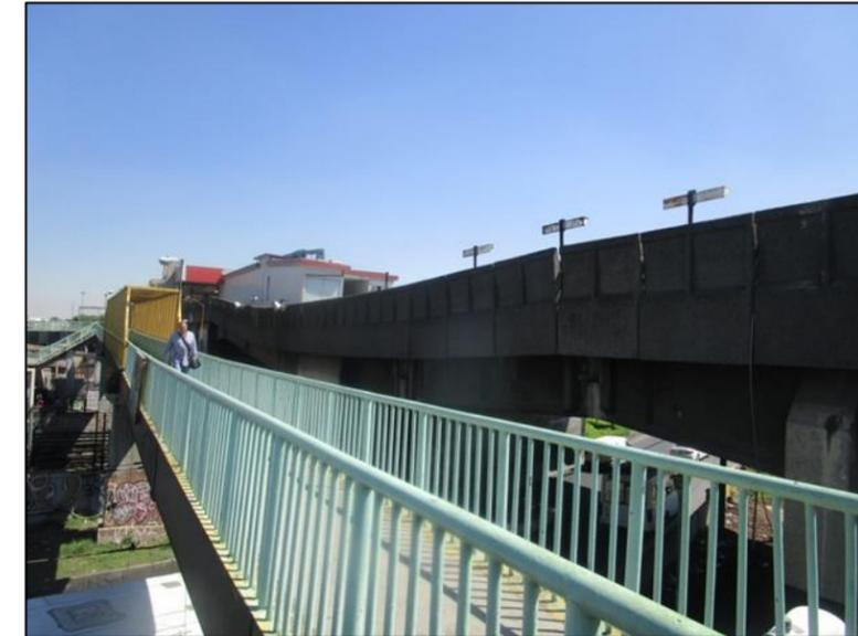
Figura 77. Flexión del cajón del Metro línea nueve debido a un hundimiento diferencial, sobre Avenida Pantitlán y Canal Churubusco
