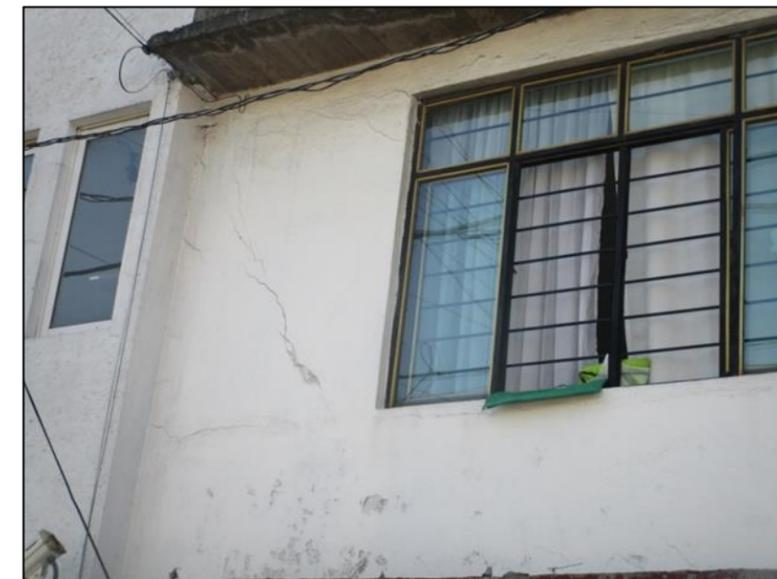
Figura 78. Fisuramiento diagonal en muro semiconsolidado de casa habitación originado por el hundimiento en edificio en la calle Cerrada 1 Río Churubusco y Río Churubusco.
