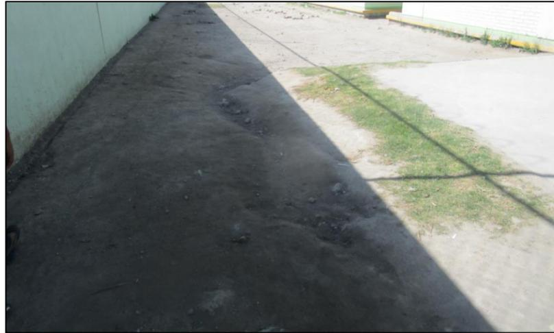
**Figura 88. Grieta por disecación del terreno dentro de instalaciones de escuela primaria**
