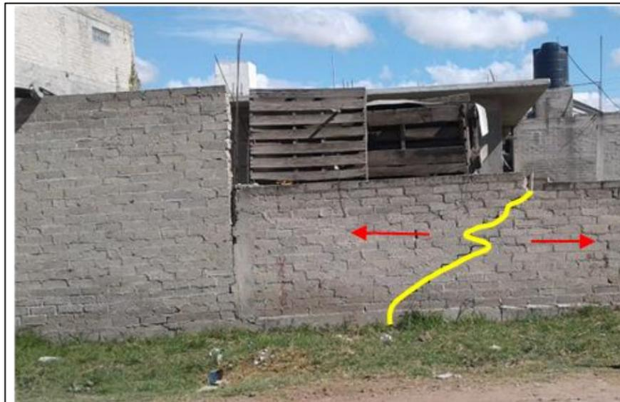
Figura 80. Afectaciones en barda perimetral de vivienda particular por efecto de los esfuerzos de tensión que se generan por el hundimiento diferencial.
