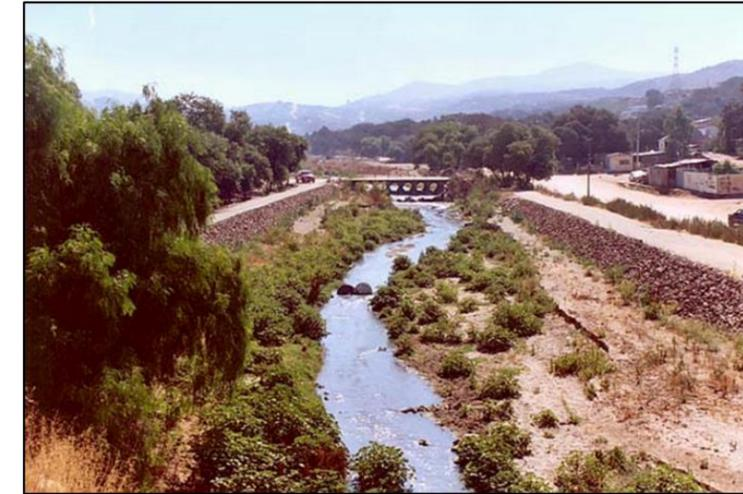
Figura 140. Obras y acciones para mitigar el fenómeno de inundación. Bordos longitudinales
