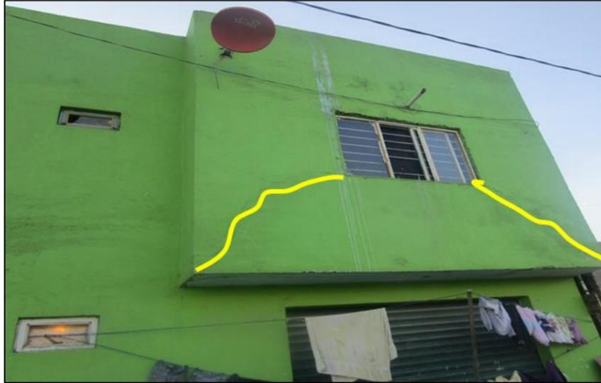
Figura 79. Afectaciones sobre vivienda particular por hundimiento diferencial.
