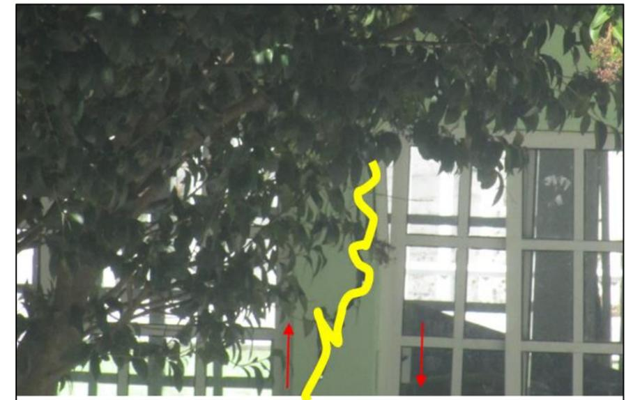
Figura 82. Escuela secundaria técnica con serias afectaciones en infraestructura por hundimiento diferencial
