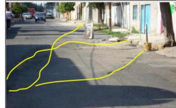
Figura 86. Agrietamiento del terreno en calles del municipio de Atenco
