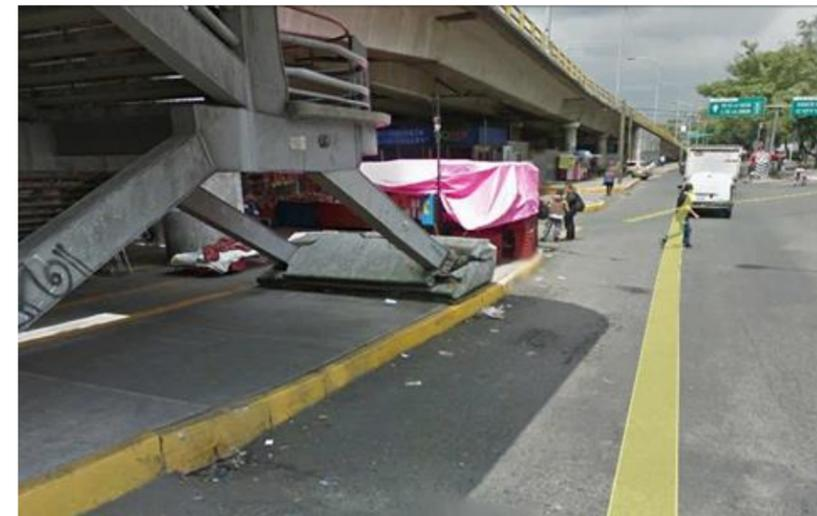
Figura 72. Hundimiento del terreno y afectaciones a estructura. Fuente: Imagen de Google Earth, 2016.
