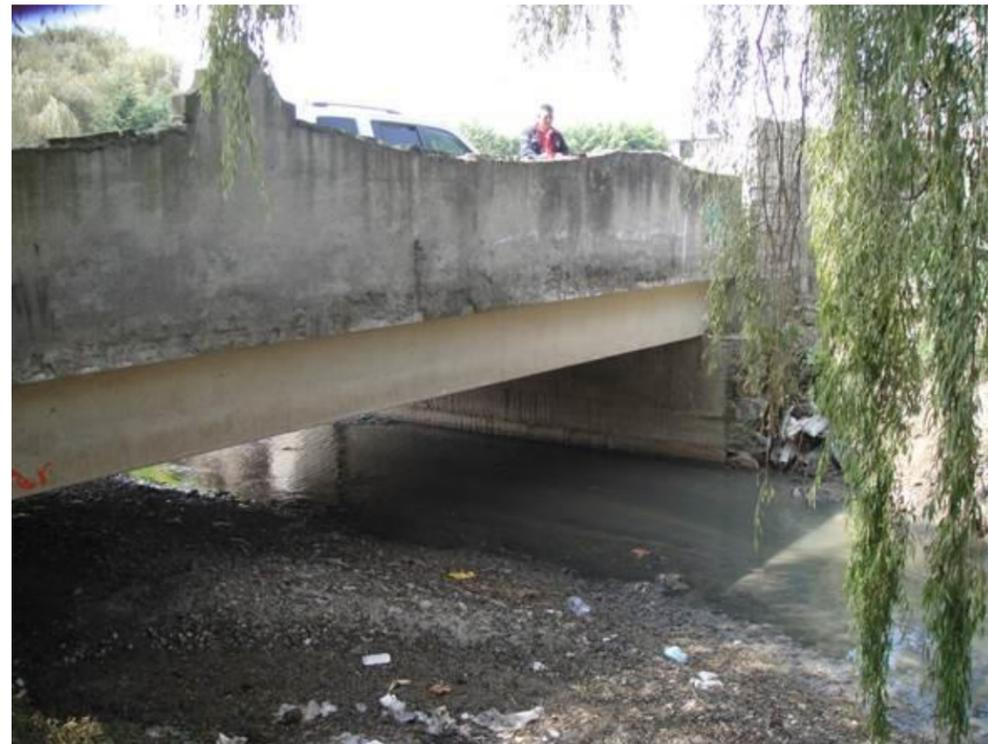
Además también se observó presencia de erosión en la margen derecha del cauce, lo que está generando que los soportes del puente se estén deteriorando.
