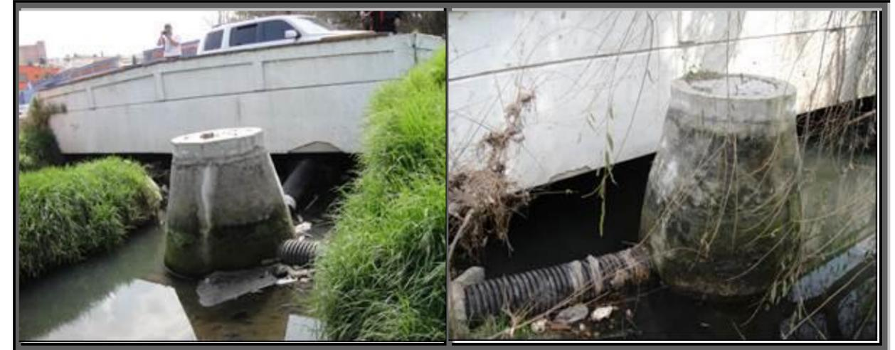
A pesar de lo visto en las fotografías, el personal de Protección Civil indicó que en este sitio solo tienen problema de encharcamiento. Esto debido a que la sección del puente tiene una mayor elevación que el terreno natural y no presenta esta última un adecuado drenaje pluvial.
