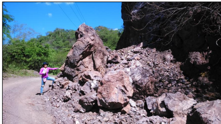
Figura 5.1.4.3. Segundo punto donde se observó una remoción de materiales rocosos sobre el camino de terracería Sierra Santa Magdalena. Fuente EM Capital.
