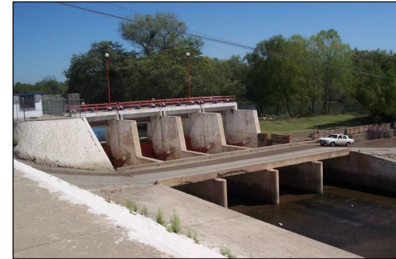
Figura 5.2.2.1. Presa de derivación en Sinaloa de Leyva. Fuente EM Capital Soluciones Integrales S.A. de C.V.
