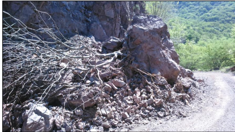
Figura 5.1.4.2. Primer punto de caídos y deslizamiento sobre el camino de terracería Sierra Santa Magdalena. Fuente EM Capital.
