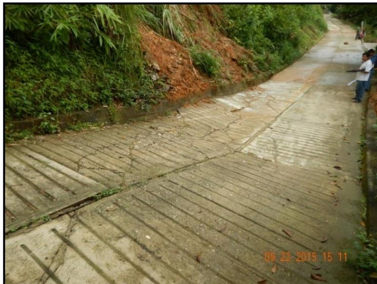
**FOTOGRAFIA 27.** En esta fotografía no se observa el trazo de la fractura solo se infiere (dirección del papel enrollado) ya que constantemente reparan la calle (Peligro Muy Alto), la afectación sobre la vivienda se ubica en la casa contigua propiedad del Sr. Nemesio Lara García.
