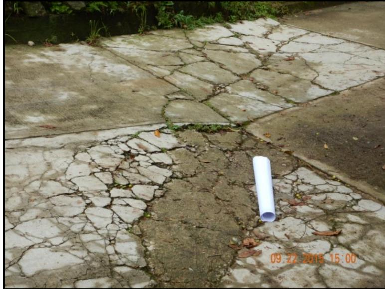
**FOTOGRAFIA 26.** En la imagen no se observa el trazo de la fractura solo se infiere (dirección del papel enrollado) ya que constantemente reparan la calle, frente a este Punto de Control se ubica la vivienda de la Sra. Agustina Rodríguez Cortez siendo el motivo principal de que se haya considerado el punto como de Peligro Muy Alto.
