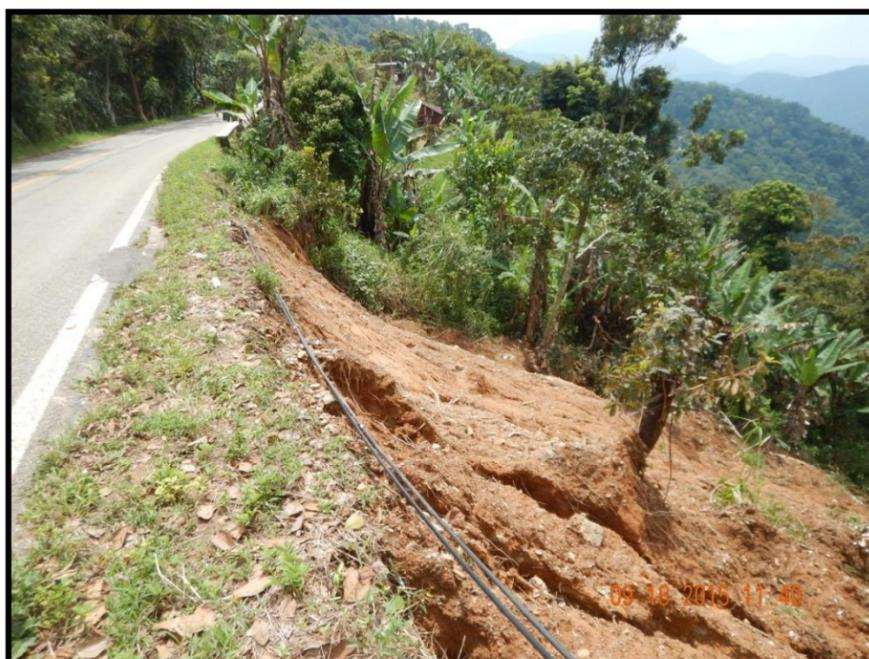
FOTOGRAFIA 58. Deslizamiento de ladera ubicado sobre la margen derecha de la Carretera Federal 175 con dirección a San Pedro Pochutla.
