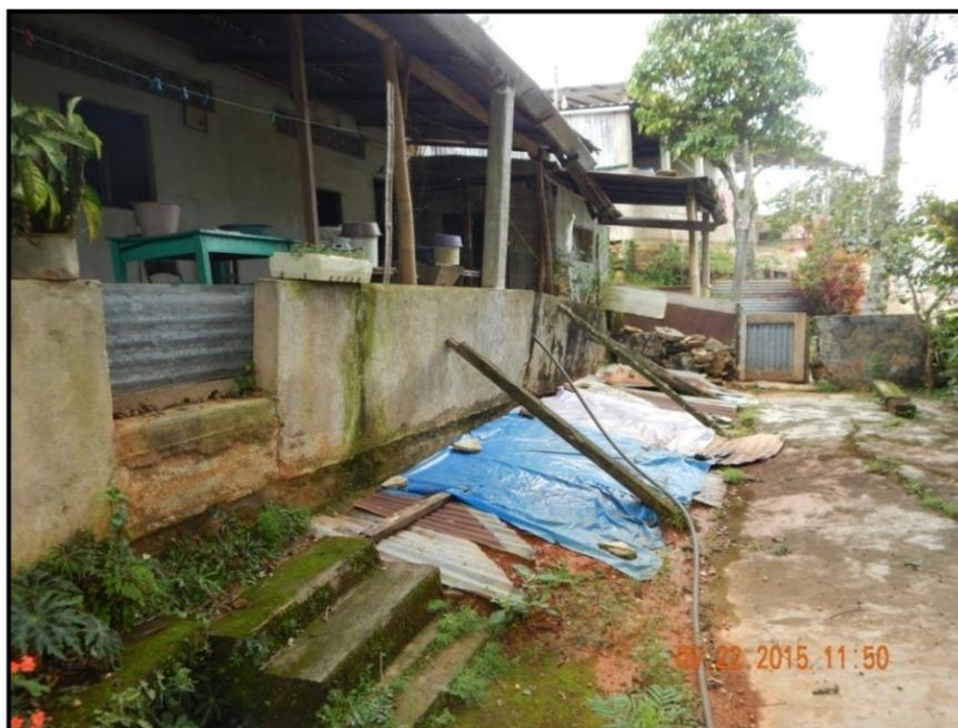
FOTOGRAFIA 22. Vivienda con afectación por fracturamiento y volcadura de bardas propiedad de la Sra. Juana Martínez y se consideró de Peligro Alto.
