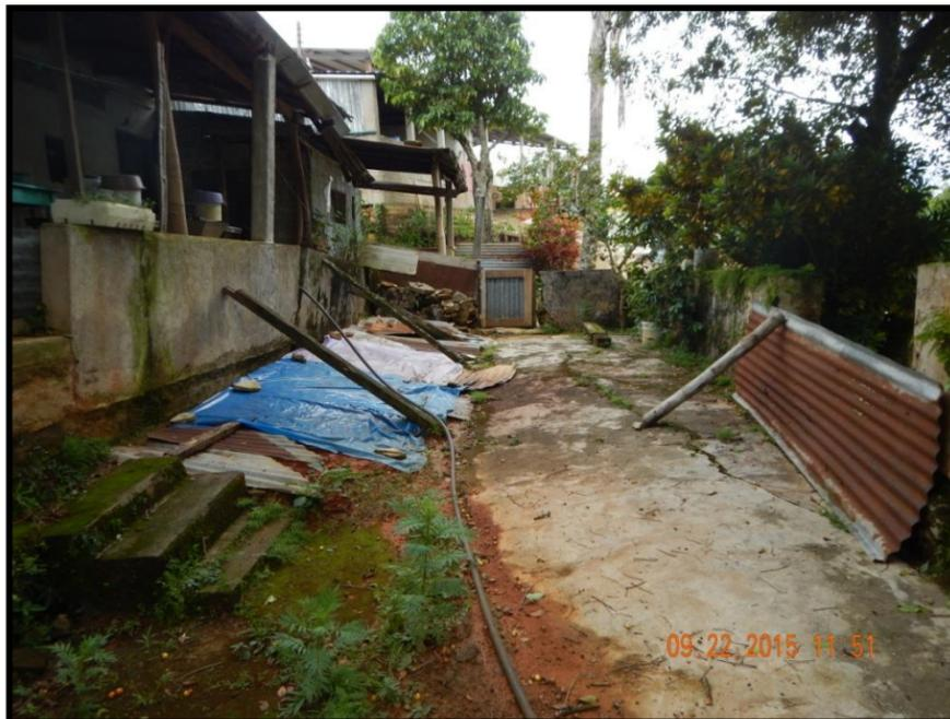
FOTOGRAFIA 53. Vivienda Tipo I (CENAPRED) propiedad de la Sra. Juana Martínez donde se tiene un fracturamiento de dirección preferencia SW y donde se observa el peligro por volcadura de la barda la cual está sostenida por unos maderos.
