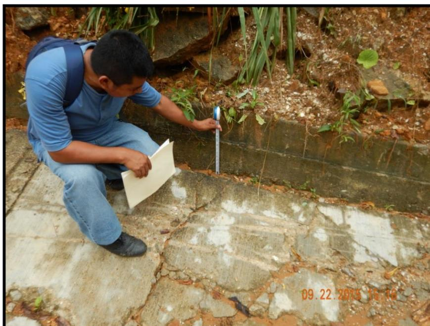
FOTOGRAFIA 54. Afectaciones derivado del fracturamiento que se ubica sobre la calle principal y donde se tiene un hundimiento de 22 cm.
