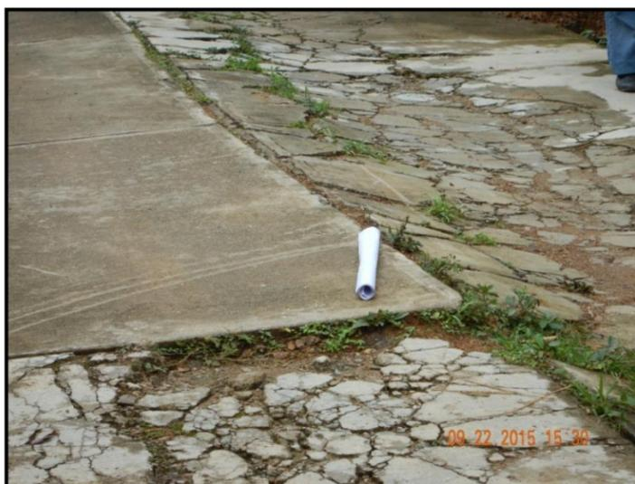
**FOTOGRAFIA 28.** En la imagen no se observa el trazo de la fractura solo se infiere (dirección del papel enrollado) pero el bajo de la misma tiene dirección hacia el Río El Alacrán.
