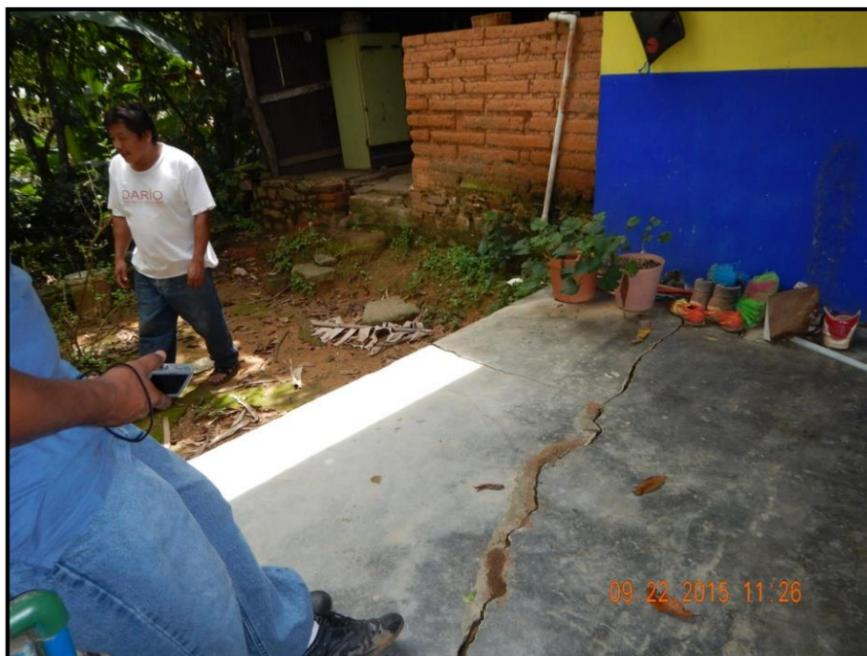
FOTOGRAFIA 21. Vivienda propiedad del Sr. Freddy Bustamante Salinas con afectación por fracturamiento y donde se consideró como de Peligro Alto.
