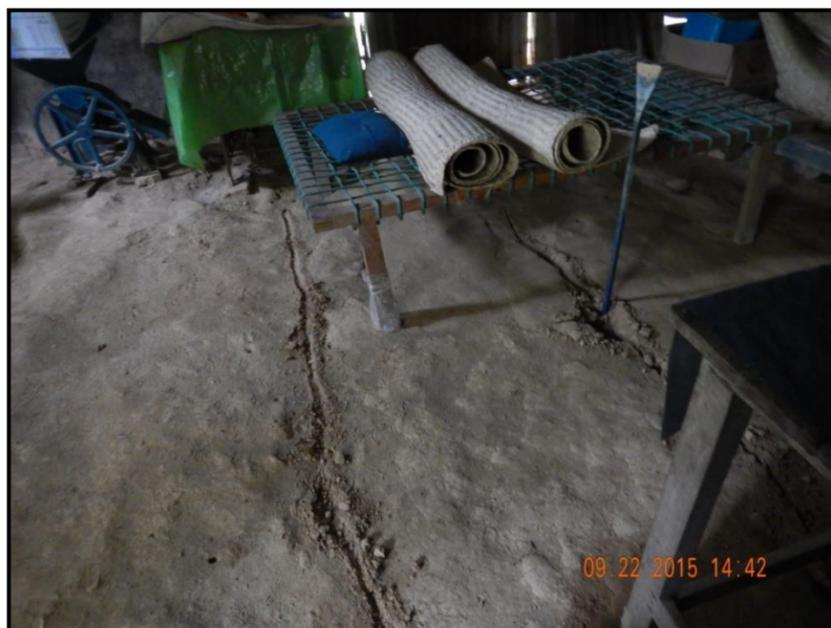
**FOTOGRAFIA 25.** Vivienda Tipo I (Clasificación CENAPRED, 2005) propiedad del Sr. Mauro Juárez Hernández donde se observa el fracturamiento y donde se encallo una barreta para conocer la profundidad de la misma (Peligro Muy Alto).
