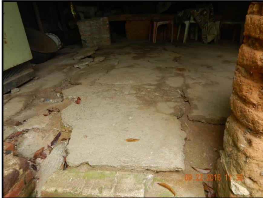
FOTOGRAFIA 52. Vivienda Tipo I (CENAPRED) propiedad del Sr Freddy Bustamante Salinas donde se puede observar el levantamiento del piso derivado del fracturamiento el cual presenta una dirección preferencial NW43° con 70° NE.
