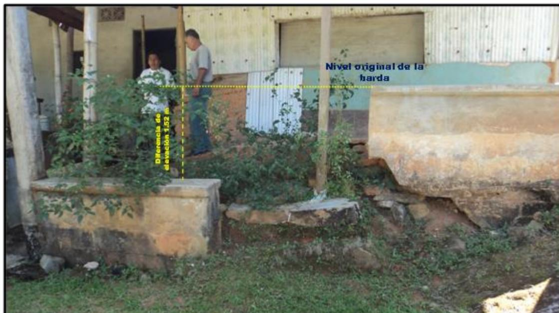
**FOTOGRAFIA 6.** Deslizamiento de barda atribuible al movimiento de ladera en la localidad de San Isidro del Camino, perteneciente a Candelaria Loxicha.
