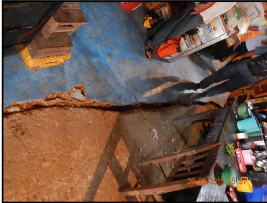
FOTOGRAFIA 55. Vivienda Tipo I (CENAPRED) propiedad del Sr. Omar Rodríguez donde se observa la longitud y amplitud de la fractura que se encuentra en la parte media de la vivienda.
