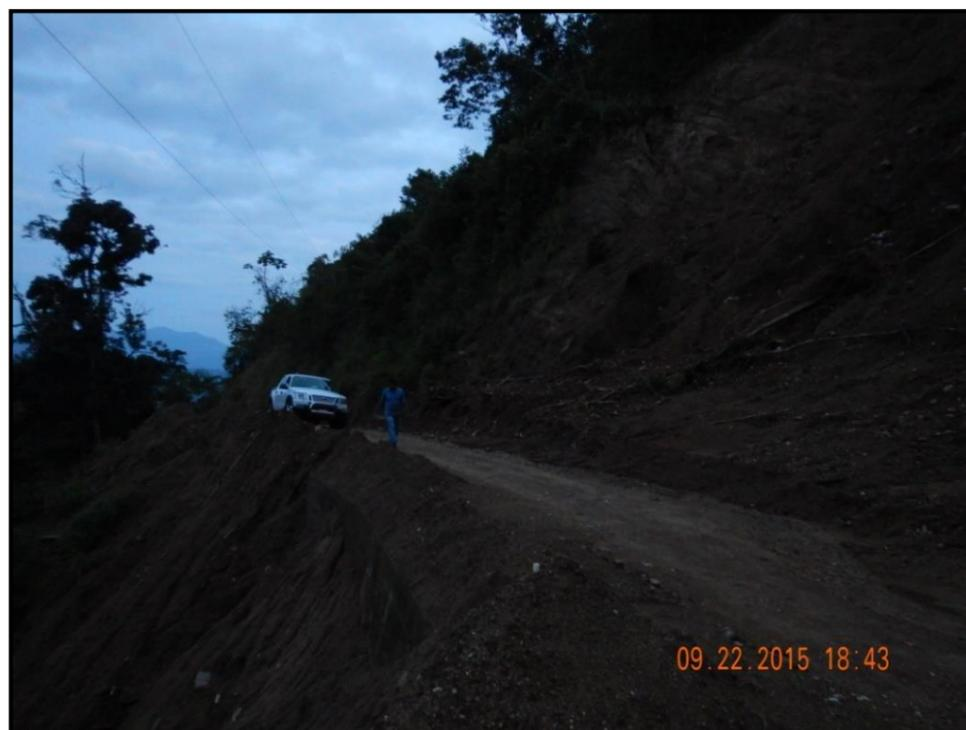
**FOTOGRAFIA 14.** Afectación a Vías de Comunicación por Inestabilidad de Laderas identificado sobre el camino de terracería que conduce a la Agencia Municipal San Isidro del Camino (parte superior e inferior del camino).
