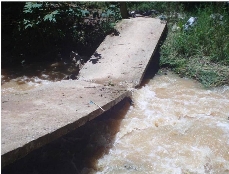
**Ilustración 11. Puente roto por crecidas repentinas del río Zoquitlán.**
