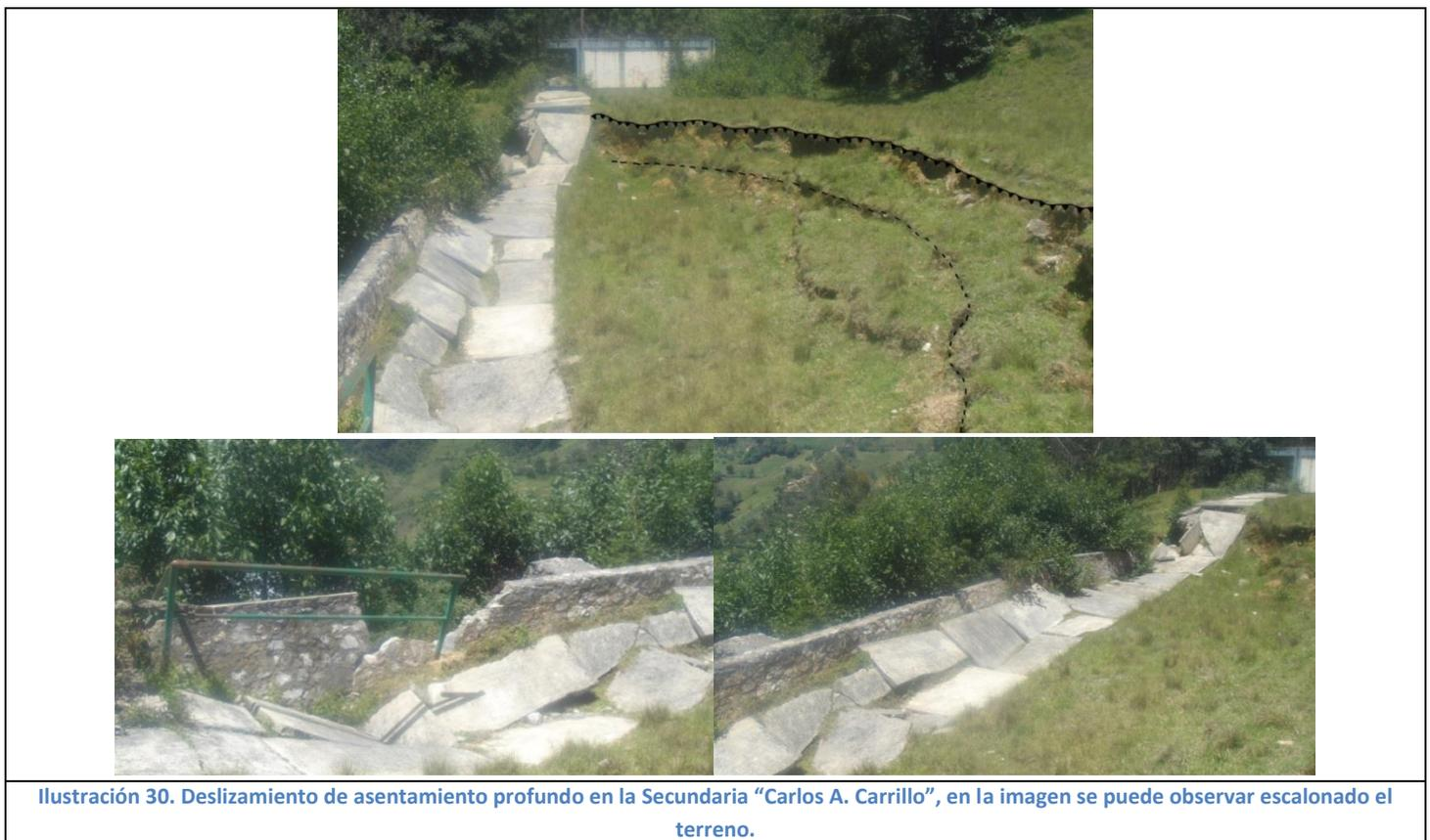
**Ilustración 30. Deslizamiento de asentamiento profundo en la Secundaria “Carlos A. Carrillo”, en la imagen se puede observar escalonado el terreno.**
