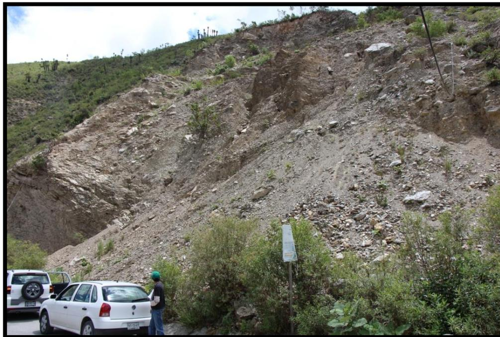
Foto Núm. 05 Derrumbe en la carretera con coordenadas  $X=680514$  /  $Y=2045433$ , un letrero local la señala como falla geológica. La roca fallada es de la formación K(lu-ar) lutitas y areniscas.
