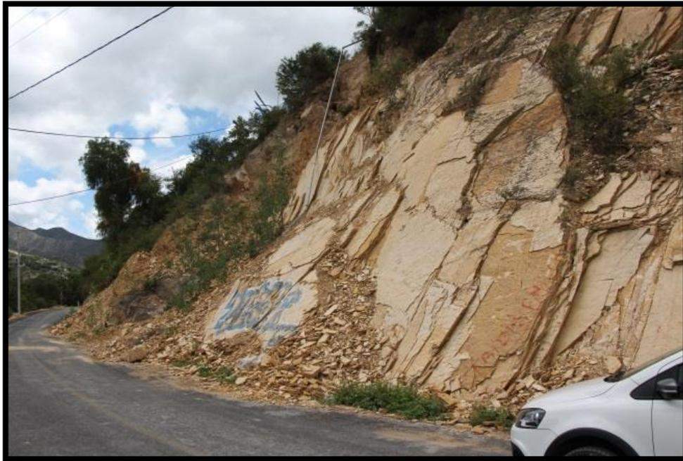
Foto Núm. 02 Derrumbe en la carretera a Colonia Nueva con coordenadas X=680618/Y=2046210. Se presenta en rocas de la Formación K(Ct) consistente de alternancia entre lutitas y limolitas metamorizadas, la disposición perpendicular al piso de los planos de estratificación de la roca favorecen su derrumbe.
