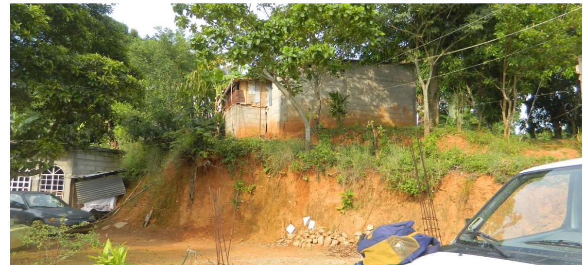
Fig. 33. Construcciones asentadas en zonas susceptibles a desprendimientos de suelo o deslizamientos.
