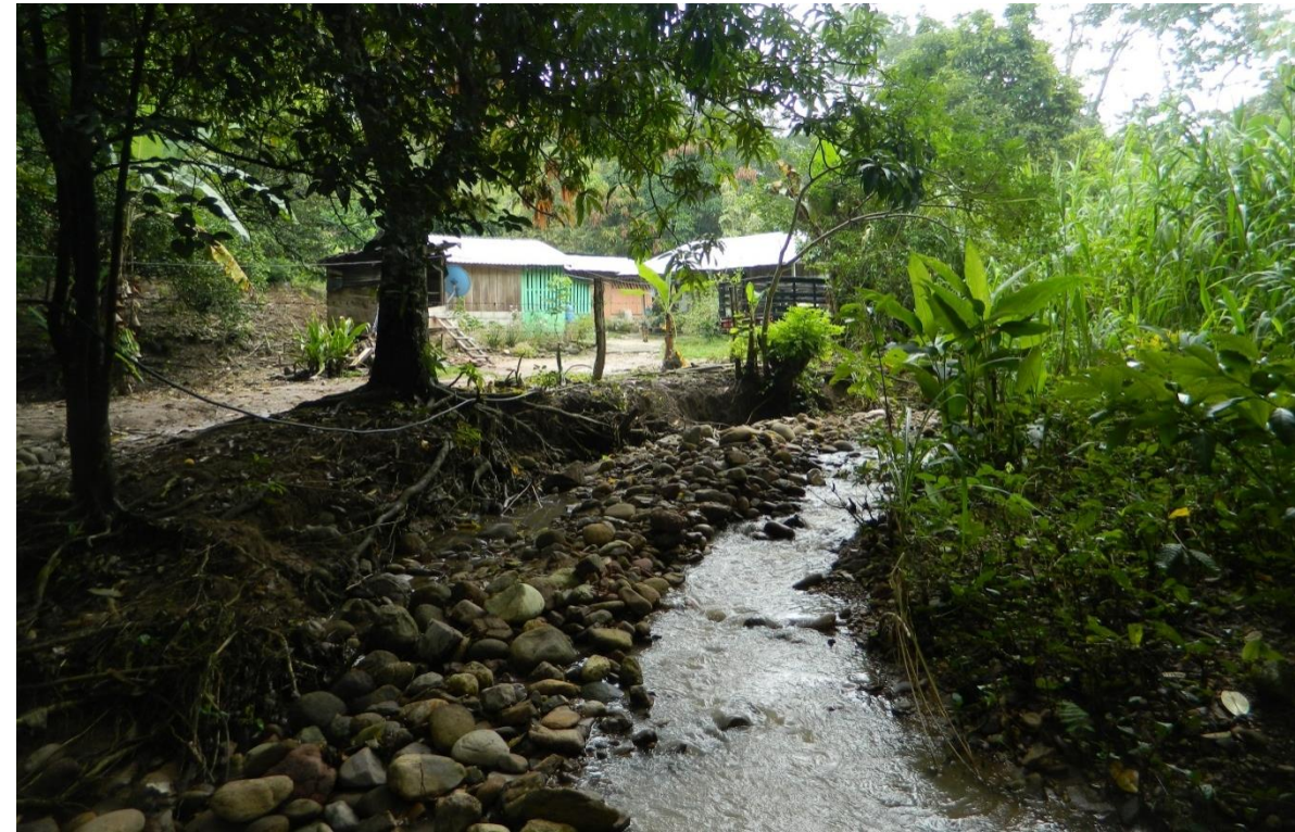
Fig. 40. Poblado Rancho Nuevo, las construcciones asentadas en la primer terraza de inundación, son inestables debido a que se encuentran en la zona de alto peligro por subsidencia.
