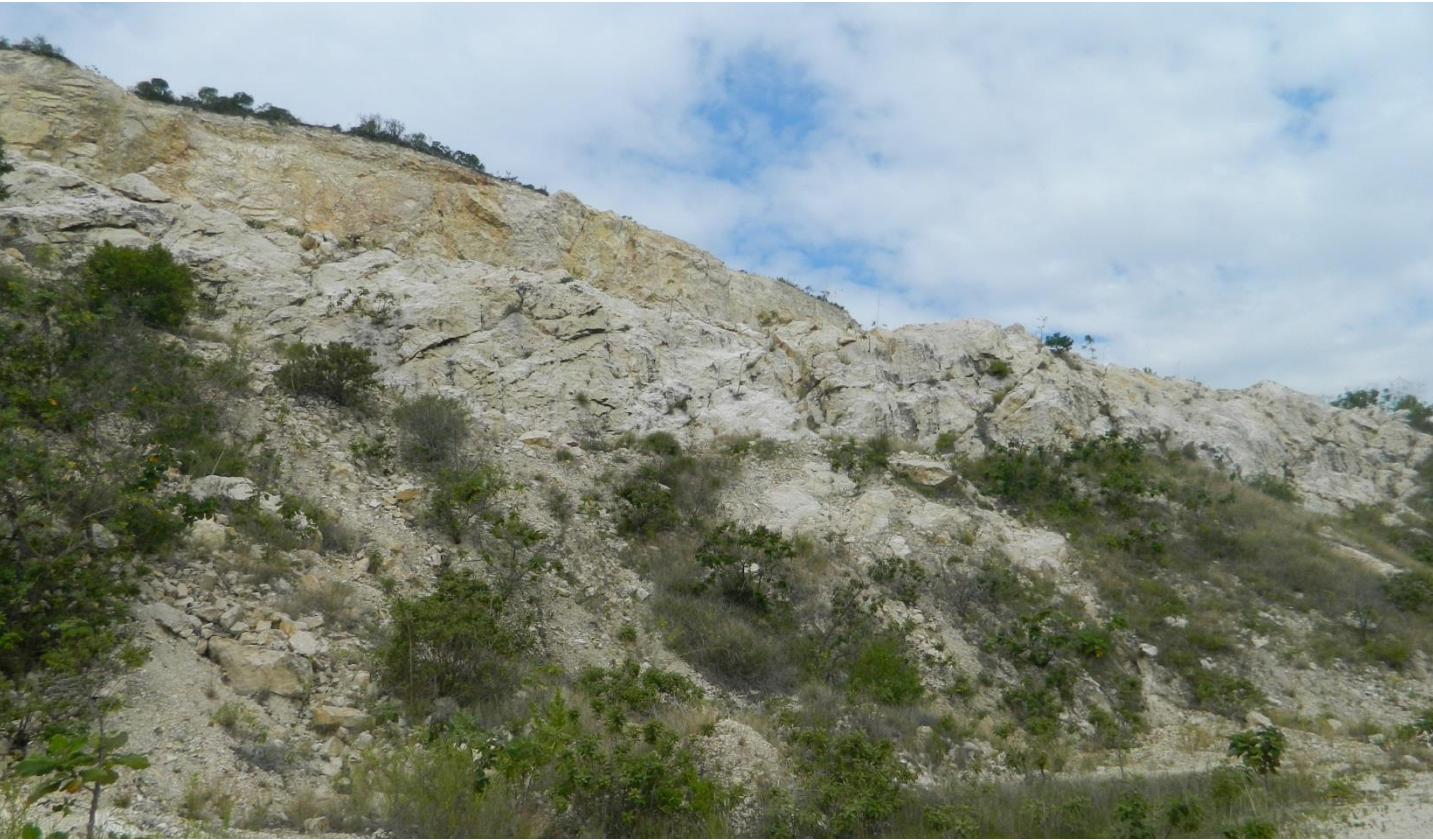
Figura 26. Banco de material en las laderas del cerro al sur del municipio. La roca sedimentaria clástica se muestra competente (sólida), pero con un gran desarrollo de grietas en su interior, lo que debilita sustancialmente la ladera.
