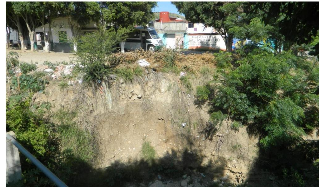
Foto. 11. Vertiente del cauce, en donde se observa la baja competencia del material, aluvión y sedimentos friables. La carga en peso que tiene la calle superior y las construcciones, incrementa la inestabilidad de la vertiente, además de que la erosión causada por el río en la base favorece que la vertiente sufra procesos de remoción.
