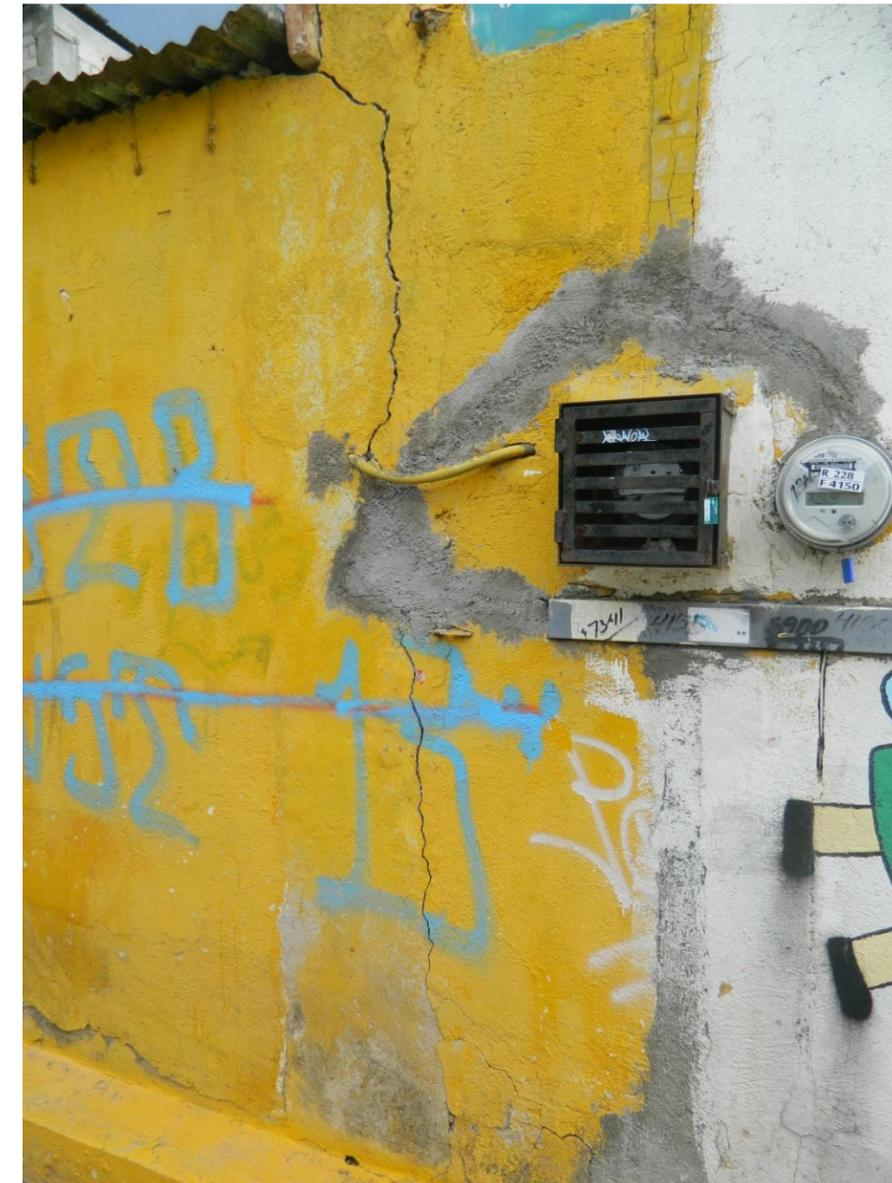
Foto 18. Fractura en un muro, cercano a los pilares. Nótese el incremento del espacio en la fractura en la parte superior. Esto indica que el sector izquierdo (en la foto) se está hundiendo, mientras que el lado derecho permanece sin movimiento aparente.
