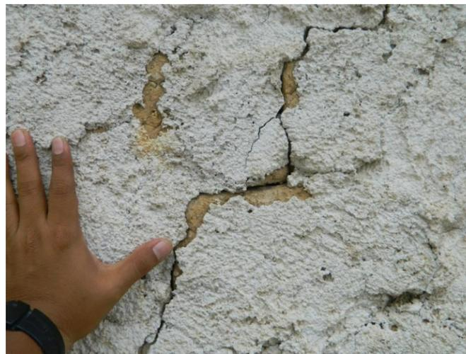
Foto 17. Acercamiento de un muro agrietado. Este tipo de disyunciones indican una extensión lateral del sustrato.
