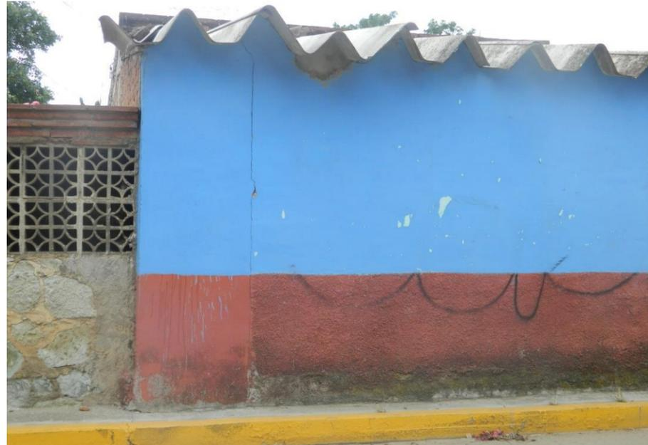
Foto 16. Fractura en una construcción, la desarticulación de los pilares con respecto a los muros es evidencia del movimiento irregular del terreno.
