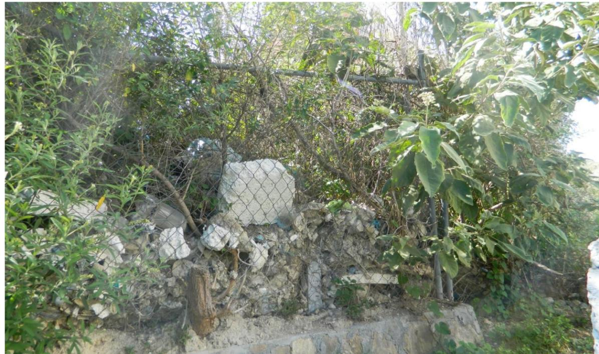
Fig. 22. Fotografía en donde se observa al menos medio metro de material atrapado en una maya ciclónica. Es evidente que la reja fue colocada de manera reciente y todo el material de acarreo que tiene encima es evidencia del potencial erosivo en el área.
