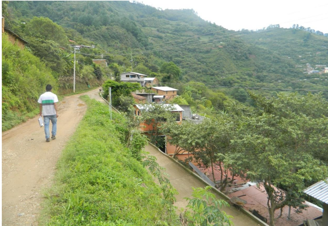
Foto. 12 Santa María Zoogochi, las casas se encuentran por debajo del camino en una pendiente cercana a la vertical, sobre la ladera, aquí el peligro de inestabilidad de ladera es alto.
