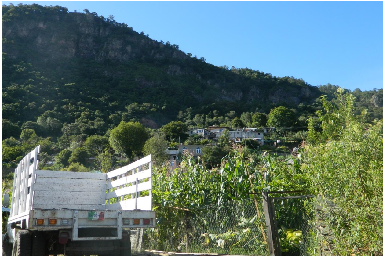
Foto. 15. Sector noroccidental de la cabecera municipal, cerca del mirador. Nótese que la ladera tiene una inclinación cercana a los 60°, el material aunque se muestra competente, es afectado por los factores exógenos por lo que la ladera se debilita y libera grandes bloques a lo largo del tiempo.
