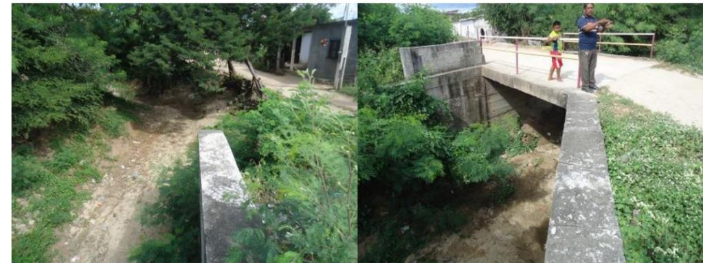
Punto 08 realizado en la calle Lázaro Cárdenas, se observó otra vivienda que es afectada en todas las temporadas de lluvia, ya que parte de la misma está construida sobre el lecho del pequeño afluente del arroyo Nizalubaa, lo cual evita que el agua fluya, asimismo los tubos que pasan debajo de la calle, no son los adecuados y provocan que el agua se acumule y se desborde, en algunos años el nivel de agua ha sido de 50 cm.
