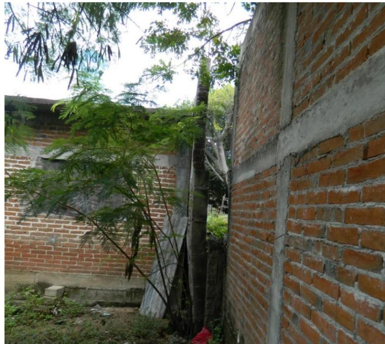
Fig. 16. Construcciones basculadas al grado de que una barda se encuentra recargada a la casa de la izquierda.
