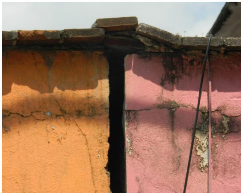
Fig. 17. Colonia Infonavit. Se muestra el movimiento diferencial del terreno que ha levantado y hundido dos casas, en un detalle del techo entre ellas.
