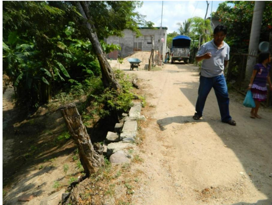
Fig. 22. Erosión del camino, por efecto fluvial, Cd. Ixtepec, Oaxaca.
