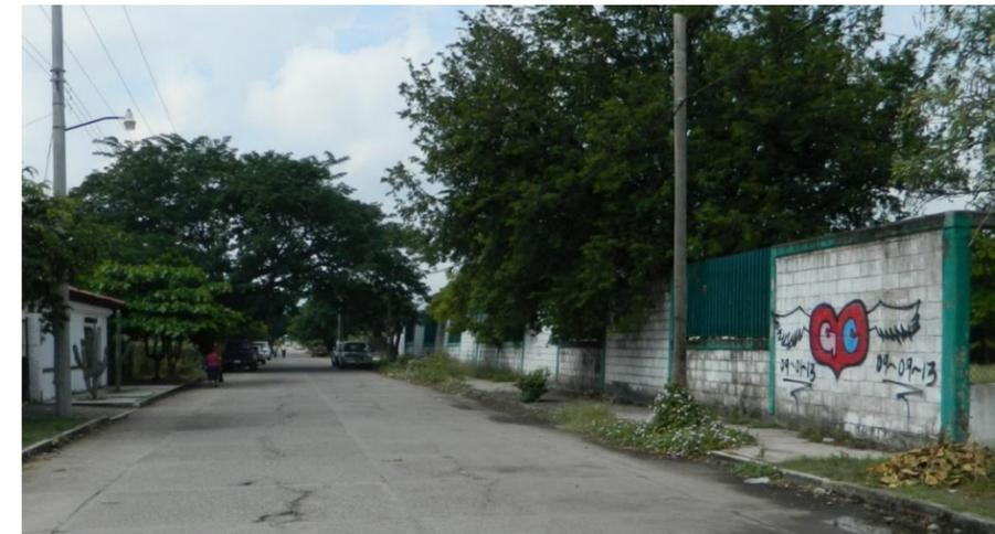
Fig. 20. Barda en Cd. Ixtepec. Nótese como se encuentra inclinada hacia la escuela, además de las grietas paralelas al interior de la calle.
