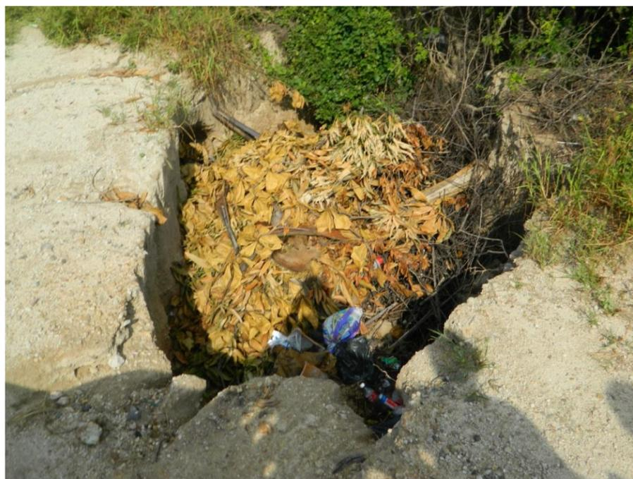
Fig. 11. Pequeño salto de cabecera que no rebasa los 50 cm en la localidad de Rancho Nuevo. Debido a la pendiente y el sustrato arenoso, la lluvia tiende a arrastrar parte del sustrato y remontar la pendiente, pero los flujos de arena y lodo afecta a la población ladera abajo, en forma de inundación.
