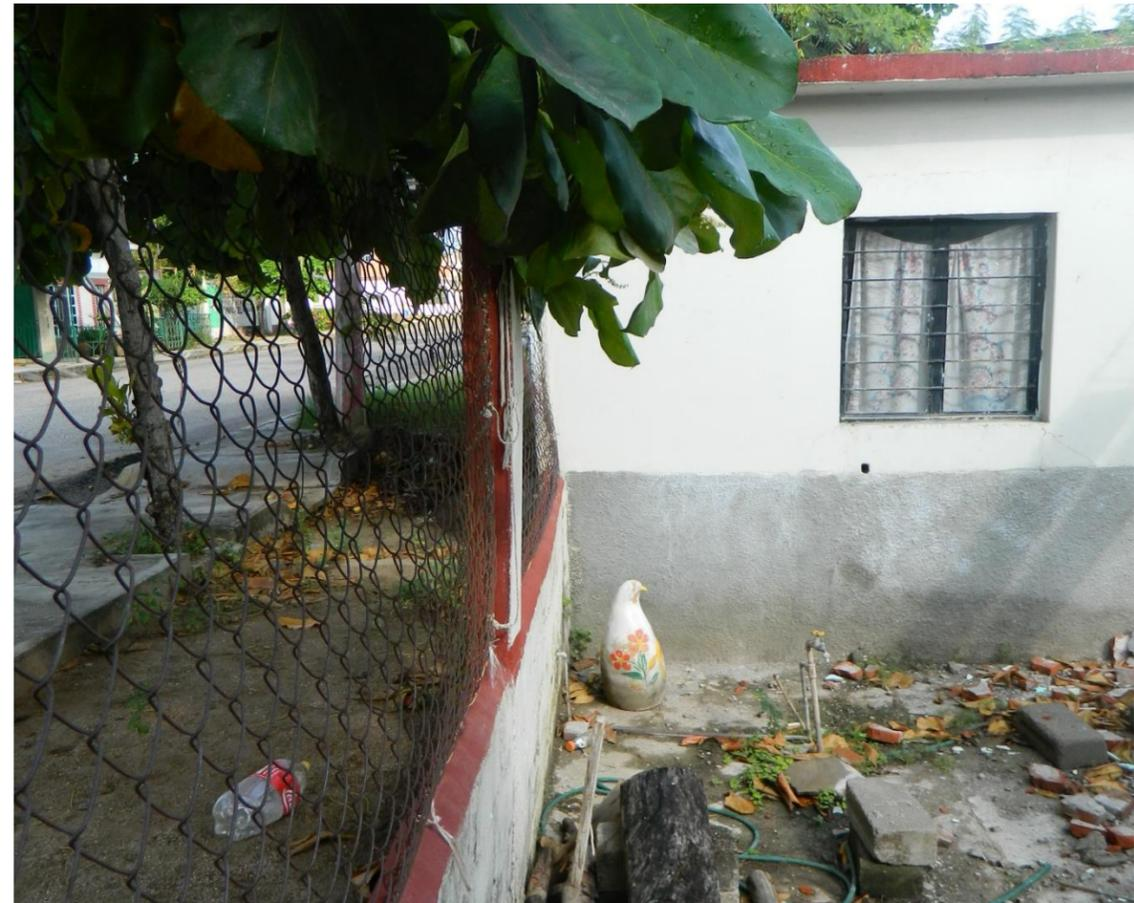
Fig. 18. Fotografía de una casa con señales de subsidencia, nótese la altura de la calle respecto al piso de la casa.
