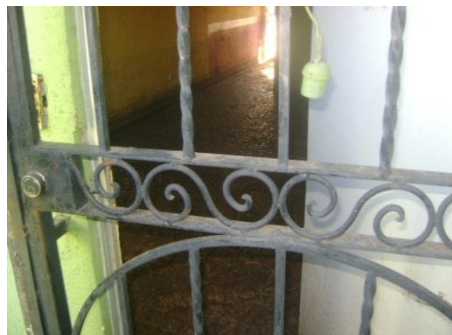
Riesgo Muy Alto
