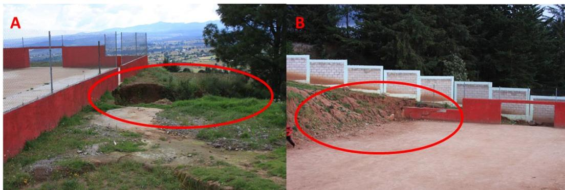
Figura 59. La foto A en La Guarda Las Canoas una grieta que daña directamente la estructura y B muestra el movimiento del terreno en San Miguel Chisda, la cancha dentro de la escuela en muy malas condiciones.
