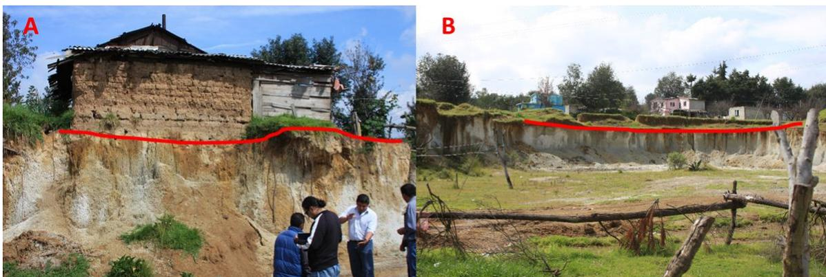
Figura 53. Foto A viviendas del Paraje Las Rosas, tipo precarias asentadas a orilla de depósitos muy deleznales; foto B viviendas a lo largo de una zona inestable.
