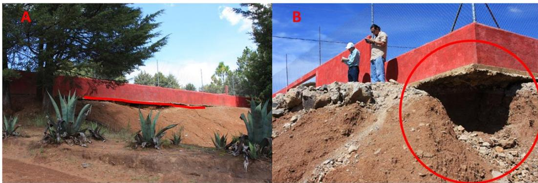
Figura 61. Rellenos de arcillas donde se construyeron canchas de futbol rápido y están bajo el proceso d erosión.
