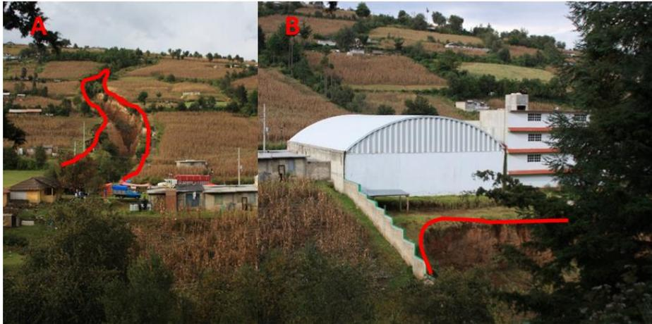
Figura 60. Barrio El Lijadero-La Mesa, se observan agrietamientos en la ladera y a pie de viviendas que pueden ser afectadas, en la foto B un auditorio cerca de una costra de deslizamiento.
