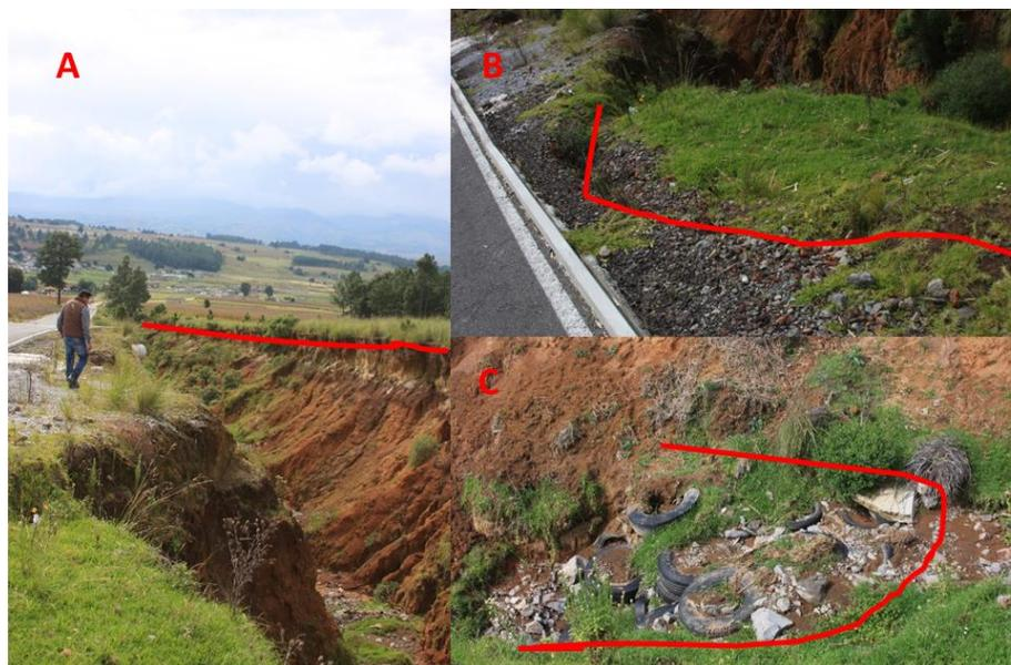
Figura 51. Foto A, Falla a la orilla de la carretera que se está desprendiendo y avanzando aguas abajo, en la foto B se notan bloques que están por caer y hacer más grande la grieta; la foto C llantas para contener la erosión y el desprendimiento del terreno.
