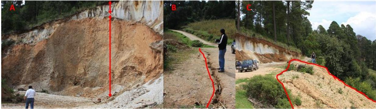
Figura 56. Foto A ladera del Río La Cañada con alto grado de peligro producto de un derrumbe en el año 2010, en la foto B se pueden apreciar grietas de desecación que pueden provocar derrumbes aguas debajo del camino de terracería y foto C escombros del derrumbe que se pueden volver a reactivar.
