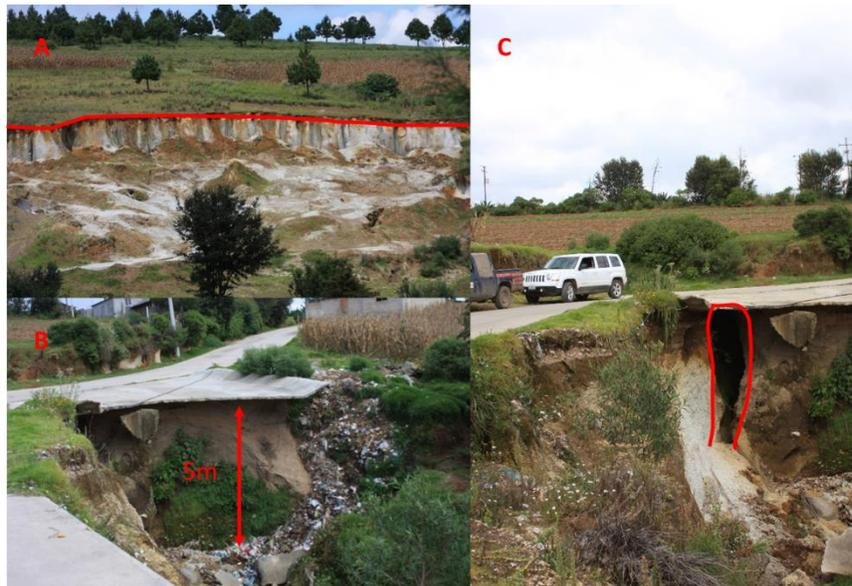
Figura 57. Foto A ladera derrumbada con alto grado de peligro, en la foto B se pueden apreciar un derrumbe de un tramo de avenida y foto C se aprecia un grieta que puede provocar el desprendimiento total del asfalto cerca del poblado conocido como El Cable.
