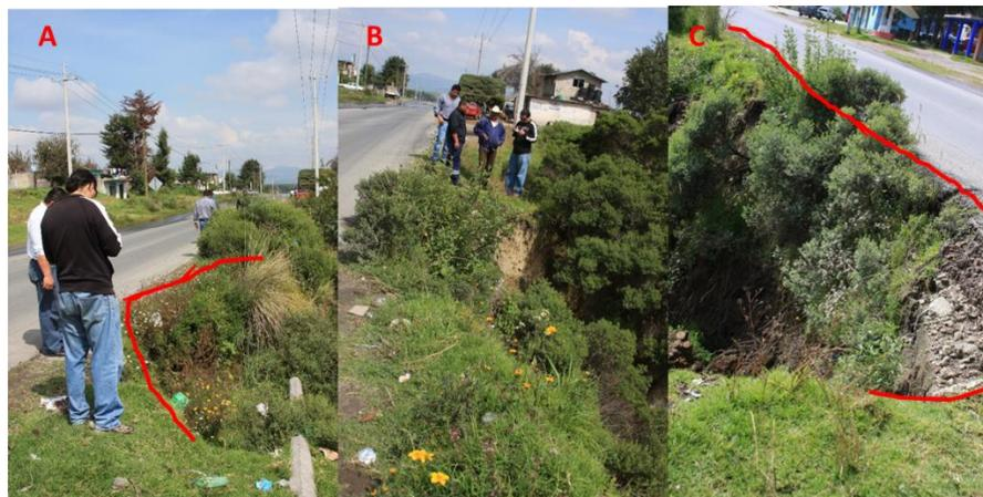
Figura 55. Foto A Carretera estatal libre a la altura de Paraje Las Rosas, derrumbes en las laderas del corte de carretera, en la foto B y C se puede apreciar la costra del derrumbe, de peligro para los automovilistas y transporte pesado por las vibraciones que generan.
