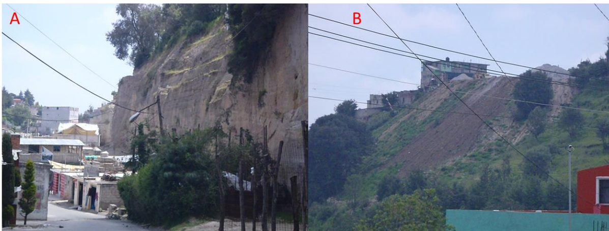
Figura 44. Viviendas ubicadas debajo de un escarpe pronunciado en una ladera con alto grado de peligro, en la foto B se puede apreciar los deslizamientos generados por rellenos de materiales.
