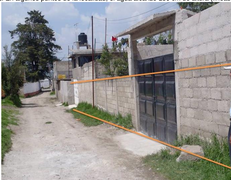
Figura 92. En algunos puntos de la localidad, el agua alcanzó 180 cm de altura (líneas naranjas)
