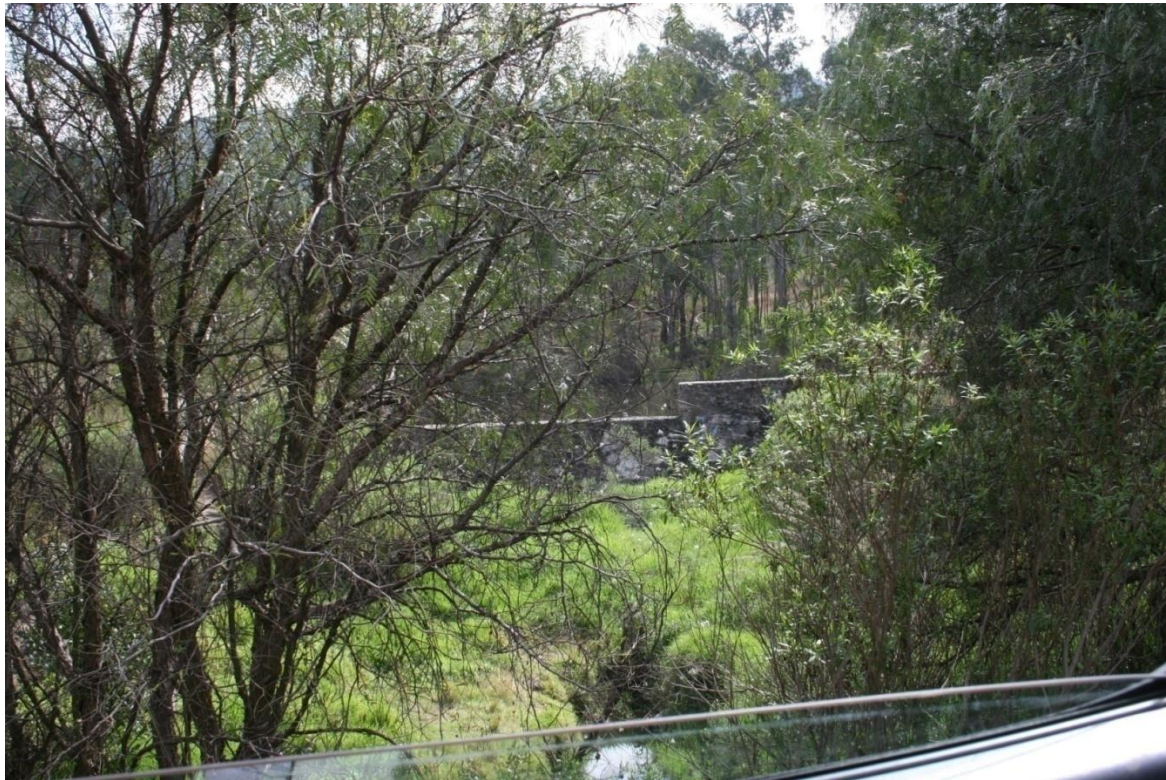
Presas de gavión para el control de avenidas en los escurrimientos superficiales de la Sierra de Guadalupe (Arroyo La Huerta)
