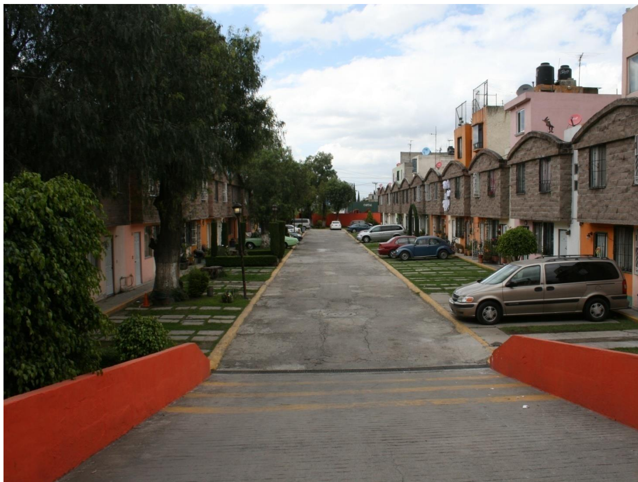
Zonas habitacionales en riesgo de inundaciones: Vialidad José López Portillo y Calle Laureles
