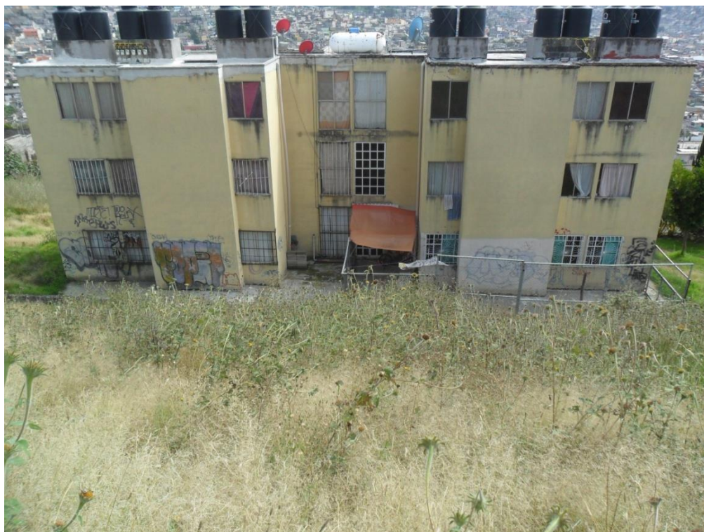
Colonia Tulipanes: Amenaza de deslizamientos de tierra y derrumbes en terrenos afectados por la Falla La Quebrada.
