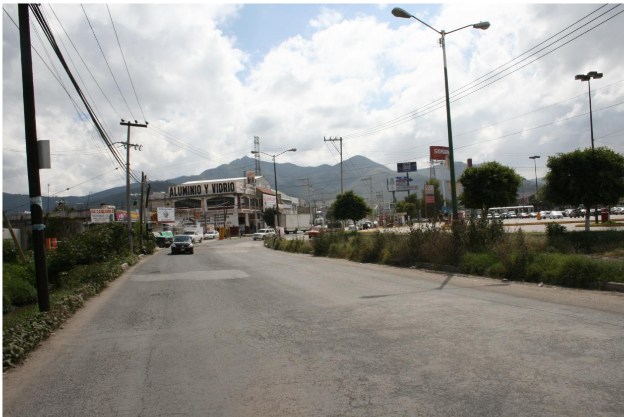
Zona inundable en la calle Ex- Hacienda Los Portales, Colonia Jardines de Tultitlán.
