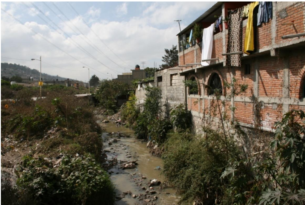
Zonas en peligro por avenidas súbitas en las márgenes del Canal Las Cruces: colonias El Tesoro y Santa María de Guadalupe.
