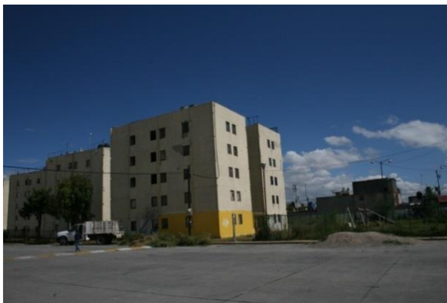
Inclinación de edificios por hundimiento en el Fraccionamiento Jardines San Pablo
