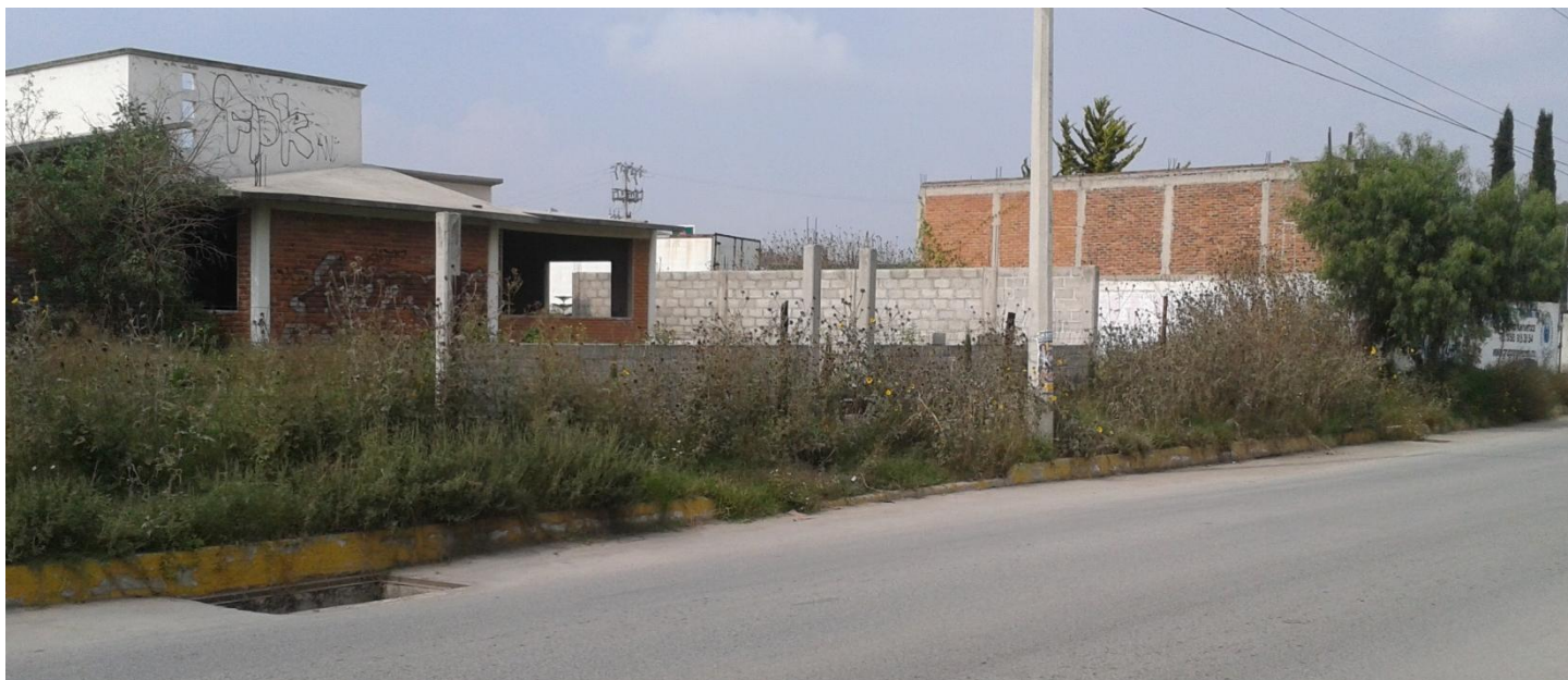
Ilustración 22. Zona baja inundable en Av. Miguel Hidalgo.
