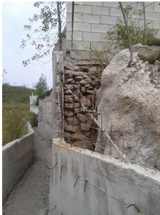
Relleno de material.
