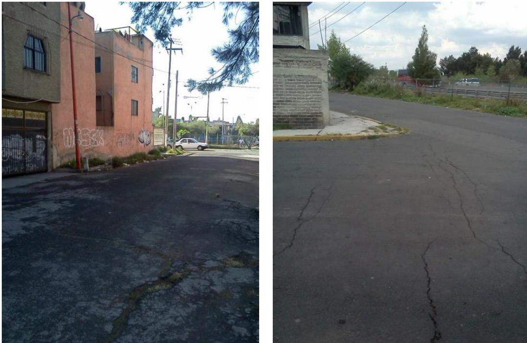
Figura 5.27 Hundimiento y fracturamiento del subsuelo y sus efectos en las viviendas y vialidades, izq. Calle Valle de Toluca Colonia Valle de Aragón 3ª Sección y der. Av. Canal de la Draga frente al Circuito Exterior Mexiquense en la Colonia Sagitario. Fuente: Elaboración propia.
