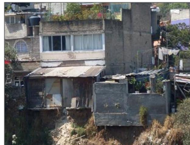
**Fig. 1.3. Viviendas con los cimientos en posición de cantiléver.**
