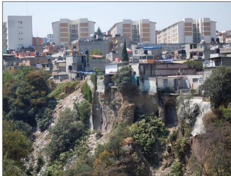
**Fig. 1.1. Aspecto de los taludes y de los cortes sin obra adecuada de estabilización. Barranca Santa Rita.**
