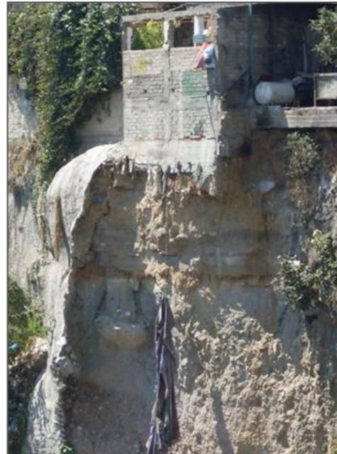
**Fig. 1.2. La erosión remontante paulatinamente va afectando la seguridad de las viviendas.**
