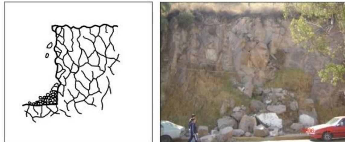
Figura 5.1.4.8.- En zonas brechadas ya sea por fallas o por el emplazamiento de coladas de lava, es común el desprendimiento de rocas.
