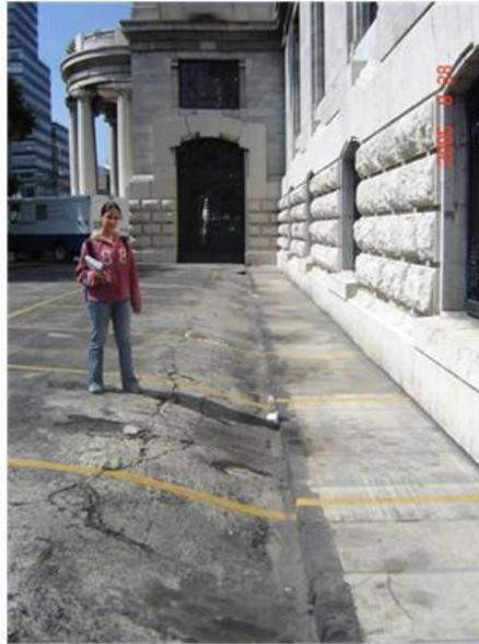
**Figura 5.5.4** Escalonamientos y grietas en la carpeta asfáltica del estacionamiento del palacio de Bellas Artes debido al hundimiento que presenta la estructura.
