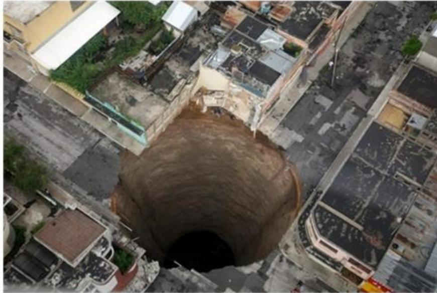
**Figura 5.5.3** Hundimiento ocurrido el 30 de Mayo de 2010 en la Zona II de Guatemala. El socavón tiene 35 m de diámetro por 50 de profundidad y se asoció con litologías deleznables y deficiencias en la red hidrosanitaria.
