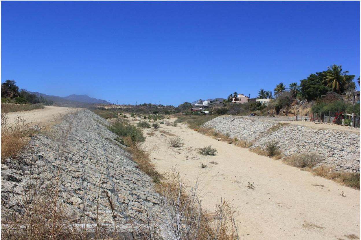
**Figura 7.2.14.** El arroyo El Aguajito muestra obras de contención de avenidas en diferentes secciones, mas no continuas. Las mismas muestran algunas fallas en su mantenimiento y azolve en gran parte del lecho. La línea de base final, es poco clara, dada los procesos de urbanización.
