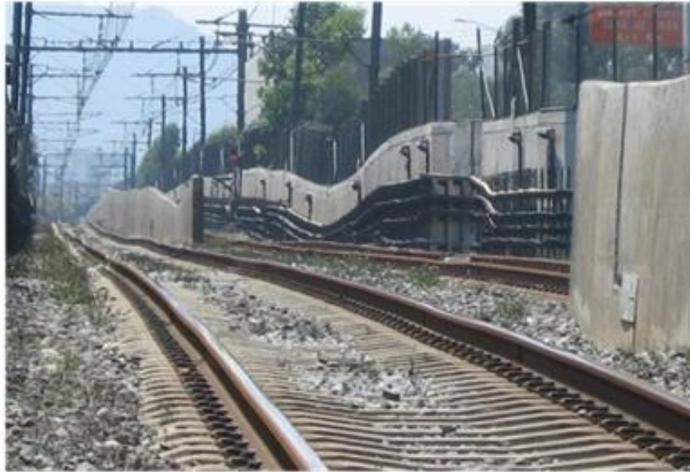
**Figura 5.5.6** Las heterogeneidades del terreno así como de los factores antrópicos, generan asentamientos diferenciales que tienen como efecto deformaciones en las construcciones. Aspecto de la línea A del metro de la Ciudad de México, afectada por asentamientos diferenciales.
