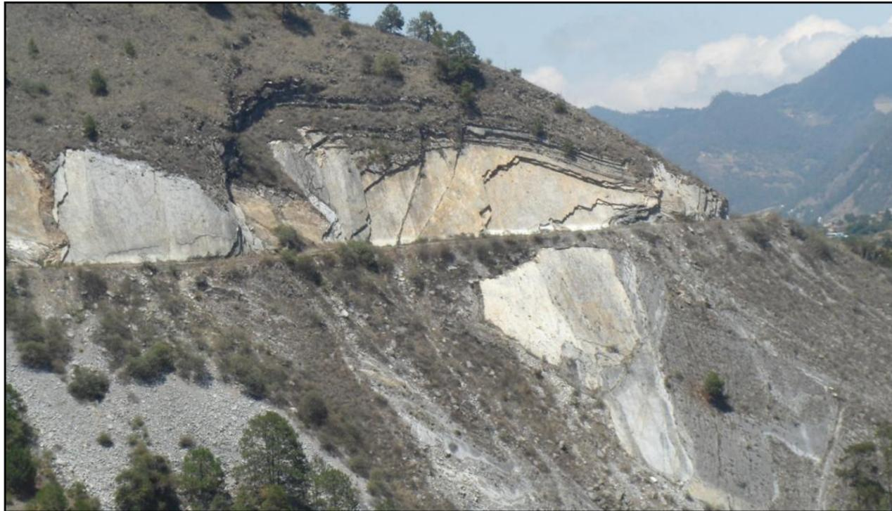
Ilustración 41. Deslizamiento planar de rocas, de gran dimensión, las capas miden más de 30 cm de ancho. Este tipo de proceso se encuentra en la mayoría de las carreteras del Municipio, sin embargo este es el más grande que se detectó.
