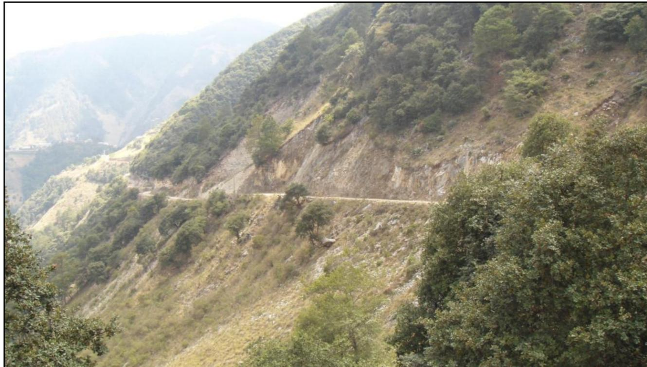
Ilustración 35. Deslizamiento sobre la carretera que va de Ometépetl a Xalpuente.
