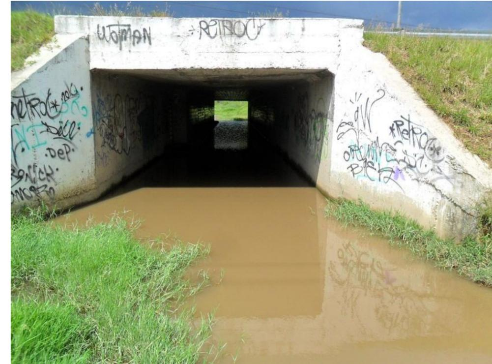
Ilustración 43. Paso a desnivel anegado bajo la autopista.
