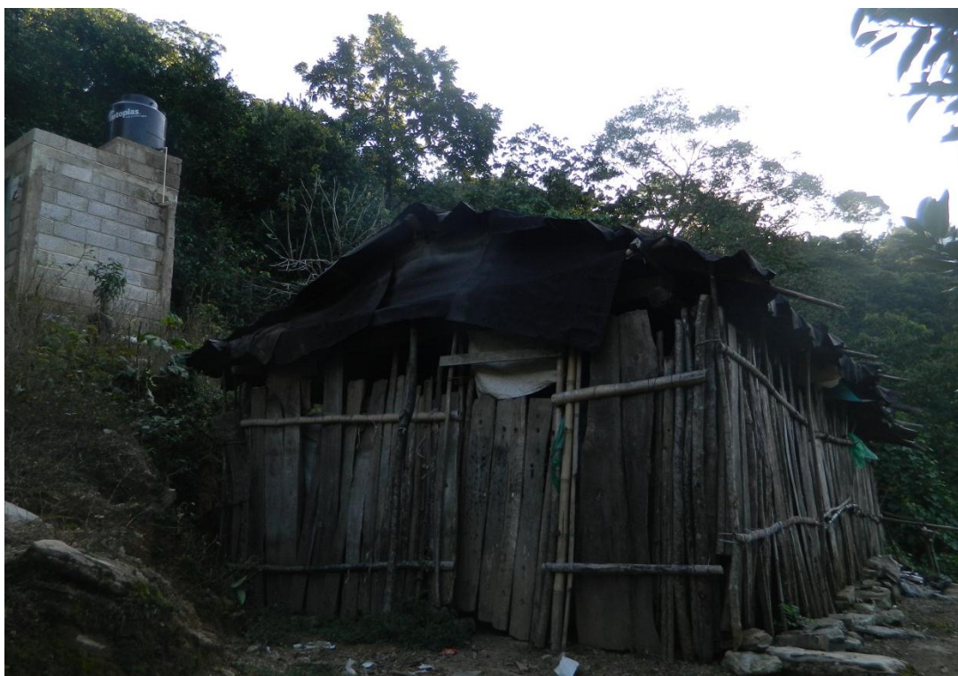
Figura 69. Fotografía en donde se muestran algunas casas que se encuentran en las terrazas fluviales en la comunidad Cinco de Mayo. Estas resisten claramente a un movimiento sísmico, pero su vulnerabilidad se incrementa sustancialmente en caso de derrumbe de bloques o inundaciones.
