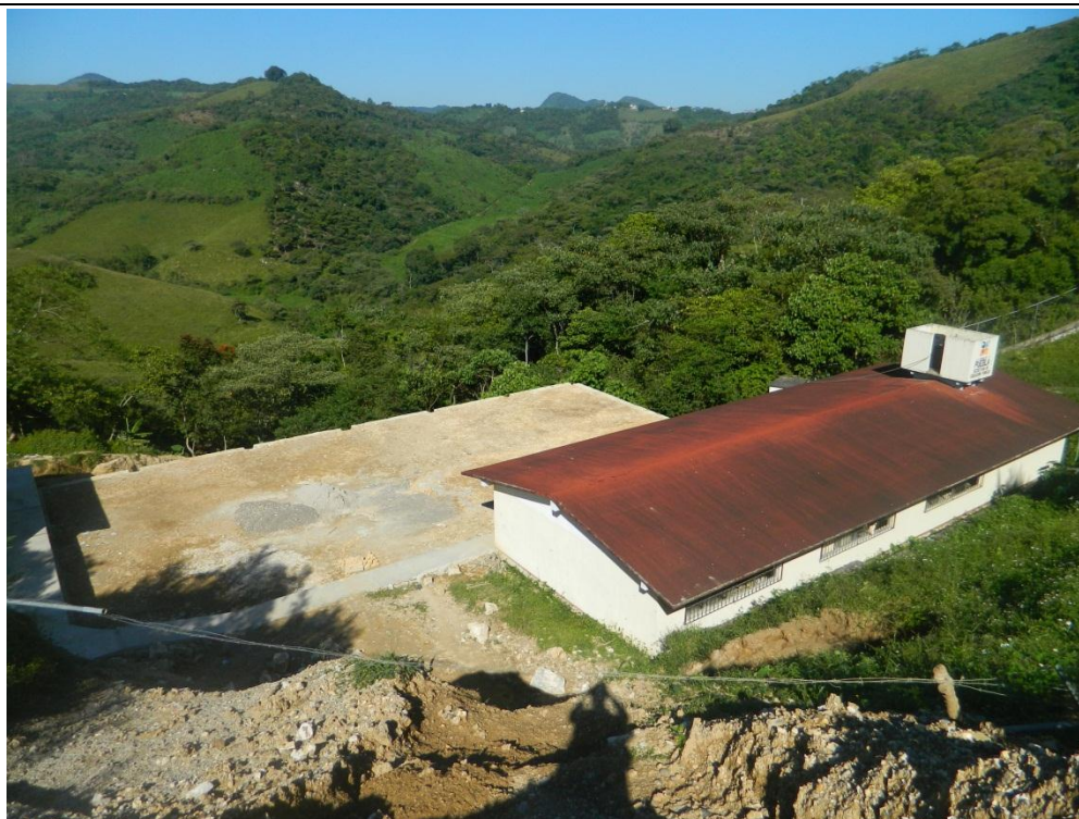
Figura 84. Bachiller de Ozelonacxtla. Las obras realizadas en este antiguo deslizamiento (canalización periférica de los arroyos circundantes, muros de contención) son insuficientes y el depósito continuara su asentamiento, acelerado por la erosión en la base del río.
