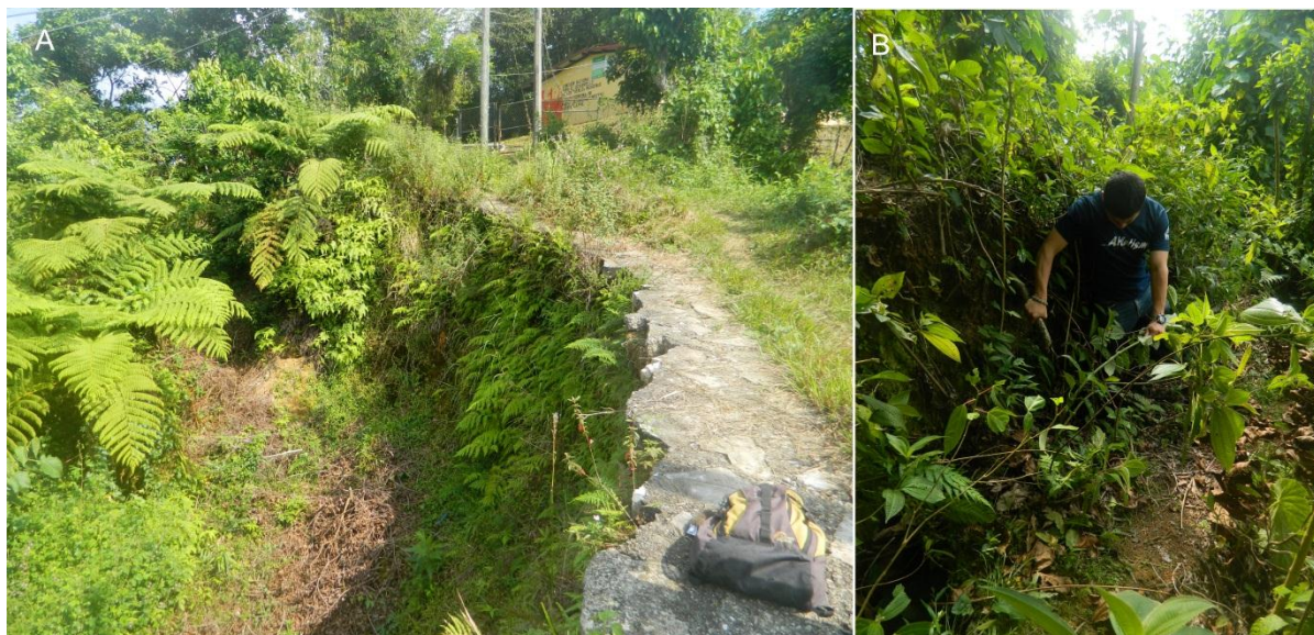
Figura 32. Deslizamiento rotacional en las inmediaciones del Centro de desarrollo de Comunidades Indígenas (CDI), la corona de deslizamiento movió parte del camino (A), también se observa en la parte inferior el primer escalón del deslizamiento. En la foto de la derecha se observa la profundidad de la grieta superior en contacto con el escarpe de deslizamiento y el primer escalón del depósito.
