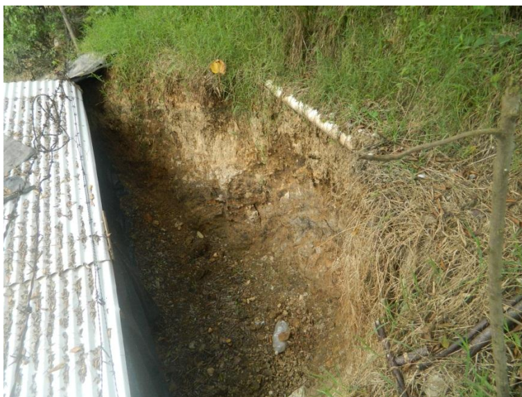
Figura 74. Cabecera de un pequeño deslizamiento favorecido por las lluvias extraordinarias y por efecto de alteración antrópica en la Colonia El Potrero.
