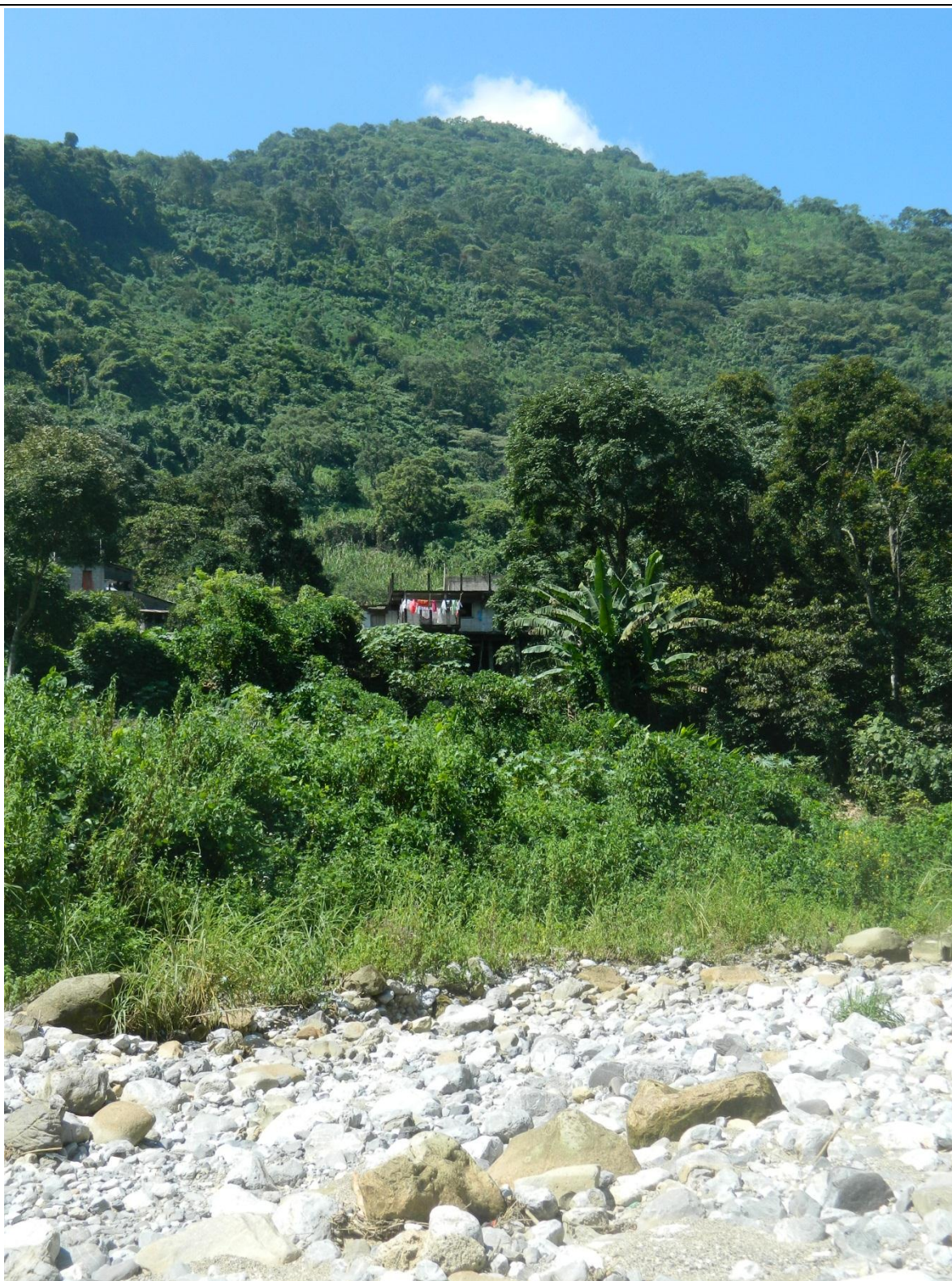
Figura 43. Fotografía en donde se muestran viviendas emplazadas en la terraza más alta. Nótese la cantidad y tamaño de los bloques que constituyen el cauce. Elaboración propia con base en información de INEGI
