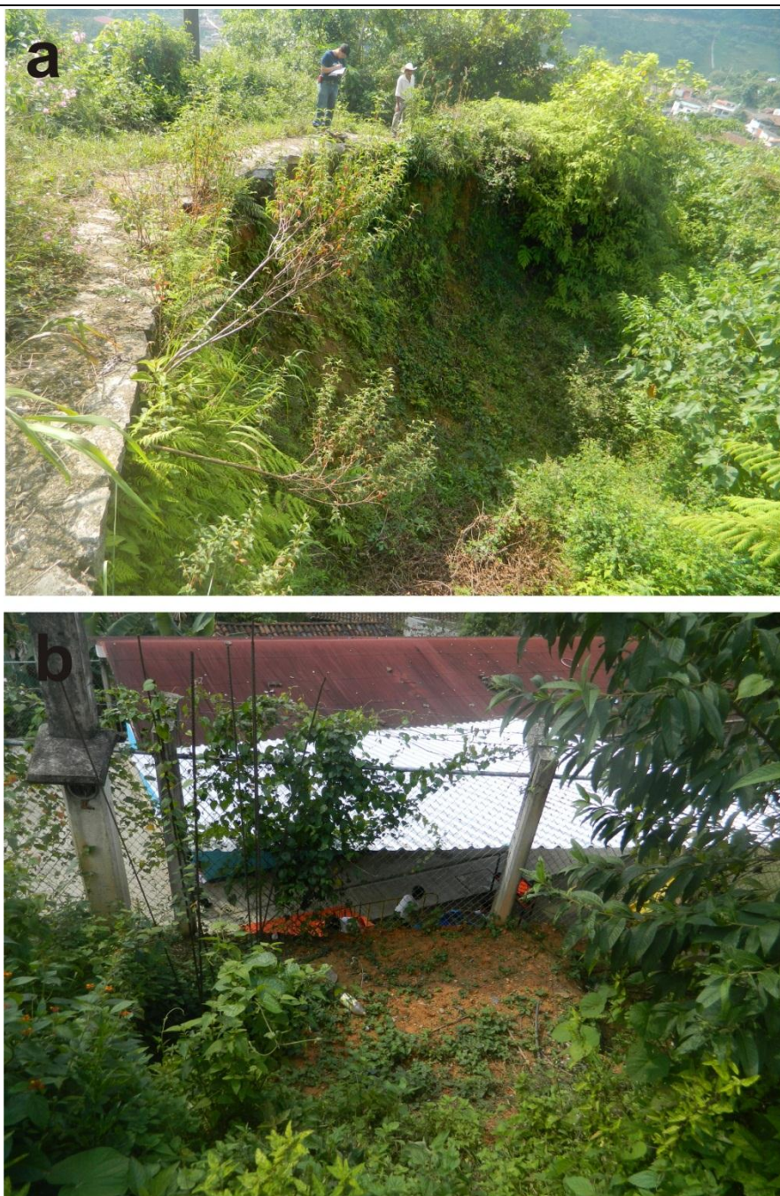
Figura 83. a) Deslizamiento que afecto el camino al CDI. Esta ladera a sido afectada por varios procesos de remoción en masa. Este deslizamiento tapo un camino en donde, por debajo del mismo se encuentra una escuela, en la foto "b" se muestra que la reja superior detuvo parcialmente los escombros. En caso de que se reactive puede sepultar parcialmente la escuela. Es necesario estabilizar la ladera superior del camino y la ladera inferior para reducir las futuras remociones.
