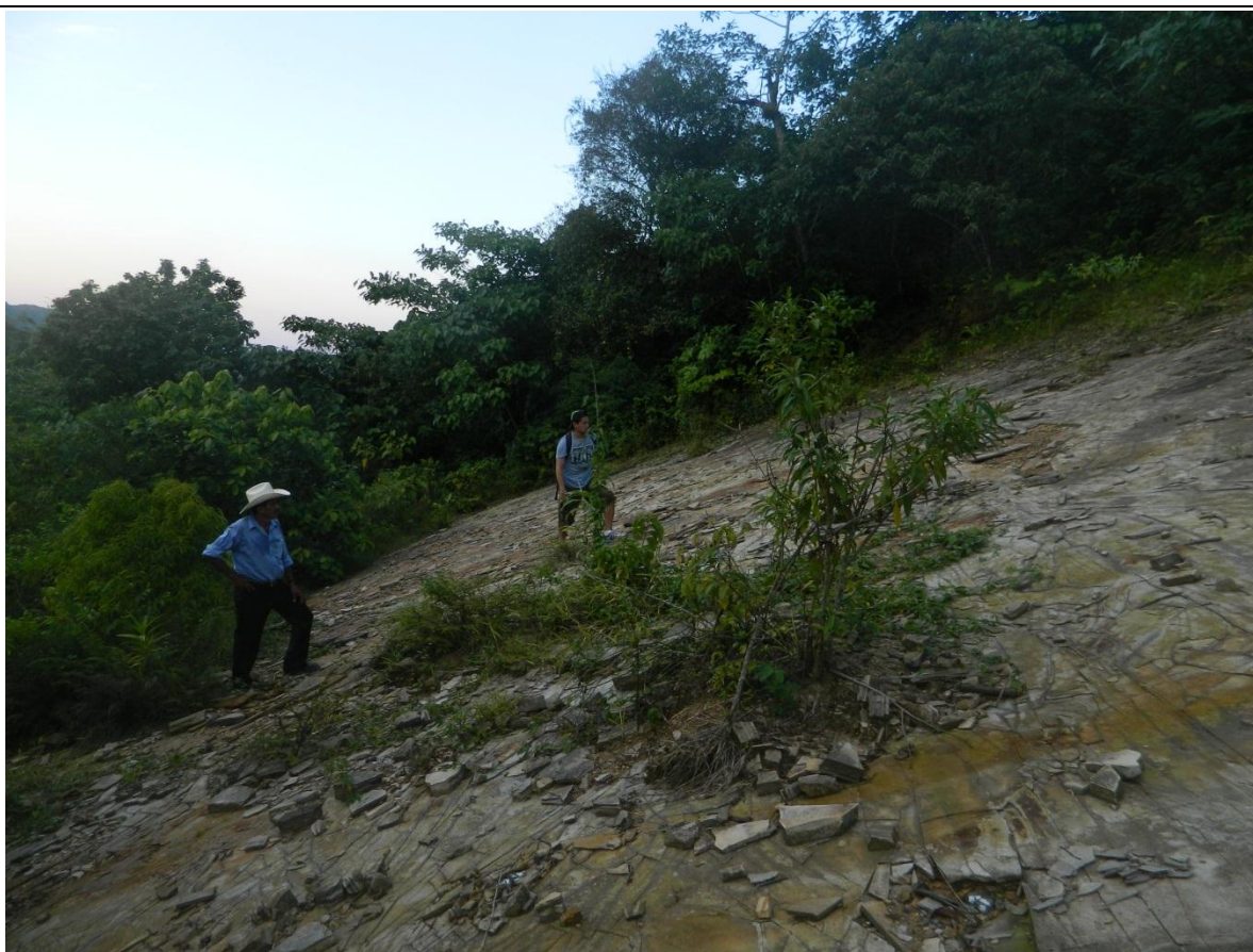
Figura 45. Fotografía en donde se muestra la superficie de deslizamiento que ocurrió en la parte alta de la comunidad de Cinco de Mayo. Nótese como la superficie es prácticamente plana y paralela a la inclinación de las capas.
