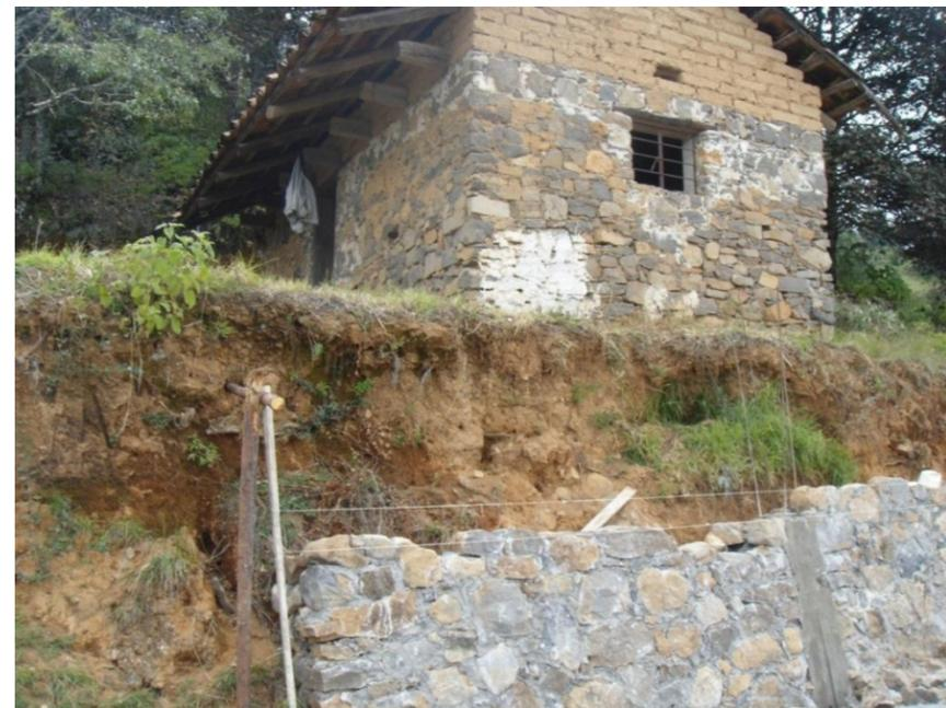
Ilustración 54. Construcción de muro de retención para la protección de una casa en la localidad Tlachiapa.
