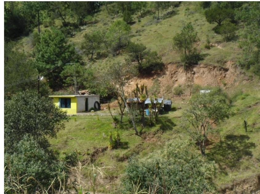
Ilustración 47. Casa en riesgo por deslizamiento de suelo en la localidad Atexcac.
