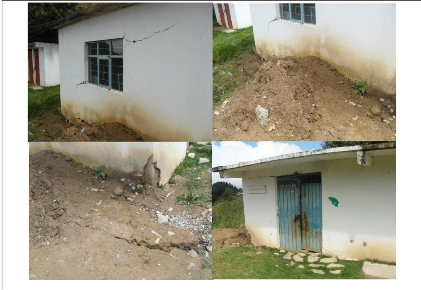
Ilustración 51. Casa de salud afectada por deslizamiento provocado por las intensas lluvias en 1999, se pueden observar las grietas de tensión que indican que el proceso se encuentra activo.
