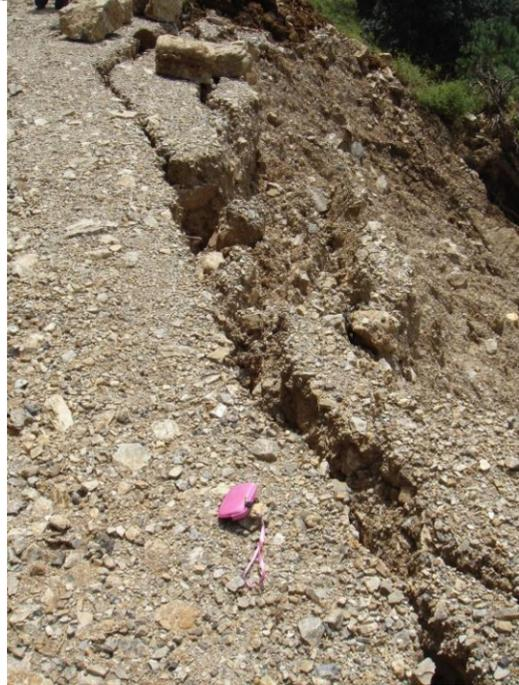
Ilustración 45. Deslizamiento en la localidad Ilotepec; se observa en la base parte del depósito con línea punteada (bloques), y grietas de tensión que indican que el proceso está activo y va en aumento. Los bloques cubren parte del camino.
