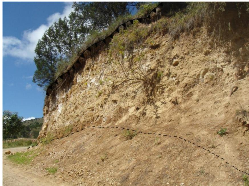
Ilustración 48. Deslizamiento sobre el camino en la localidad Atexcac, se puede observar la corona de desprendimiento y el depósito en la base.
