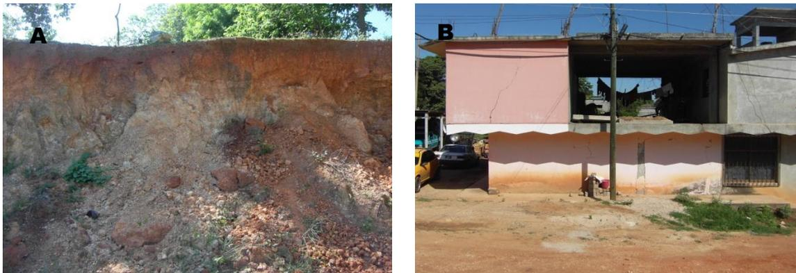
*Imagen V.1.2. (A) Tipos de suelos arcillosos típicos del municipio; (B) en la planta baja se ve el daño como consecuencia de este tipo de suelo.*
