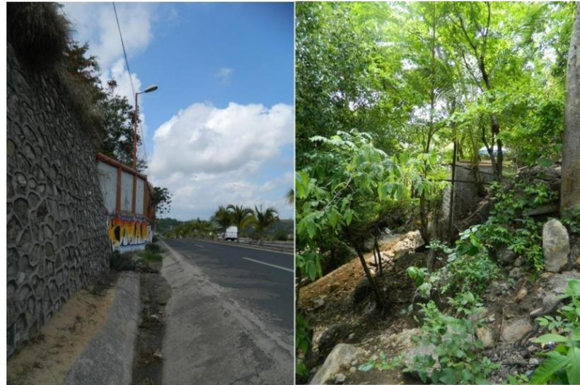
Fig. 32. Fotografías de laderas propensas a presentar procesos gravitacionales. Carretera costera en Puerto Escondido, se observa que el muro de contención se ha deformado hacia la carretera (foto izquierda). Construcciones cercanas al valle fluvial en las inmediaciones de San Pedro Mixtepec (foto derecha).
