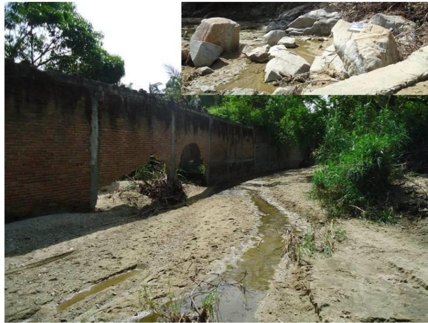
Figura 53. Barda en cauce del río Regadío. Arriba a la derecha rocas de alto tonelaje arrastradas por la corriente a 20m de la barda.
