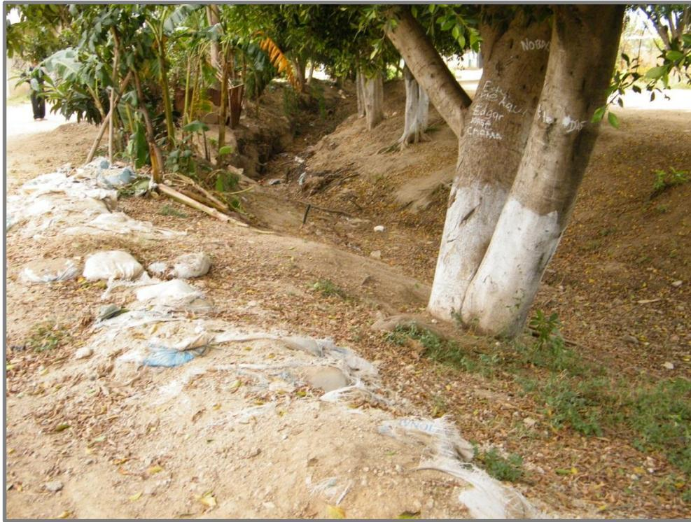
**Fig. 18. Medidas improvisadas para evitar inundación en las viviendas aledañas al cauce del arroyo.**
