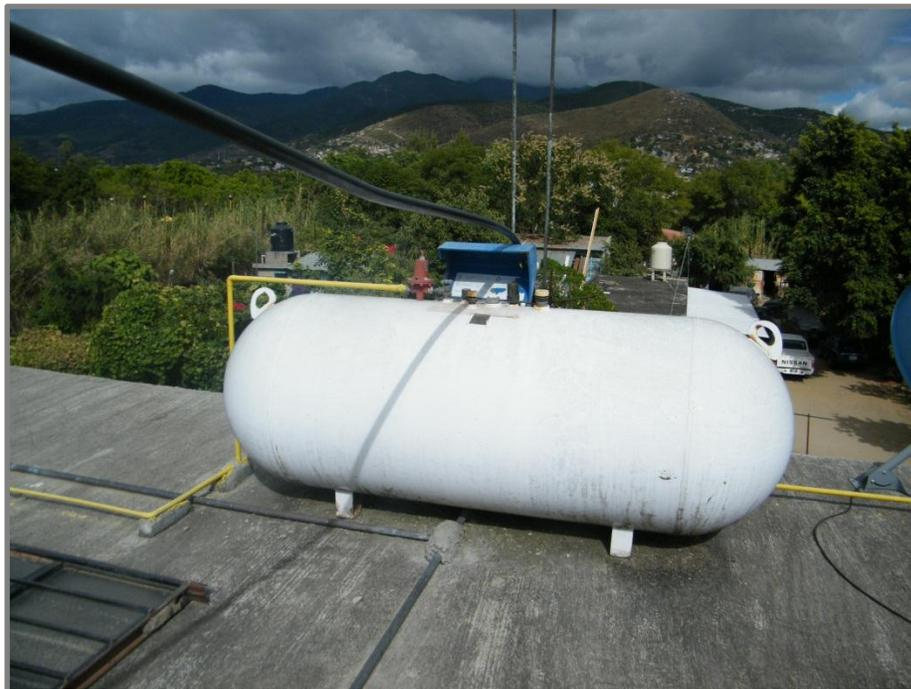
**Fig. 37. Tanque estacionario de 1000 litros en panadería cerca del centro.**
