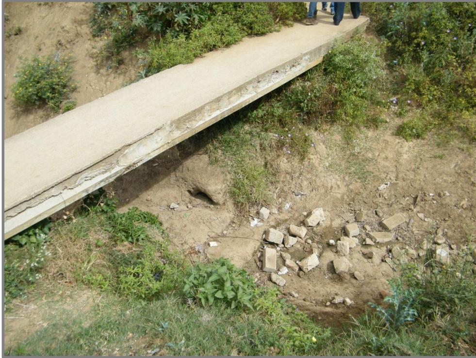
**Fig. 20. Puente provisional sobre el cauce del arroyo chiquito.**
