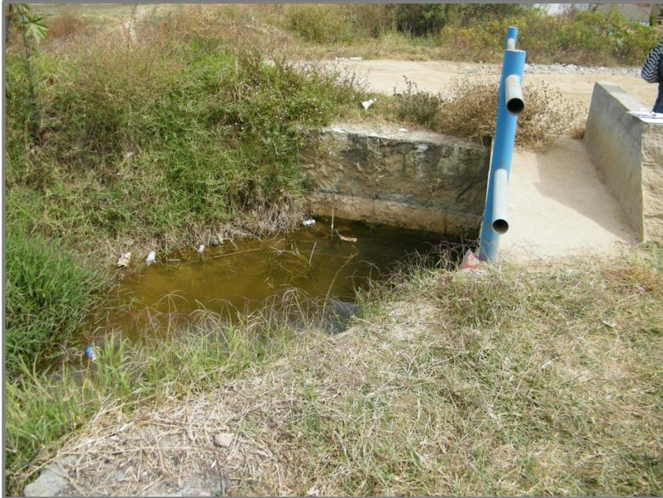
**Fig. 16. Estancamiento de agua puente de paso vehicular y peatonal.**
