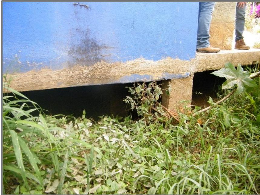
**Fig. 40. Vivienda afectada por el cauce natural del arroyo pluvial.**
