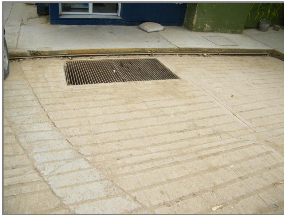
**Fig. 11. Alcantarillas insuficientes para drenar el agua en zonas inundables.**
