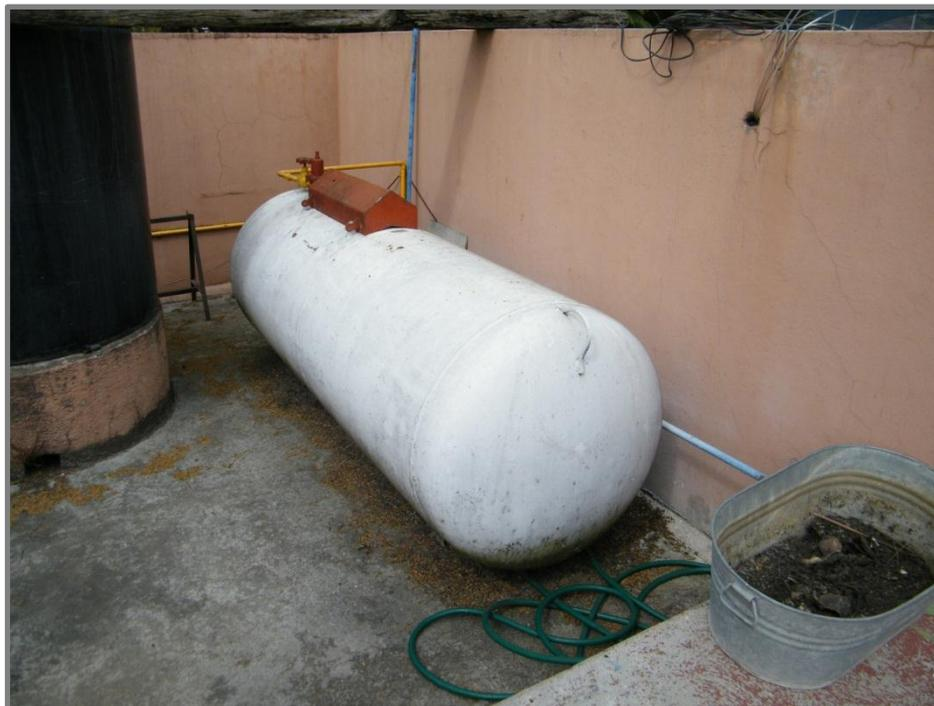
**Fig. 35. Tanque estacionario de 1000 litros en la panadería San Jacinto.**
