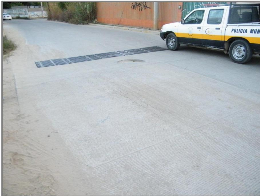
**Fig. 53. Zona de inundación. Las coladeras son insuficientes para contener la cantidad de agua.**
