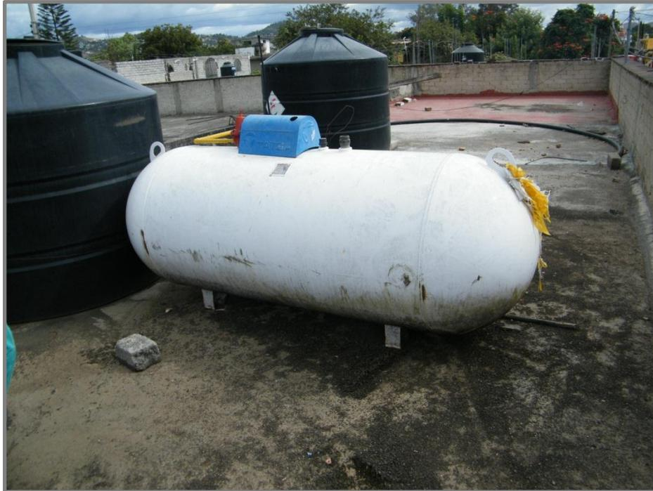
**Fig. 36. Tanque estacionario de 1000 litros en tortillería.**
