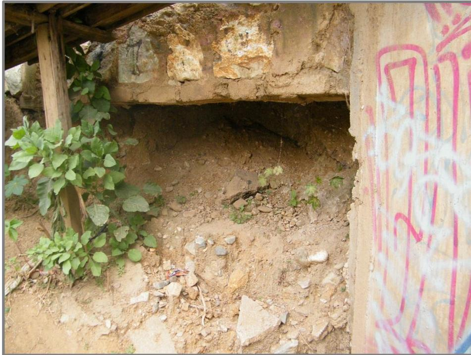
**Fig. 44. Erosión de tierra debajo del puente por aumento de volumen del río Sapo.**
