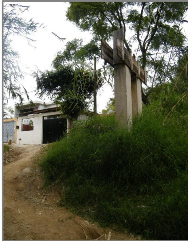
**Fig. 42. Suspensión de construcción de puente debido a la inestabilidad por inundaciones.**
