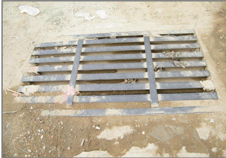
**Fig. 12. Alcantarillas sin mantenimiento.**
