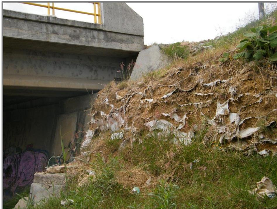
**Fig. 43. Medidas para evitar el socavamiento de la tierra por el aumento del volumen del río Sapo.**
